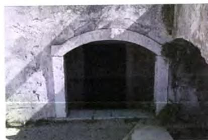
fig. 15 – Foto da autora – Pormenor da entrada cortada pela elevação da cota do terreno
