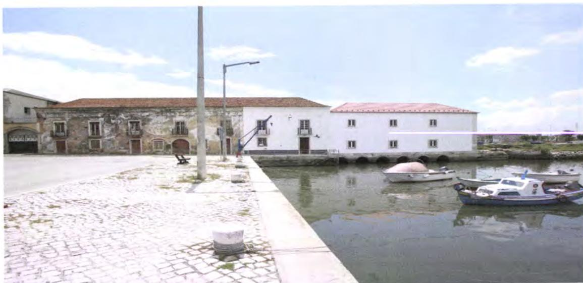
*fig. 12* – Foto da Autora – Na recente intervenção de requalificação do moinho de maré foi anexada uma parcela do palacete mas só ao nível do R/c, embora a pintura até ao telhado dê a entender a vinculação de todo o bloco.
