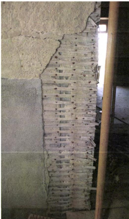
*fig. 29* – Foto da autora – Paredes interiores em tabique.
