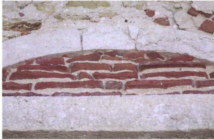
*fig. 25* – Foto da autora - Paredes exteriores em alvenaria de pedra e tijolo de «burro».
