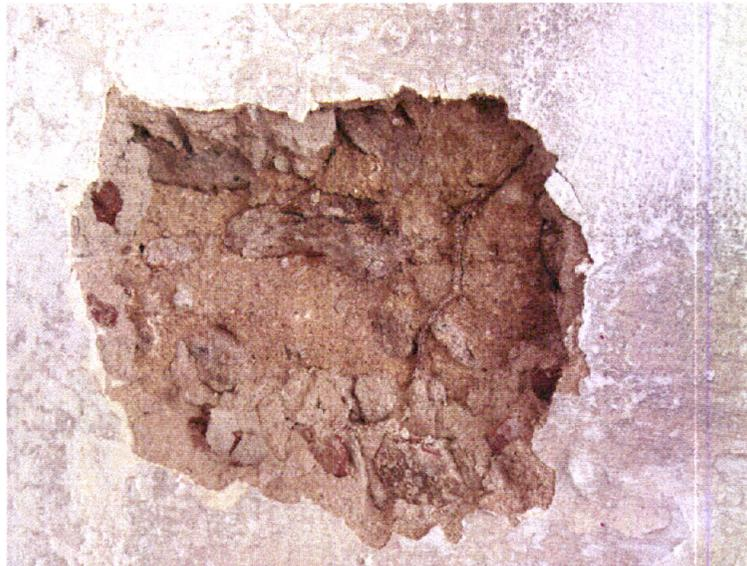
Foto 5.2. – Convento de S. Francisco em Montemor-o-Novo: alvenaria ordinária no alçado interior sul do nártice. .
