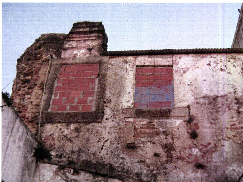
Foto 5.10.- Convento de S. Francisco em Montemor-o-Novo: alvenaria de tijolo no "miolo" de panos de alvenaria de pedra.
