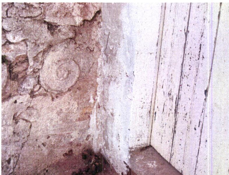
Foto 5.8.- Convento de S. Francisco em Montemor-o-Novo: granito trabalhado, reaproveitado de construção anterior.
