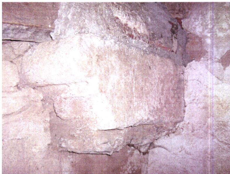
Foto 5.7.- Convento de S. Francisco em Montemor-o-Novo: bloco de granito trabalhado, aproveitado de anterior construção.
