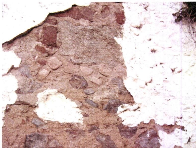
Foto 5.5. – Convento de S. Francisco em Montemor-o-Novo: alvenaria mista na parede exterior do ala norte do claustro.
