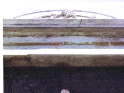
**Figs. 671-676.** Fendas provocadas provavelmente pela trepidação causadas pelas pedreiras.
