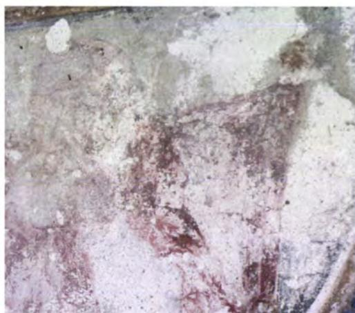
**Figs. 751-757. Patologias – Presença de humidade.** Desgaste, descoloração, erosão, presença de sais, lacunas.
