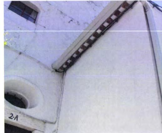
**Figs. 677- 682** Fendas encontradas em toda a estrutura (causadas pela trepidação proveniente das pedreiras?)
