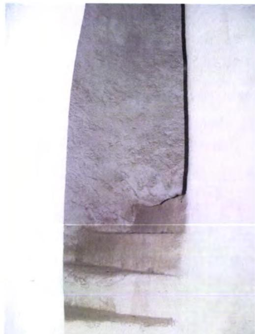
**Figs. 691-692.** Decaimento. Falta de manutenção – limpeza.
