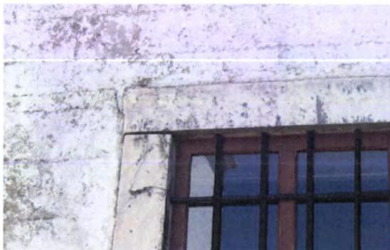
**Figs. 635-639.** Alguns efeitos da presença de humidade nas paredes do edifício
