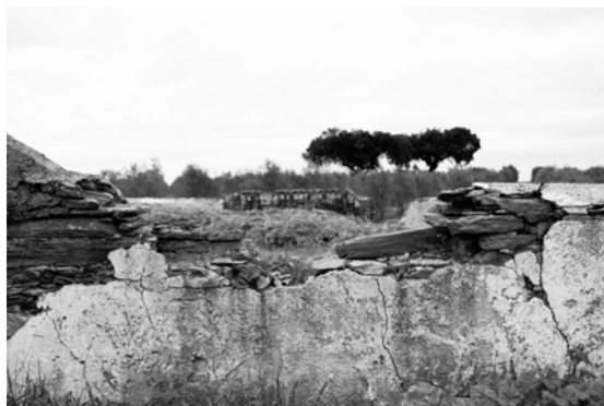
Pormenor muro de xisto, Alqueva
