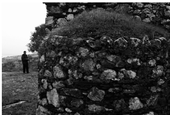
Alvenaria de Granito, Alqueva
