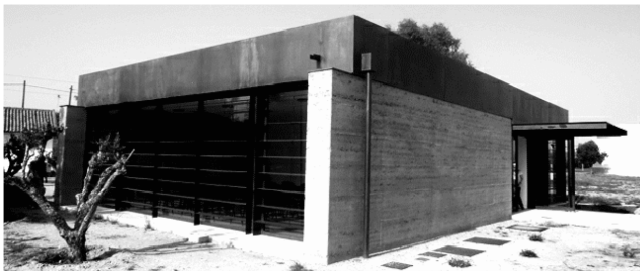
CENTRO DE MONITORIZAÇÃO DA ETAR DE ÉVORA, ARQUITETO JOÃO ALBERTO CORREIA
