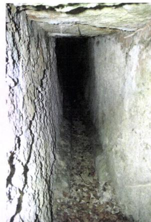
**Figura 12.** Exemplo de uma conduta superficial e do seu interior.
