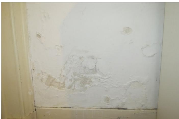
**Figura 24** – Mancha de humidade em parede
