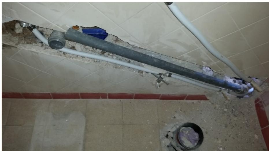
**Figura 29** – Tubo multicamada para abastecimento de água quente e fria e tubo em PVC para drenagem do esgoto
