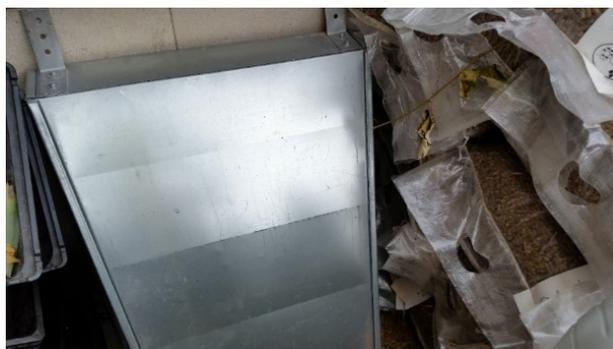
**Figura 32** - Entrada para carregamento do silo lateral
