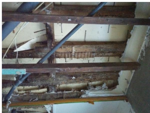
**Figura 28** – Estrutura de piso em madeira danificada
