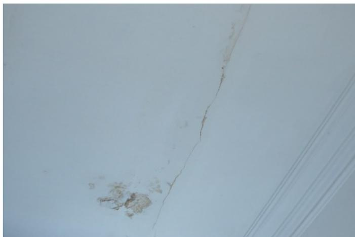
**Figura 23** – Mancha de humidade em teto
