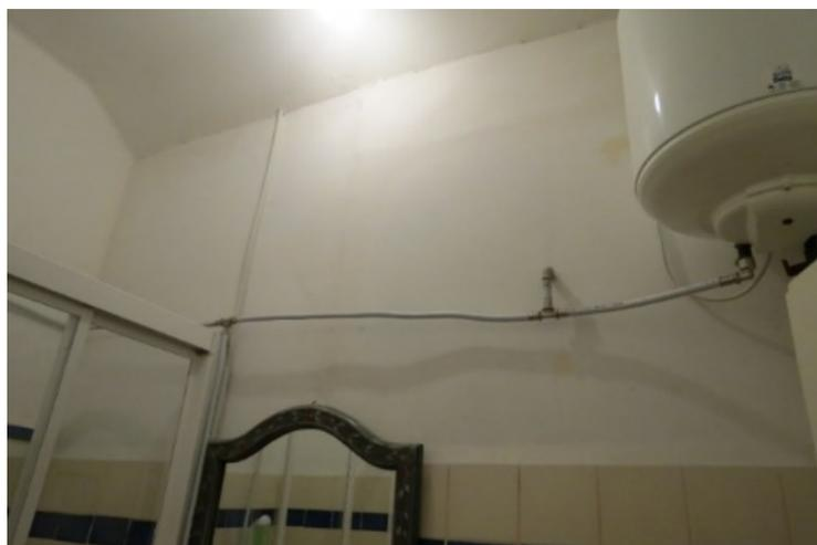
**Figura 26** – Tubagens à vista e termoacumulador elétrico
