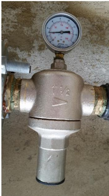
**Figura 34 – Válvula redutora de pressão**
