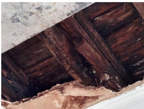
**Figura 27** – Estrutura de piso em madeira danificada
