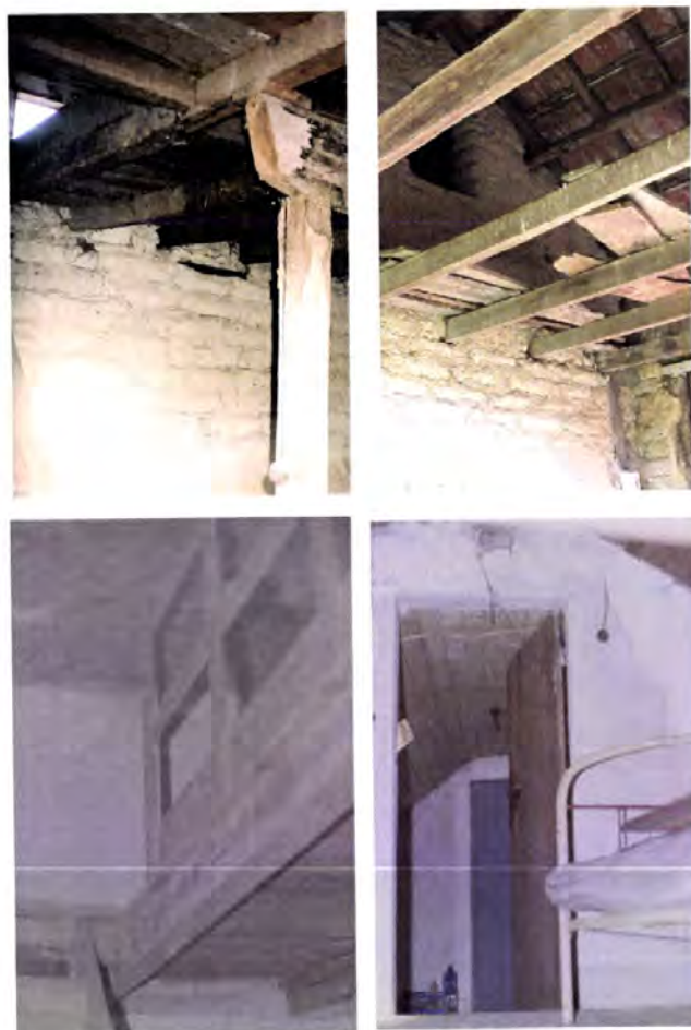
Fotos 10.17, 10.18, 10.19 e 10.20 – Seixo de Mira, Mira; Gafanha da Encarnação, Ílhavo; São Bernardo, Aveiro. Sobrados num celeiro sob a entrada do carro e no desvão da cobertura, aproveitado o sótão para os quartos das filhas.
