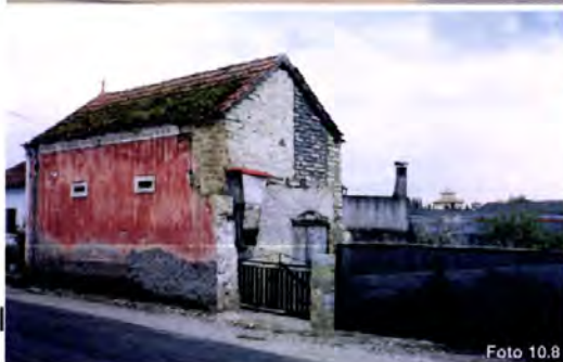
Fotos 10.7, 10.8 e 10.9 – Vagos, Seixo de Mira, Mira e Gafanha da Encarnação, Ílhavo. A demolição total ou parcial dos corpos da casa gandraesa não interfere na estabilidade dos corpos que se mantêm.
