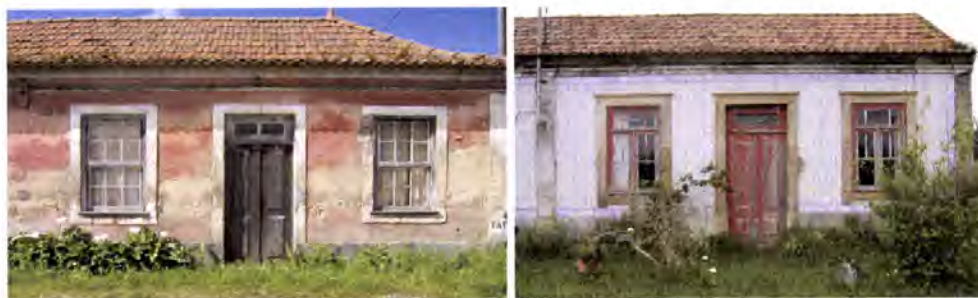
Fotos 10.45, 10.46 – Gafanha da Nazaré, Ilhavo. Aspecto de dois tipos diferentes de guarnições (em reboco e em granito) e arranjo dos vãos principais da casa. O tipo de porta mantém-se variando as janelas, numa das casas de guilhotina e na segunda de dois batentes e bandeira, tal como nas portas.
