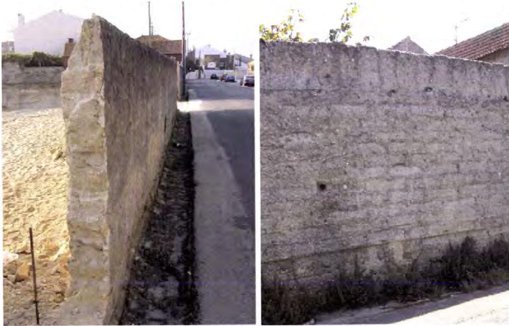
Fotos 9.25 e 9.26 – Esgueira e São Bernardo, Aveiro. Técnicas de coroamento de muros detectadas na região de Aveiro. Os muros das propriedades não eram normalmente rebocados. Os casos como o ilustrado na Foto 10.25, em que o muro é rebocado são esporádicos. No entanto, o capeamento do topo dos muros e a execução do chanfro é uma prática corrente.
