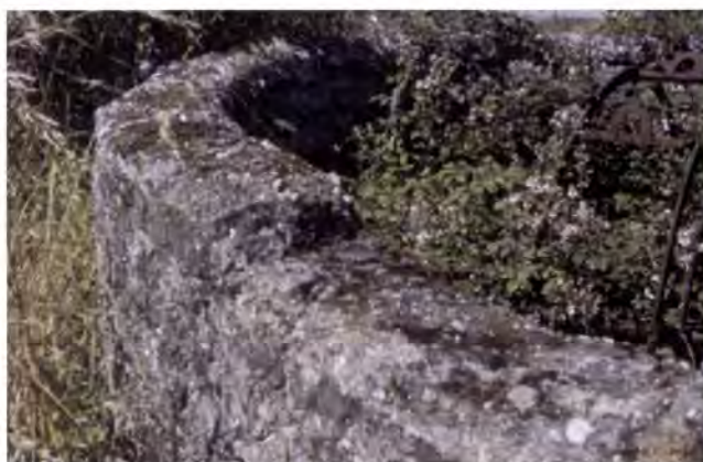
Foto 9.29, 9.30 – São Bernardo e Quinta do Gato, Aveiro. Adobo de poço – a adopção de adobos curvos de modo a adaptarem-se às características formais do objecto a que se destina.
