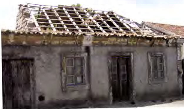
Foto 10.30 – Gafanha da Nazaré, Ílhavo. Estrutura corrente de cobertura de uma casa gandraesa.
