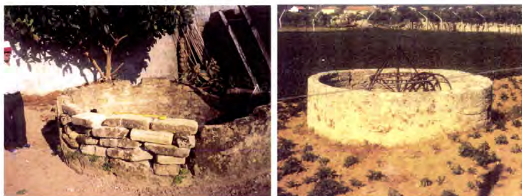
Foto 9.27 e 9.28 – Ouca, Vagos e Esgueira, Aveiro. O poço de casa para abastecimento doméstico era mais pequeno que os poços de engenho localizados nos campos. Foto 9.28, Artur Leite. Fonte: Aurora Ferreira Leite 20 .
