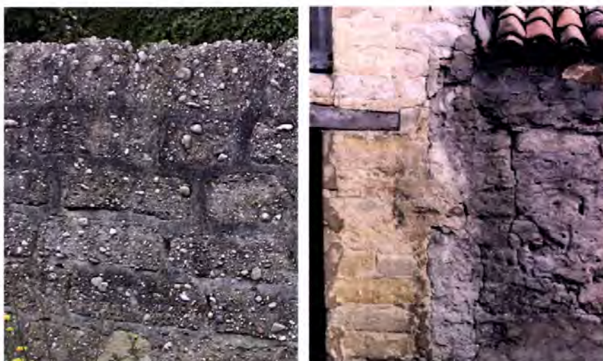
Foto 8.4 e 8.5 – Aradas, Aveiro e Gafanha da Nazaré, Ílhavo. Adobos de muro com seixo rolado de dimensões apreciáveis; e o contraste cromático entre alvenarias em adobos correntes do tipo dos utilizados nas casas e adobos negros, produzidos com terras com muita matéria orgânica, corrente nas Gafanhas.
