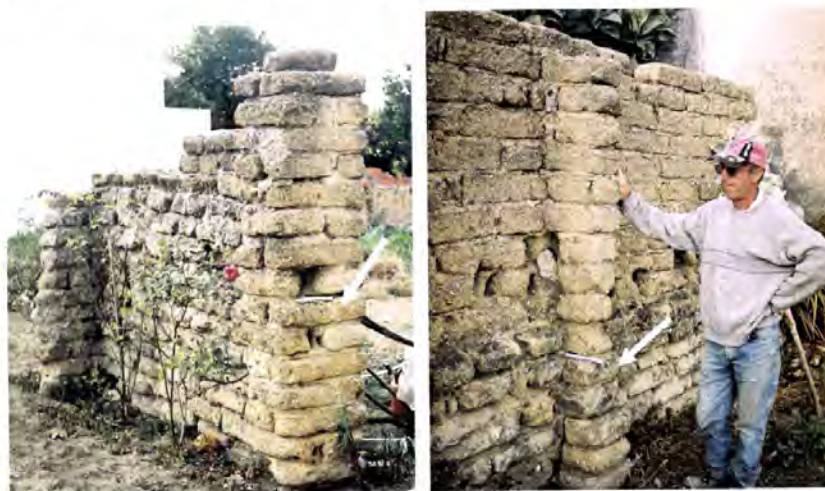
Fotos 10.21 e 10.22 – Ouca, Vagos. Aspecto de alvenarias de paredes de casa. Cunhais, reforços de vão “a uma vez” e, na foto 11.18, reforço da base da parede e ligação de paredes perpendiculares. Escala de campo 20cm.
