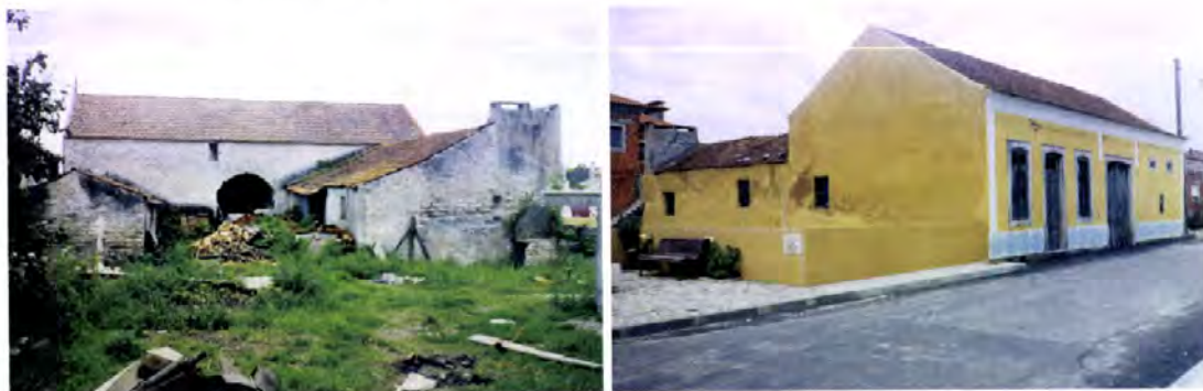
Fotos 9.11 e 9.12 – Seixo de Mira, Mira. Aspecto geral de uma “casa de Mira”. O alçado lateral, rebocado e pintado na casa ilustrada não recebia habitualmente qualquer tratamento ficando com os adobos à vista.
