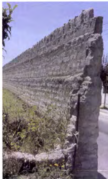
Fotos 9.23 e 9.24 – São Bernardo, Aveiro. Aspectos da adopção de estratégias construtivas para assegurar a estabilidade do conjunto, reforçando a base com contrafortes que se sucedem ao longo do muro, ou aumentando a espessura da base que diminui nas fiadas superiores culminando com adobos aplicados a cutelo.
