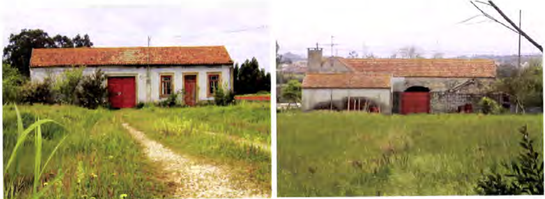
Fotos 9.6 e 9.7 – Gafanha da Boa-Vista, Ílhavo. Fachada e tardoz de uma casa-pátio construída nos primeiros anos do séc. XX, propriedade de Manuel Lavrador.
