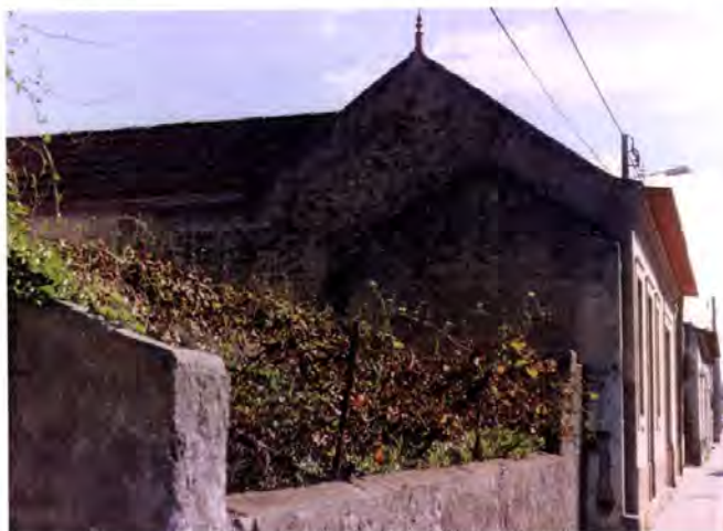
Foto 12.1 – Esgueira, Aveiro. Regularização da altura da cumeeira dos dois corpos de uma gandaresa.
