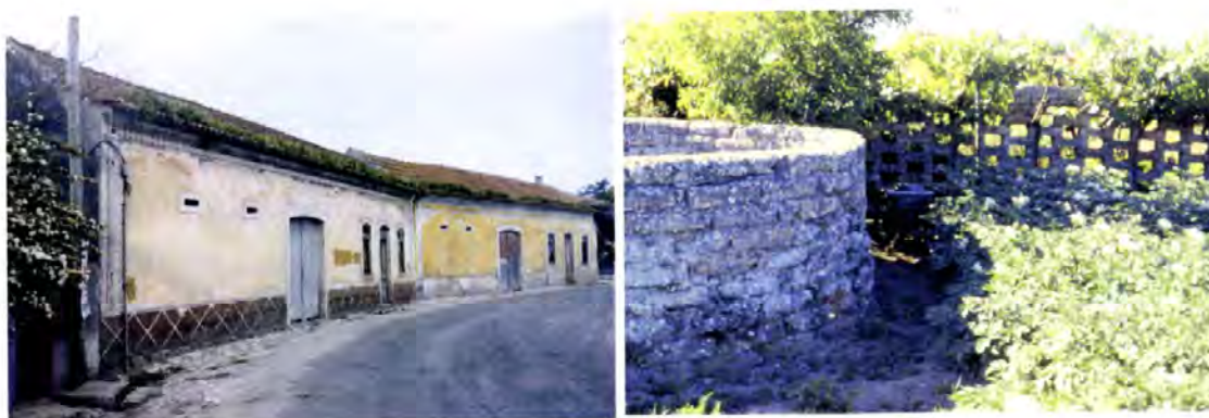
Fotos 9.1 e 9.2 – Cabeças Verdes, Mira e Quinta do Gato, Aveiro. A casa-pátio, os muros e construções de apoio à lavoura são as referências regionais mais significativas do construir em adobo.
