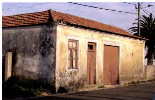
Foto 10.5 – Aradas, Aveiro. Casa gandraesa onde a estreiteza do lote levou à omissão da “meia-sala”.
