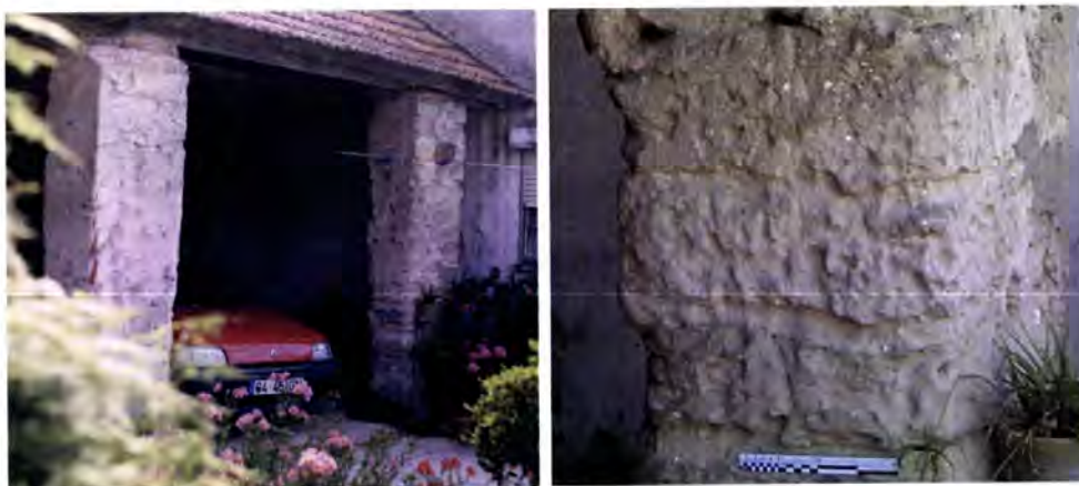
Fotos 8.11 e 8.12 – Gafanha da Nazaré, Ílhavo. Pilares de suporte do telheiro executados em adobos de 50cm X 25cm X 15cm. Escala de campo 20cm.
