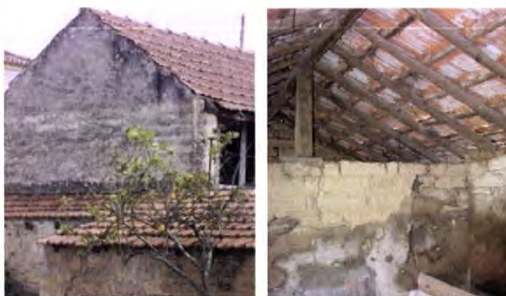
Foto 10.35 e 10.36 – Gafanha da Nazaré, Ílhavo. Dois tipos de coberturas de anexos e de assentamento das estruturas às paredes, apoiadas e encastradas. Note-se o arranjo interior de um curral em que a fileira é escorada por um pequeno pilar apoiado a meio vão numa parede de adobo.
