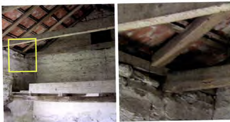
Foto 10.32 e 10.33 (pormenor) – Seixo de Mira, Mira. Encontro de estrutura de cobertura com parede lateral. As pendentes, travadas por linhas que ao nível da parede fazem a transição entre esta e o frechal.
