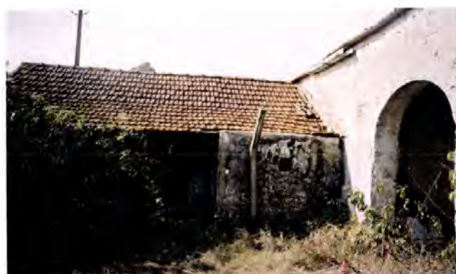
Foto 10.55 – Seixo de Mira, Mira. Interior de um pátio de uma casa gandraesa em que a parede do corpo principal apresenta as alvenarias sem qualquer tipo de revestimento. O aspecto regular deve-se ao facto das argamassas de assentamento serem de cor aproximada à dos adobos, estarem regularizadas à face dos mesmos e não apresentarem decaimentos diferenciais.
