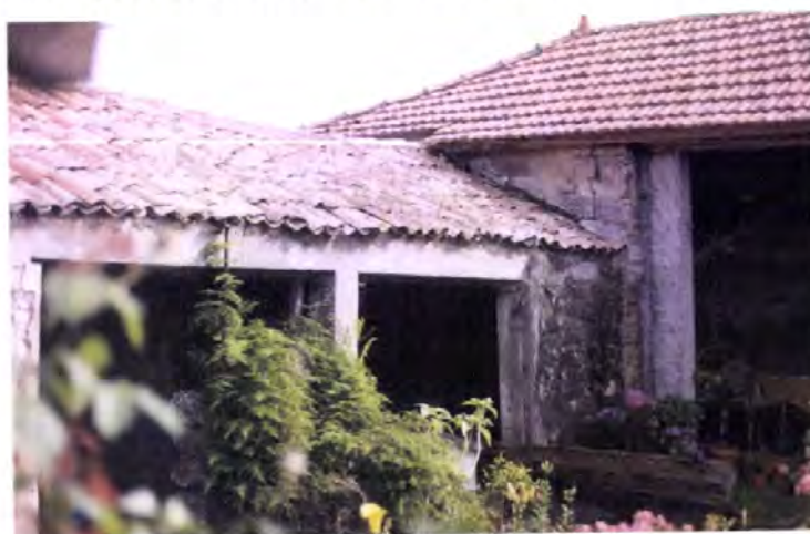
Foto 10.39 – Gafanha da Nazaré, Ílhavo. A coexistência dos dois tipos de telhas, a mais antiga, de canudo, que se mantém nos anexos e a “telha de Marselha” generalizada à restante casa.
