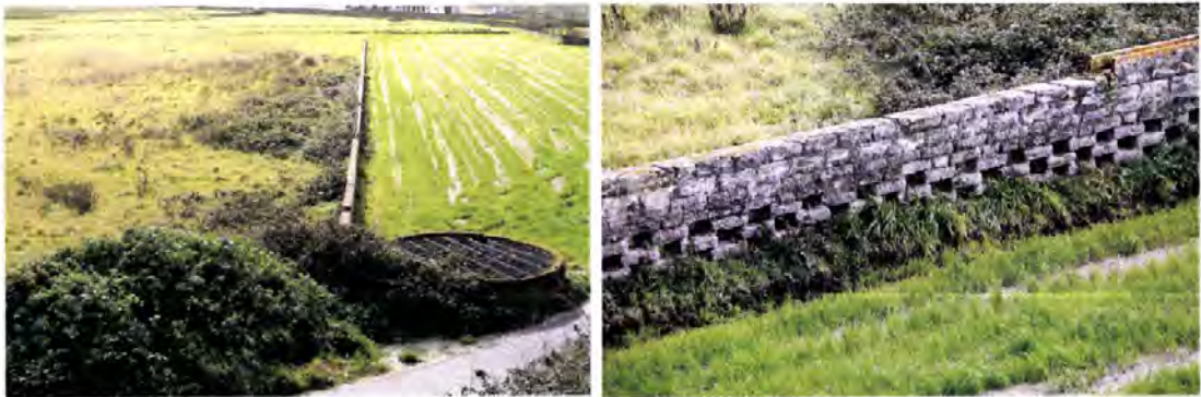
Fotos 9.31 e 9.32 - Esgueira, Aveiro. Conjunto de grande dimensão de poço de rega, já sem engenho que drenava para um tanque lateral, mais alto que o terreno e que por intermédio do aqueduto permitia a rega de toda a propriedade. Na definição da zona de circulação da água são ainda visíveis as abas laterais já em tijolo.
