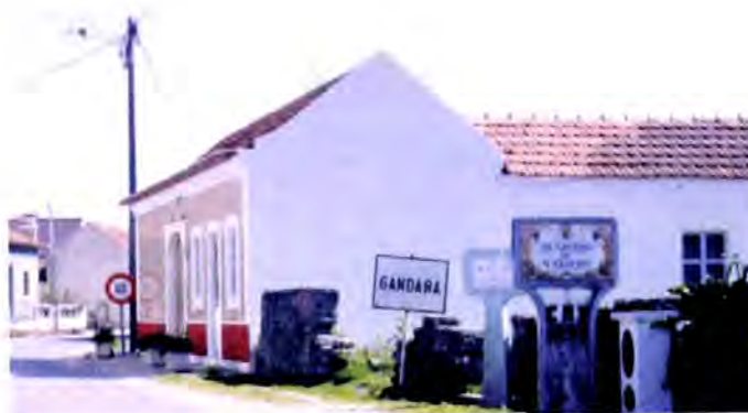
Foto 9.9 – Gândara, Vagos. A “casa de Mira” ultrapassa o espaço original gandarês estendendo-se aos municípios de Vagos e ainda, mais para norte até ao Vouga.
