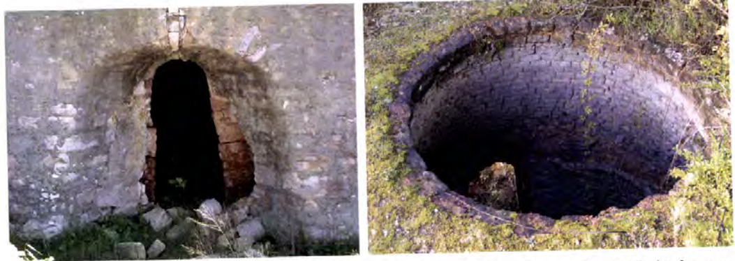
Fotos 7.8 e 7.9 - Estação de Cantanhede. Aspecto da “boca” e da “goela” de fornos tradicionais, já desactivados. Devido ao aluimento do pano exterior em pedra argamassada, a foto da “boca” exhibe o revestimento interior do forno.
