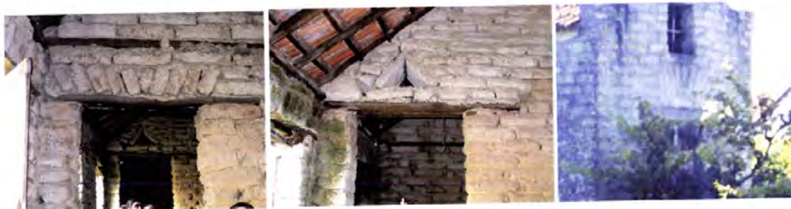
Fotos 10.24, 10.25 e 10.26 – Fontão, Vagos e Quinta do Gato, Aveiro. Tipos de archetes em adobo, respectivamente, simples, em “asa de cesto” e “redondo”.
