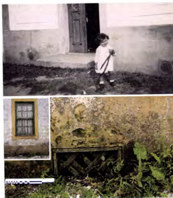
Fotos 10.14, 10.15 e 10.16 – Santiago, Aveiro e Gafanha da Nazaré, Ílhavo. Grelhas de ventilação da caixa-de-ar, comercializadas em metal fundido ou manufacturadas em madeira. Na foto 11.16, grelha já está parcialmente obstruída devido à repavimentação do caminho. Escala de campo 20cm. Foto 10.14, Élia Branco Santiago.
