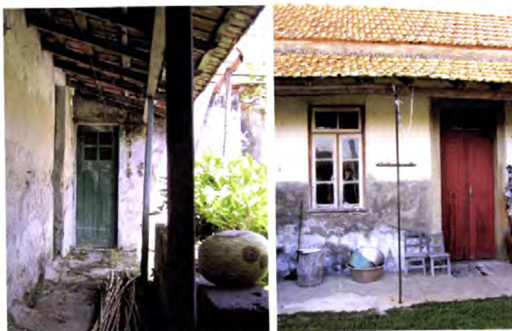
Foto 10.37 e 10.38 – Gafanha da Nazaré e Gafanha da Encarnação, Ílhavo. Estrutura característica de um telheiro.
