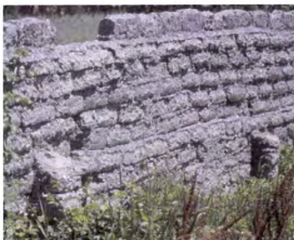
Fotos 9.23 e 9.24 – São Bernardo, Aveiro. Aspectos da adopção de estratégias construtivas para assegurar a estabilidade do conjunto, reforçando a base com contrafortes que se sucedem ao longo do muro, ou aumentando a espessura da base que diminui nas fiadas superiores culminando com adobos aplicados a cutelo.
