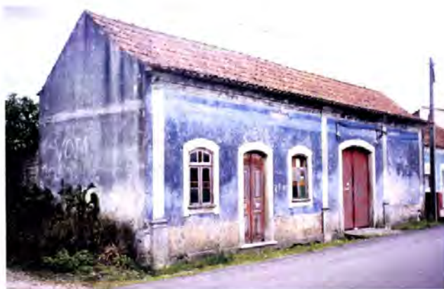
Foto 10.1 – Fonte Angeão, Vagos. A implantação características da casa gandaresa junto à estrada.
