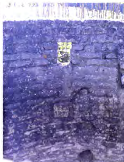
Foto 9.29, 9.30 – São Bernardo e Quinta do Gato, Aveiro. Adobo de poço – a adopção de adobos curvos de modo a adaptarem-se às características formais do objecto a que se destina.
