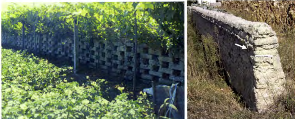
Fotos 9.21 e 9.22 – Quinta do Gato e Oliveirinha, Aveiro. Duas das principais soluções adoptadas para a construção de muros em alvenarias de adobo. Escala de campo 20cm.
