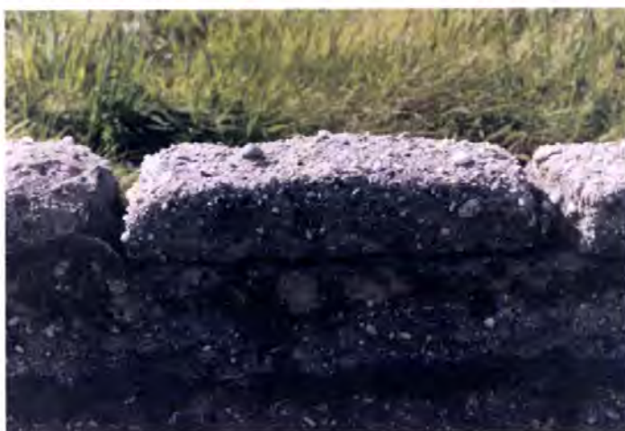
Foto 8.2 – Gafanha da Nazaré, Ílhavo. O “adobo de cal”, a principal referência do construir em “terra crua” no litoral entre Vouga e Mondego.
