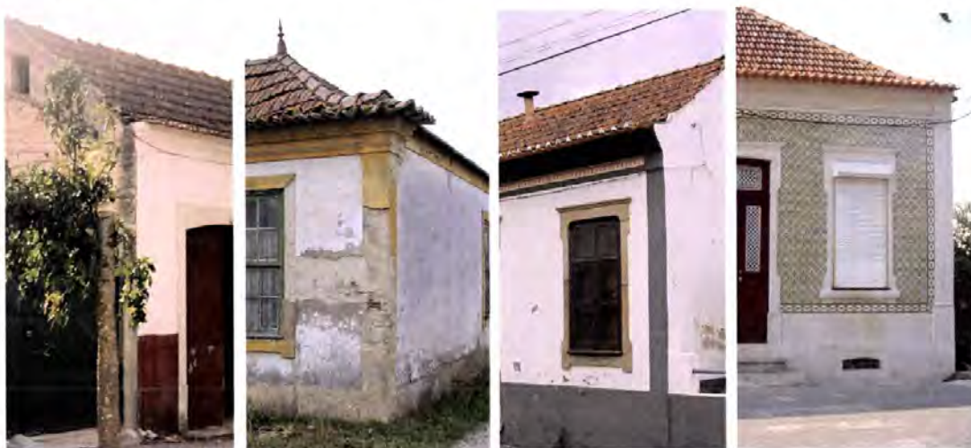
Fotos 10.51, 10.52, 10.53 e 10.54 - Seixo de Mira, Mira; Gafanha da Nazaré, Ílhavo; Cacia, Aveiro e Concelho de Vagos, respectivamente. Aspectos sobre diversos tipos de tratamento das fachadas.
