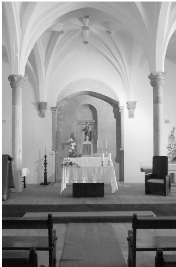
Figura 42: Interior da igreja de Nossa Senhora da Anunciação (antiga mesquita do século XII), cujas superfícies estão caiadas e o mihrab, ao fundo, conserva ainda bonitas decorações em técnicas de fresco e esgrafito, com recurso a água e argamassas de cal. Mértola, 2015.
