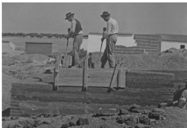
Figura 39: Execução de alvenaria em taipa no Alfundão, Ferreira do Alentejo (Cit. por PRISTA, arq. OA, 2014, p. 48).
