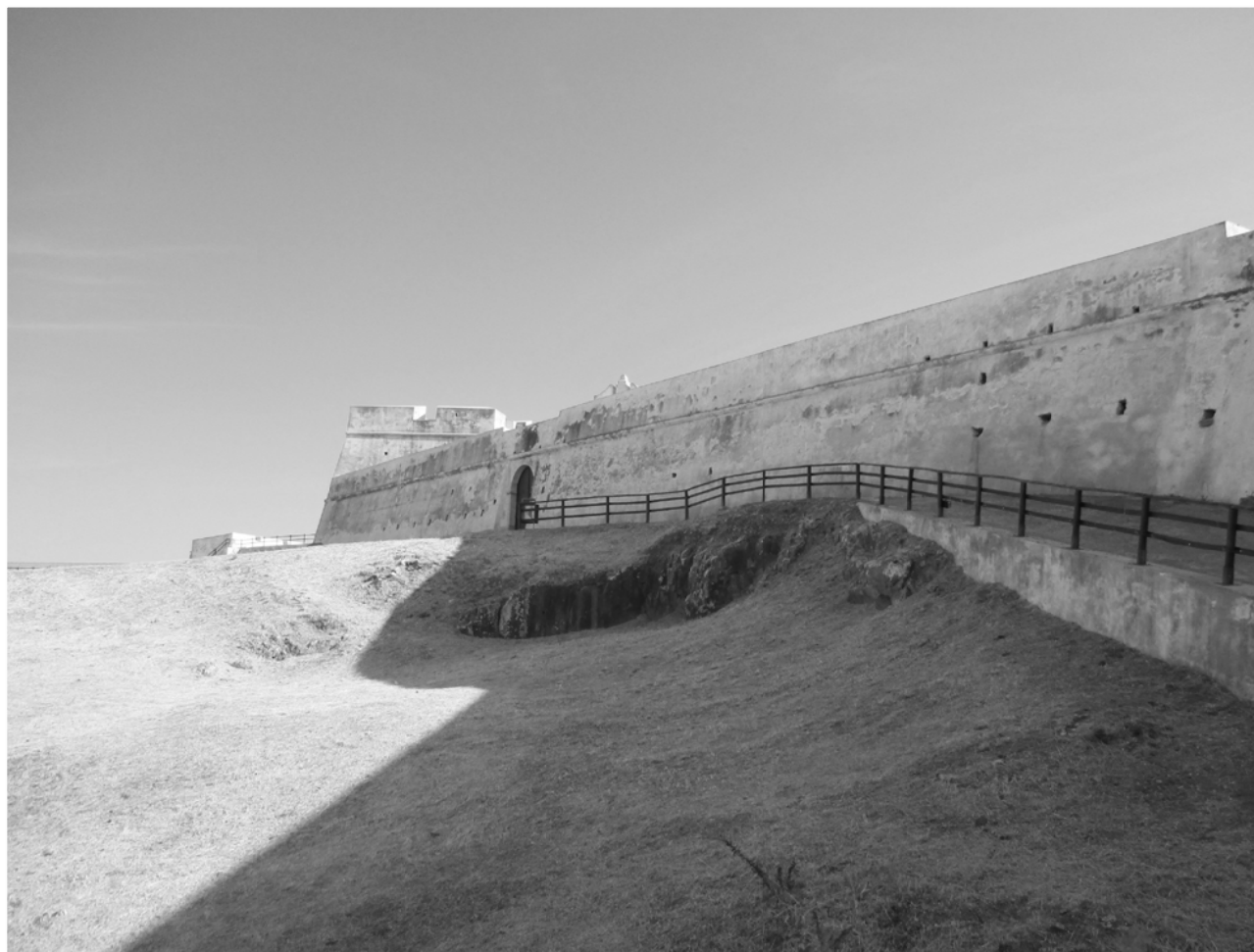
Figura 46: Forte de São Sebastião, construído e consolidado exteriormente com recurso a argamassa de cal. Castro Marim, 2015.
