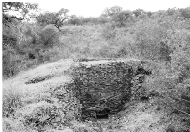
Figura 100: Forno de cal do posto do Pontal, construído nas imediações do antigo posto da Guarda Fiscal do Pontal. Laranjeiras, 2015.
