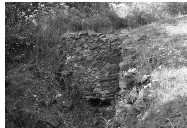
Figura 98: Forno de cal da casa do Viola. Laranjeiras, 2015.
