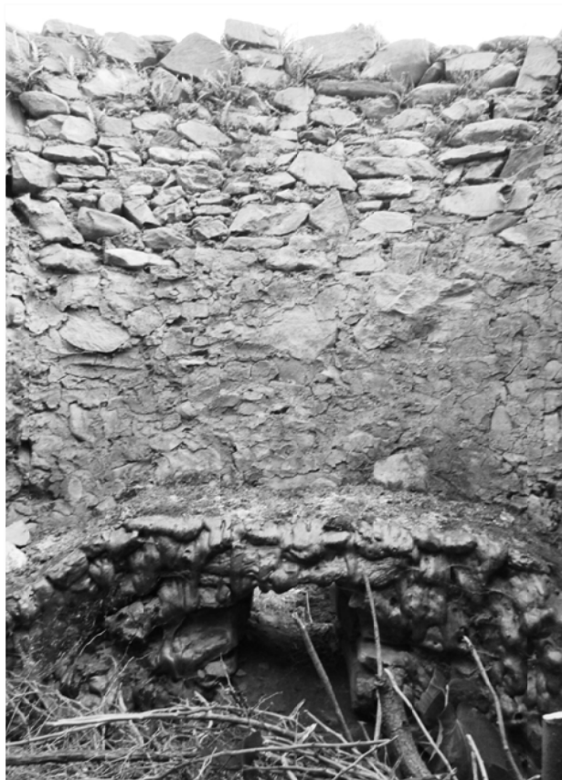
Figura 96: Pormenor do interior do forno do canto Queimado, no qual é possível observar a alvenaria rebocada com barro e o cintel, com escorras no limite interior, que sobe por cima da porta de alimentação da caldeira. A diferença entre os estados de conservação das alvenarias do interior do forno, deve-se provavelmente, ao facto da alvenaria superior já ter sido reconstruída. Laranjeiras, 2015.
