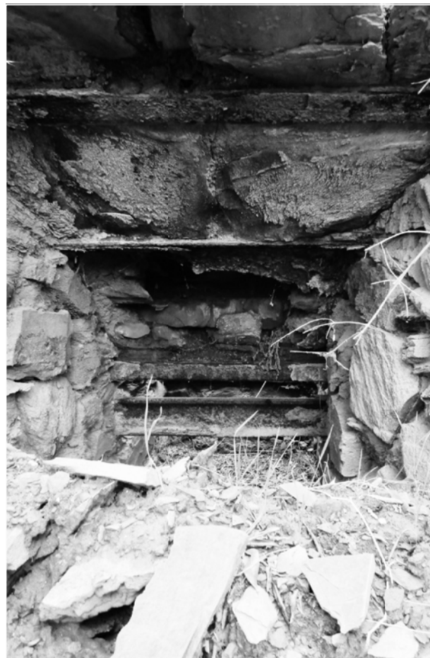
Figura 122: Pormenor da porta da câmara inferior do forno mais à esquerda (do conjunto dos 4 fornos de cal do Pomarão), onde se observa o interstício, entre as duas barras metálicas, onde corria a grelha de sustentação . Pomarão, 2014.
