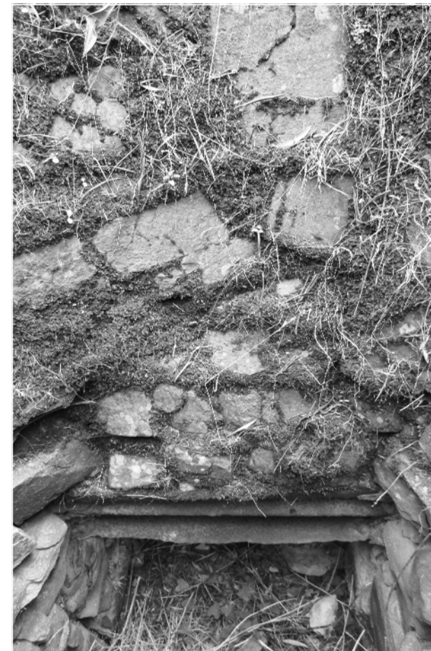
Figura 123: Pormenor do interior do forno mais à esquerda (do conjunto dos 4 fornos de cal do Pomarão), onde se observa a transição da câmara inferior, de base quadrangular, para a câmara superior, de secção circular. Pomarão, 2014.
