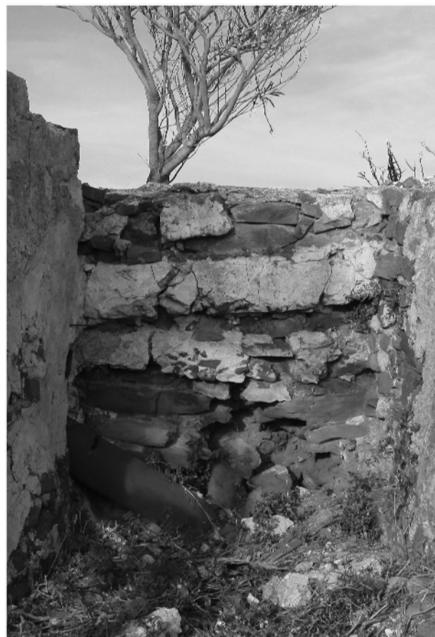
Figura 68: Alçado de um dos fornos (do conjunto dos 3 fornos de cal da quinta do Moinho), onde se observam os restos dos rebocos de cal e areia; o lugar onde estavam os barrotes de madeira para o reforço da alvenaria do alçado frontal; e o cano metálico de distribuição do combustível. Castro Marim, 2015.
