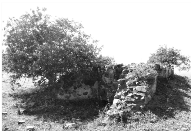
Figura 70: Forno de cal da quinta do Moinho, no qual se observam ainda as remanescentes dos rebocos de cal e areia, que outrora cobriam a totalidade das alvenarias. Castro Marim, 2015.
