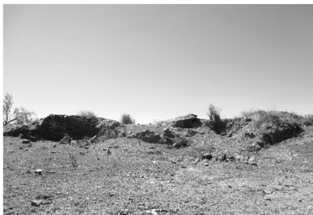
Figura 76: Conjunto dos 2 fornos de cal do Montinho Velho, onde sobressai o mau estado de conservação do forno maior, que está à direita. Castro Marim, 2015.
