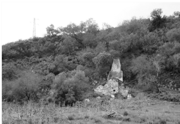
Figura 124: Forno de cal isolado do Pomarão, cujas alvenarias apresentam ainda os rebocos, em parte, caiados. Pomarão, 2014.
