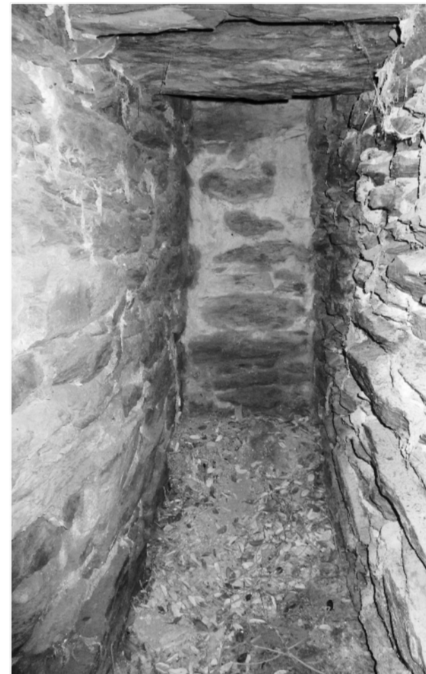
Figura 126: Pormenor do interior da câmara inferior do forno isolado do Pomarão, de onde são retiradas as pedras de cal viva e a cinza. Pomarão, 2014.
