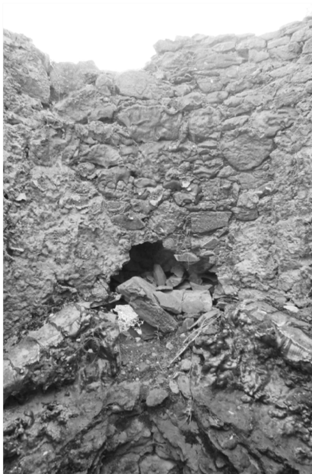
Figura 99: Pormenor do interior do forno da casa do Viola, no qual é possível observar as alvenarias revestidas de escorras e o cintel, em parte quebrado, que sobe por cima da porta de alimentação da caldeira. Laranjeiras, 2015.
