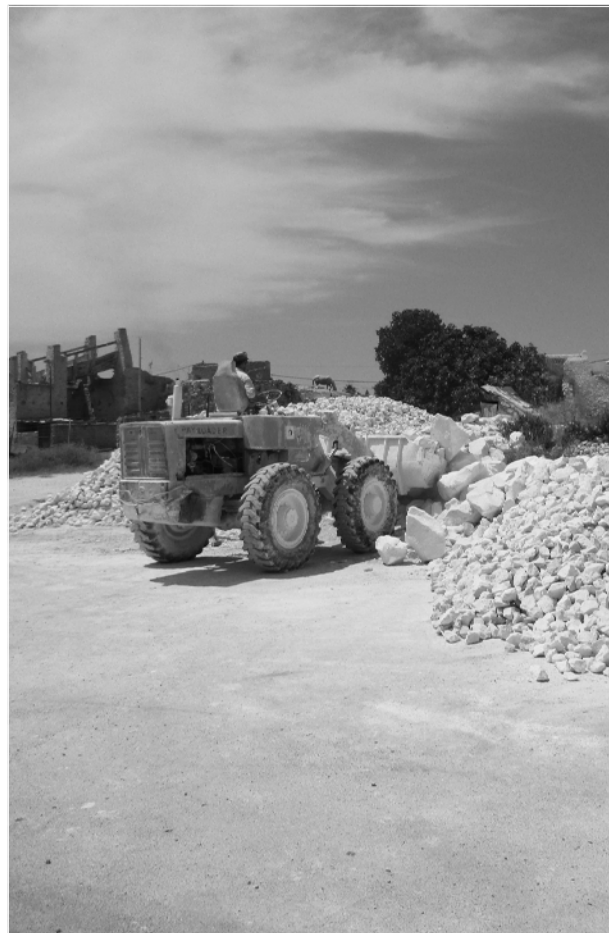
Figura 189: Carregamento de uma porção de pedras calcárias (ainda por calcinar), com a máquina de pá basculante, que têm como destino o forno dos Gordillos que está a ser enornado. Las Caleras de la Sierra, 2015.
