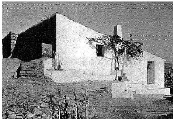
Figura 145: Casa em Alcaria Alta, Alcoutim, inserida na tipologia de habitações junto ao vale do Guadiana, 1955 (MARTINS; CASTRO; TORRES, 2004, p.330).
