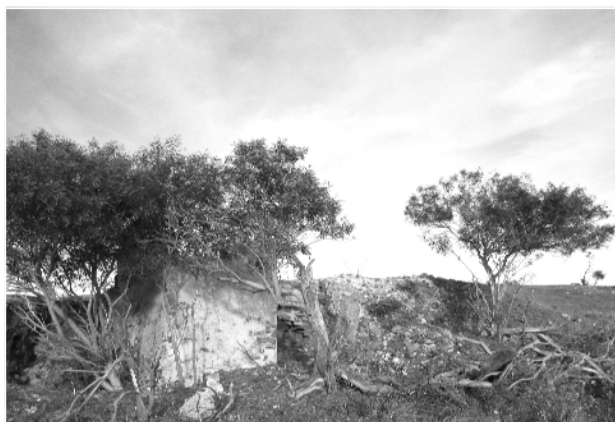
Figura 67: Conjunto dos 3 fornos de cal da quinta do Moinho, no qual se destaca o volume da casa de armazenamento do combustível (cascas de amêndoa e de pinhão). Cascas essas que depois eram distribuídas, através de canos metálicos, até às portas dos dois fornos contíguos. Castro Marim, 2015.
