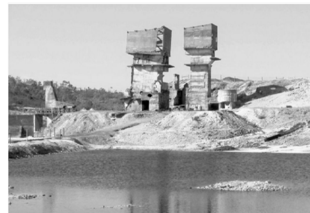
Figura 52: Fábricas de extração de enxofre e matte, implantadas na Achada do Gamo. Mina de São Domingos, 2015.
