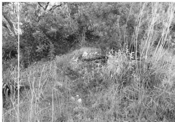
Figura 97: Ruína do forno de cal da casa do Salvador. Laranjeiras, 2015.
