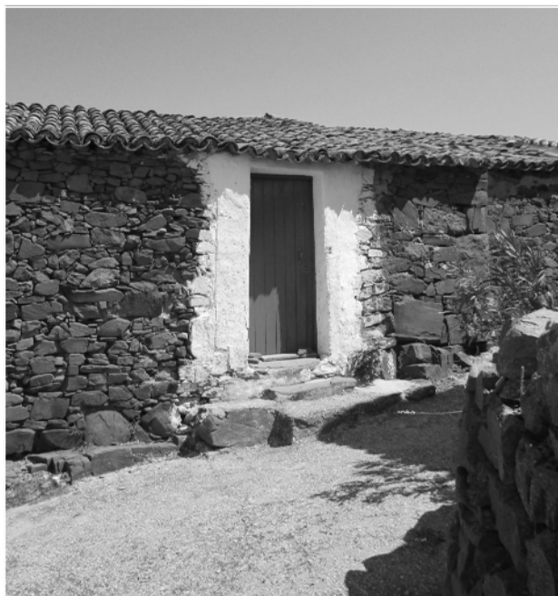
Figura 142: Edifício em Gíões, Alcoutim, em aparelho de xisto, cujo o paramento exterior em volta da porta, está caiado. Gíões, 2015.
