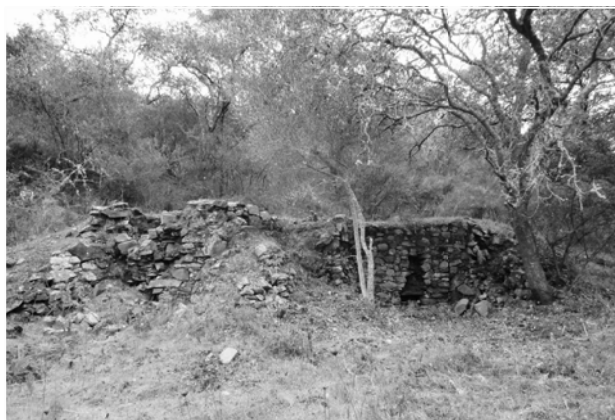
Figura 93: Conjunto dos 2 fornos de cal do canto Córías (também implantados junto ao barranco Córías), e onde se observam os paramentos de xisto do forno da esquerda, já em mau estado de conservação. Laranjeiras, 2015.
