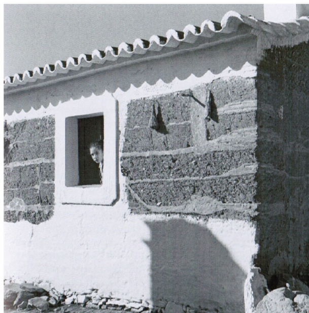
Figura 143: Edifício em Corvos, Mértola, em aparelho de taipa, cujo o paramento exterior em volta da janela e no beiral/ rodapé está caiado, 1995 (cit. por PRISTA, Arq. OA, 2014, p. 110).
