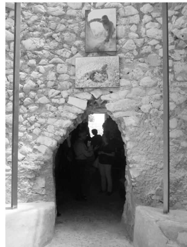
Figura 178: Pormenor do alçado interior do poço do forno musealizado, que foi primeiro visitado, onde estão expostas mais fotografias do ofício da cal e onde se observam também os apoios da estrutura metálica, embutidos no cintel, que sustentam, num nível superior, a clarabóia e a simulação da cabeça do forno. Las Caleras de la Sierra, 2015.
