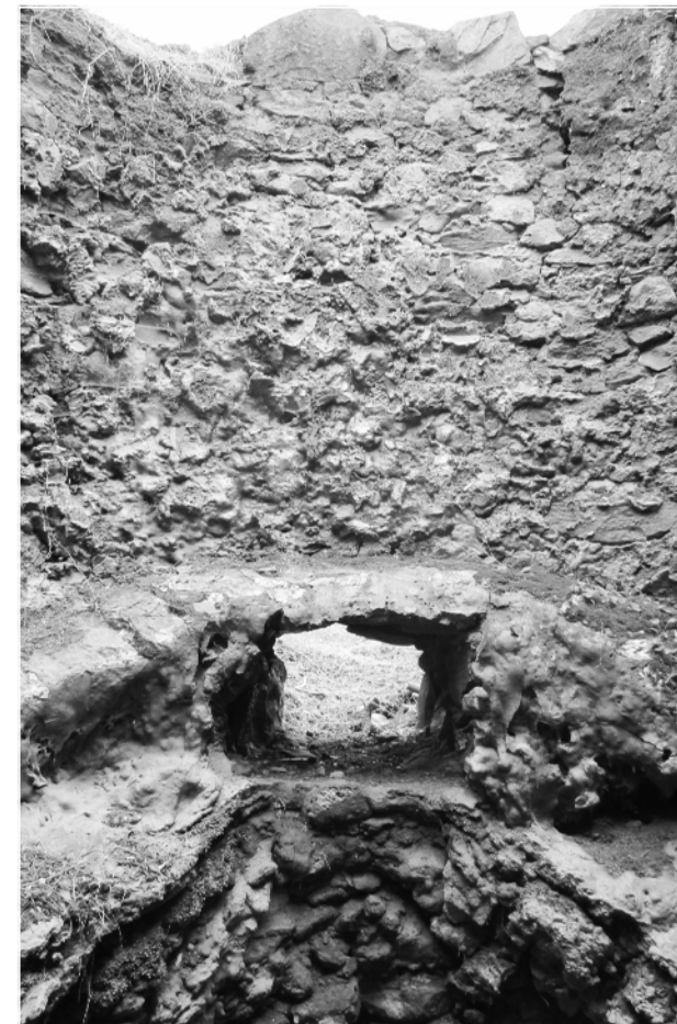
Figura 101: Pormenor do interior do forno do posto do Pontal, no qual é possível observar as alvenarias revestidas de escorras e o cintel que sobe por cima da porta de alimentação da caldeira. Laranjeiras, 2015.
