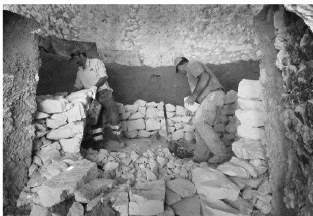
Figura 184: Pormenor do interior do forno dos Gordillos, onde estão os 2 mestres caleiros construindo, pedra a pedra, a estrutura abobadada; e onde é visível o forro, construído em pedra calcária e barro, entre as pedras calcárias do enforamento e o paramento circular da estrutura do forno. Las Caleras de la Sierra, 2015.
