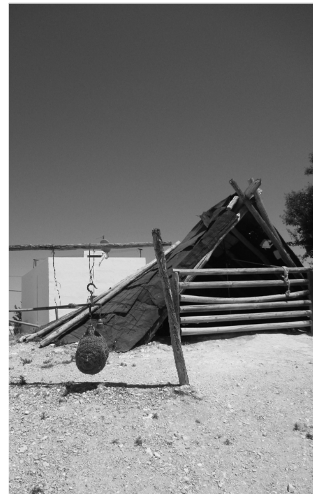
Figura 180: Capota em madeira e chapa, pousada sobre o limite superior do forno musealizado, que foi posteriormente visitado. Las Caleras de la Sierra, 2015.
