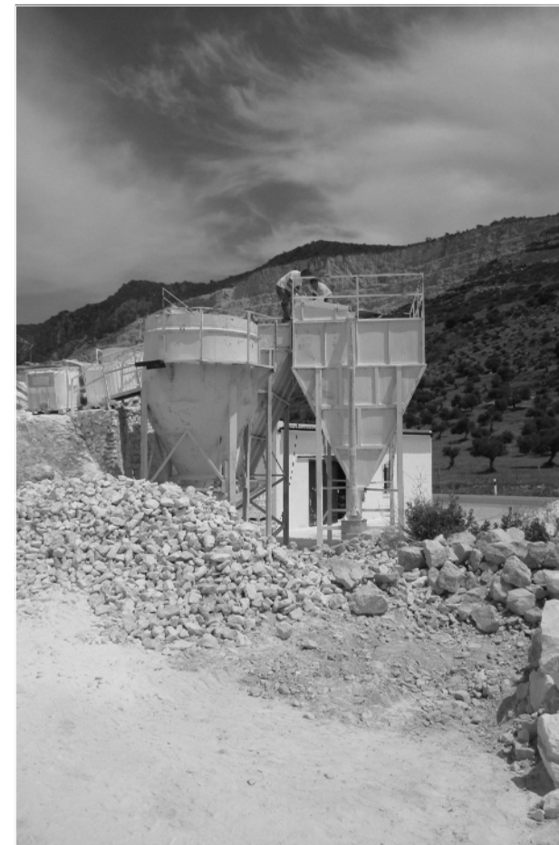
Figura 190: Depósitos suspensos, onde está a acontecer o processo de hidratação das pedras de cal viva, com a serra de Esparteros ao fundo e o monte de pedras calcárias (ainda por calcinar) no primeiro plano. Las Caleras de la Sierra, 2015.
