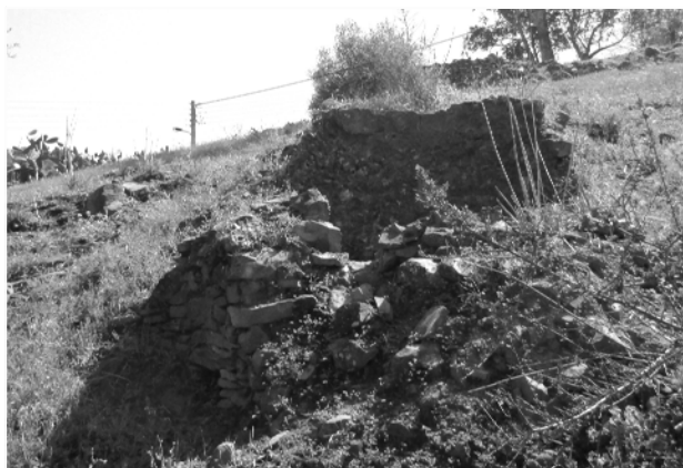
Figura 90: Ruína do forno de cal da casinha. Laranjeiras, 2015.
