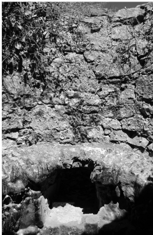
Figura 77: Pormenor do interior do forno da esquerda (do conjunto dos 2 fornos de cal do Montinho Velho), no qual é possível observar o cintel, com escorras no limite interior, que sobe por cima da porta de alimentação da caldeira. Castro Marim, 2015.
