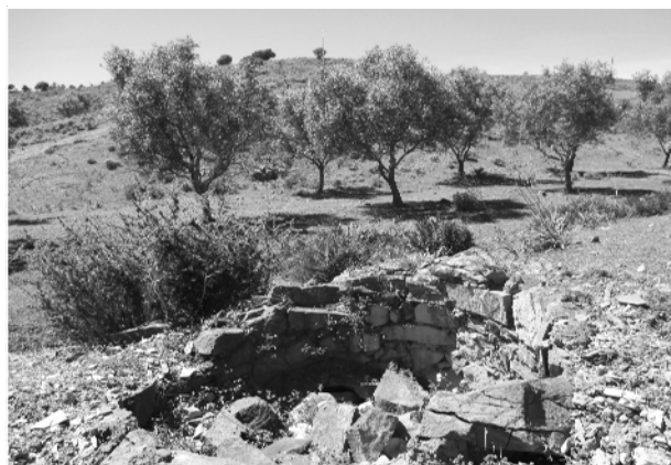
Figura 74: Ruína do forno de cal (2) do Montinho Velho. Castro Marim, 2015.
