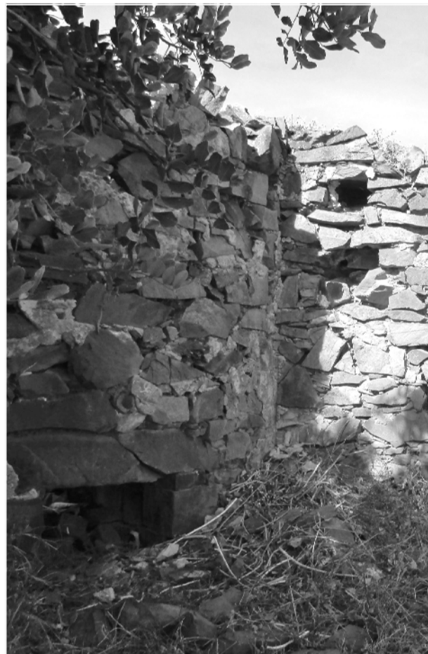
Figura 71: Pormenor do alçado lateral do forno da quinta do Moinho, no qual é possível observar as duas concavidades onde encaixavam os barrotes de madeira, para o travamento do alçado frontal. Castro Marim, 2015.
