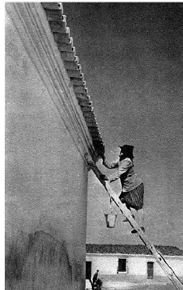
Figura 44: Caiadeira, aplicando o leite de cal como acabamento exterior do edifício, perto de Portel, Beja (GEORGE; GOMES; ANTUNES, 2004, p.175).
