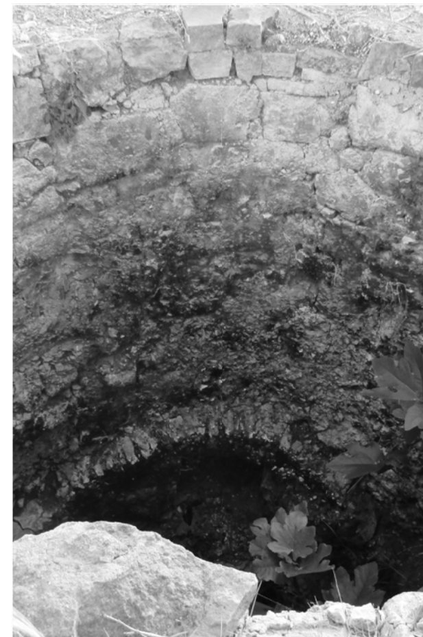
Figura 69: Pormenor do interior do forno mais à direita (do conjunto dos 3 fornos de cal da quinta do Moinho), no qual é possível observar o cintel, que sobe por cima da porta de alimentação da caldeira. Castro Marim, 2015.
