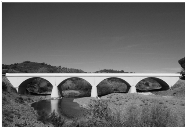
Figura 51: Ponte, construída com recurso a argamassas de cal preta e areia, sobre a ribeira da Foupana. Palmeira (Alcoutim), 2015.
