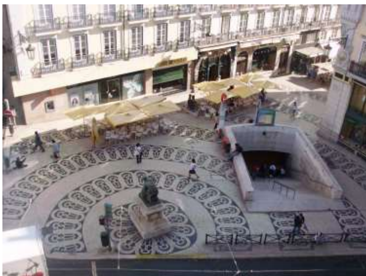
Vista da casa de Manuel Ferreira Cardoso, para o Largo do Chiado
