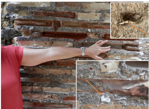
Figura 7: Detalhe da largura do arco da ala conventual do Paraguaçu, com cerca de 90 cm de largura, e no destaque partes de carapaças de moluscos presentes na argamassa. Fonte: Elaboração própria. (Novembro de 2014)
