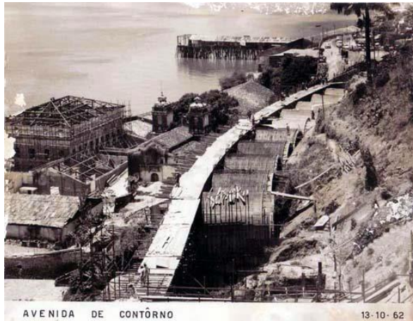
Figura 61: Restauro do conjunto do Solar do Unhão e a construção da Avenida Cotorno, que passa em frente ao conjunto arquitetônico.
