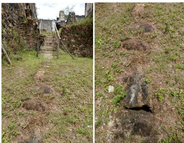
Figura 40: Sistema de canaletes existentes na área conventual.
