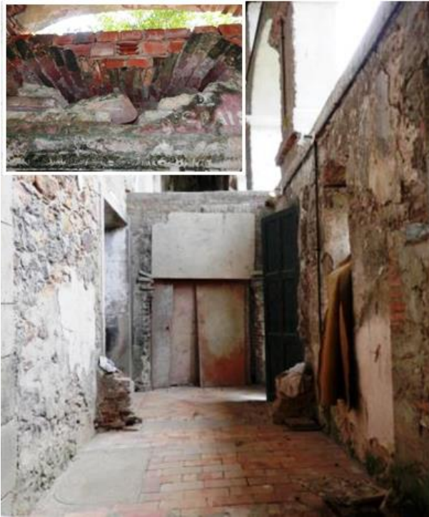
Figura 26: Corredor lateral da Igreja, cujo andar superior servia para interligar as tribunas.
