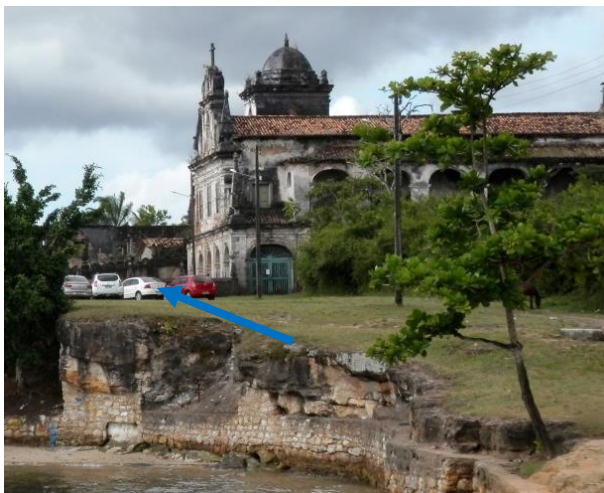
Figura 44: Vista da lateral esquerda do convento, com destaque para a área do antigo cemitério transformado em estacionamento.
