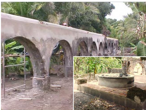
Figura 43: O aqueduto e o poço.
