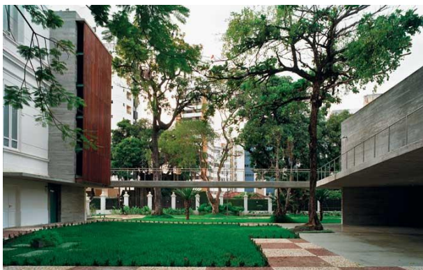
Figura 68: Modificações feitas no Palacete das Artes, com construção de um anexo e incorporação de uma rampa a unir os dois edifícios.
