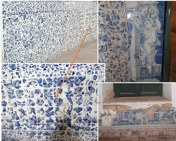
Figura 27: Painel de azulejo da Sacristia com sua reconstrução utilizando técnica considerada “exótica” pelo IPHAN.
