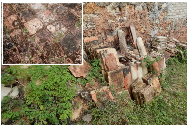
Figura 34: Piso existente na parte externa, ao lado do claustro.
