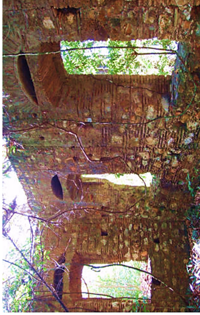
Figura 7: Ruínas do Engenho Novo, localizado na Fazenda Salamina. Fonte: Elaboração própria.
