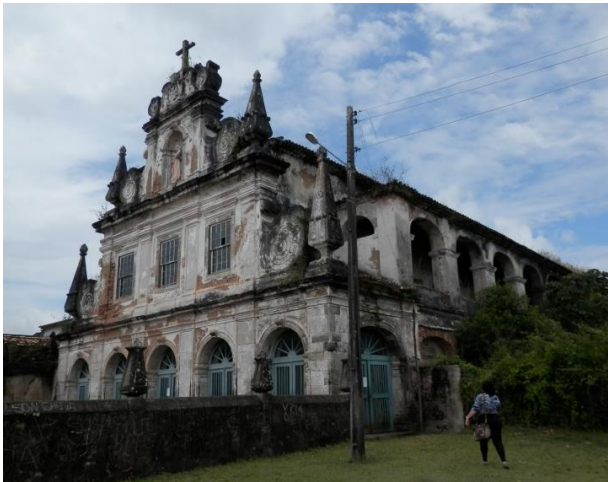
Figura 25: Vista externa lateral da Igreja com a varanda superior em destaque, interligando as tribunas; já a varanda inferior, e seus arcos, encontra-se quase totalmente encoberta pela vegetação.
