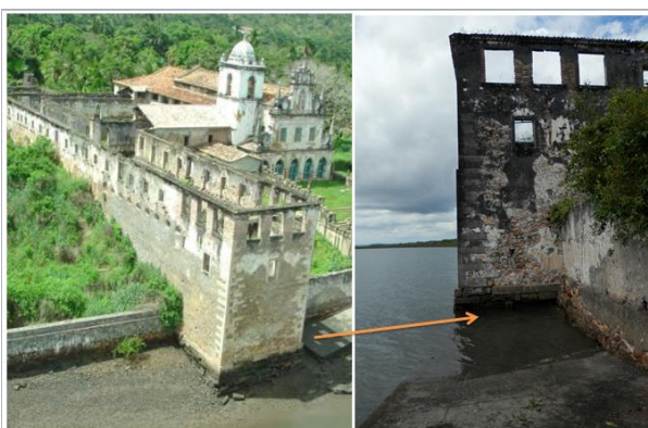
Figura 33: Vista da lateral da ala conventual. No destaque o subsolo alagado nas marés altas.
