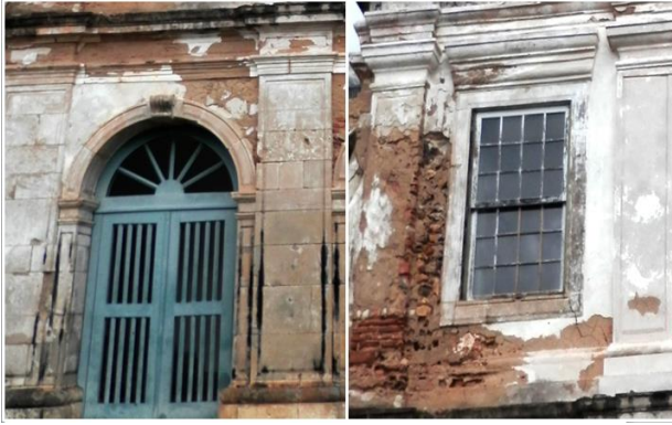
Figura 15: Parte da fachada com sua parede elaborada em alvenaria mista e alguns detalhes, como a caixa da janela e as colunas revestidas em pedra.
