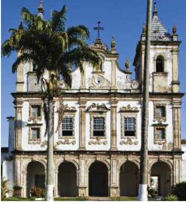
Figura 15: Fachada do convento de Santo Antônio, em São Francisco do Conde.
