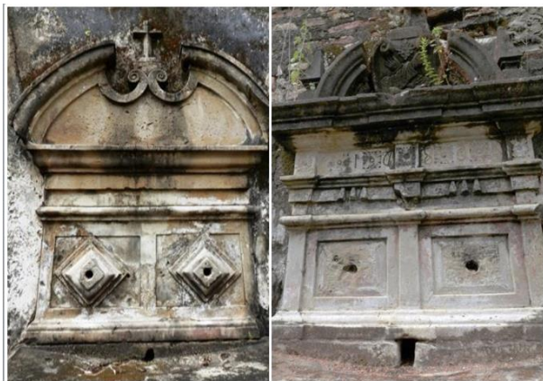
Figura 37: Lavabos em pedra.
