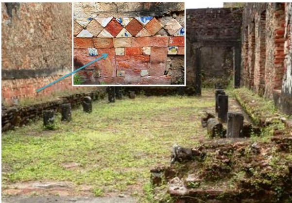
Figura 36: Ruínas do refeitório e detalhe da parede do refeitório com resquícios de azulejos.
