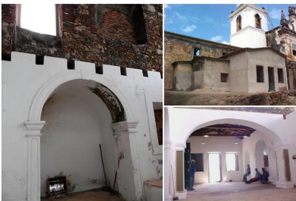
Figura 30: Sala do Capítulo e Portaria (exterior e interior)
