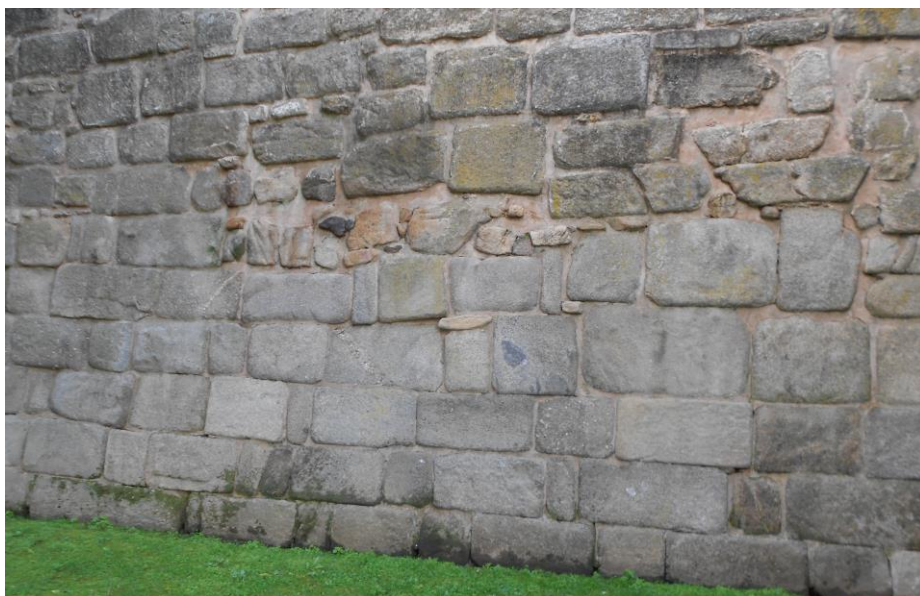
Figura XXXVI – Pormenor do aparelho construtivo das muralhas de Évora, Rua Largo dos Colegiais.
