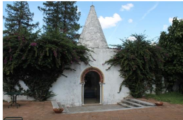
Construção com cuba, possível oratório? (Jardim do Paço)
