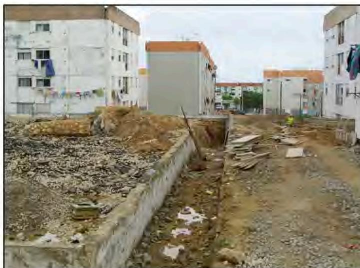
Figura 25 – Muro que desabou após a chuvada.
