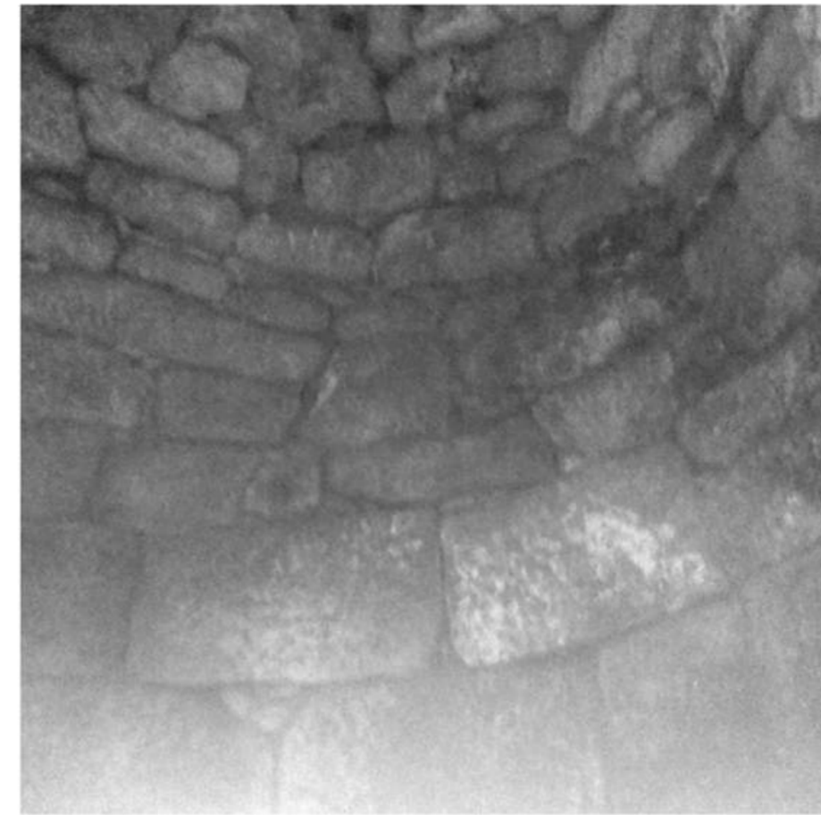
Fig. 99 - Pormenor do interior forno grande
