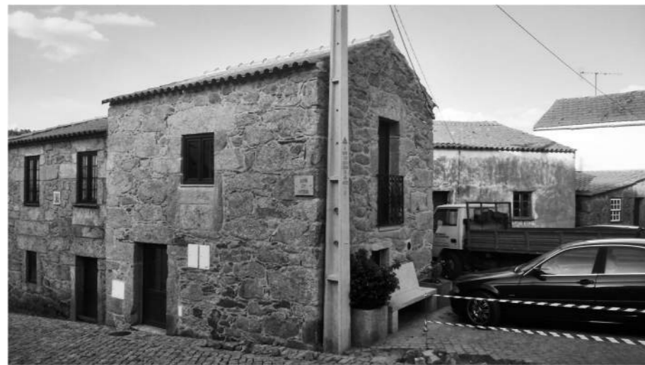
Fig. 47 - Casa do Território actualmente rehabilitada para habitação
