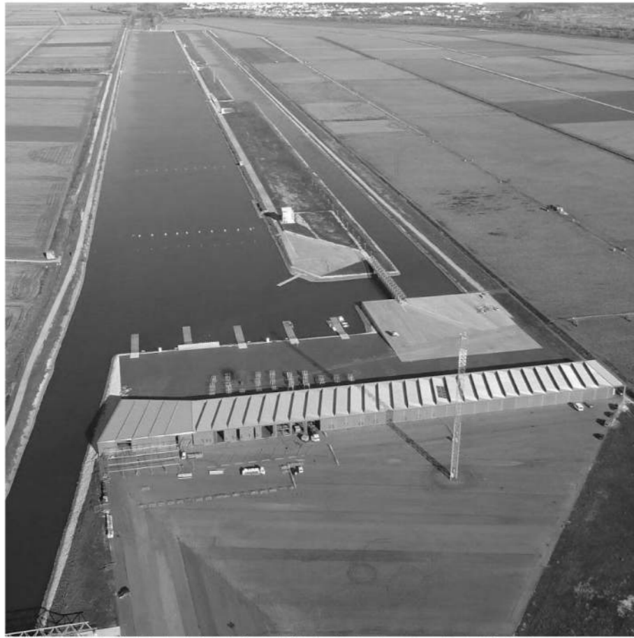
Fig. 13 - Vista aérea do Centro Náutico de Alto Rendimento integrado na paisagem do vale do Rio Mondego
