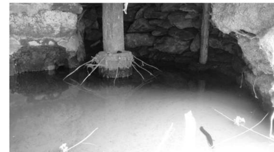
Fig. 77 - Zona inferior do cabouco onde é visível a pele que segura as penas do rodízio, actualmente submersas em lama
