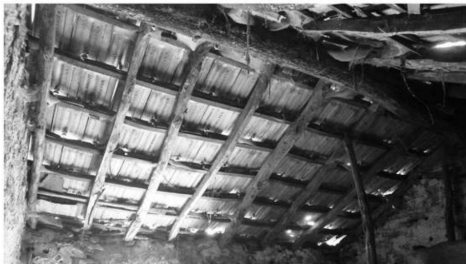
Fig. 79 - Cobertura do moinho
