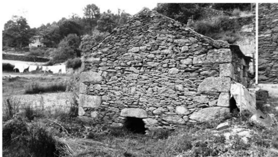
Fig. 75 - Viso do cabouco, por onde sai água do moinho de volta à ribeira
