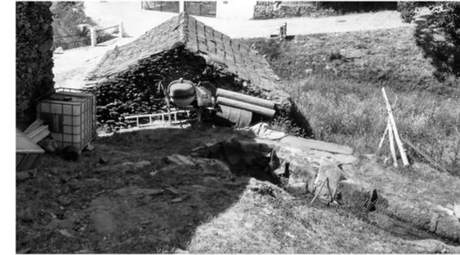
Fig. 76 - Zona de entrada da levada de água no moinho, actualmente espada
