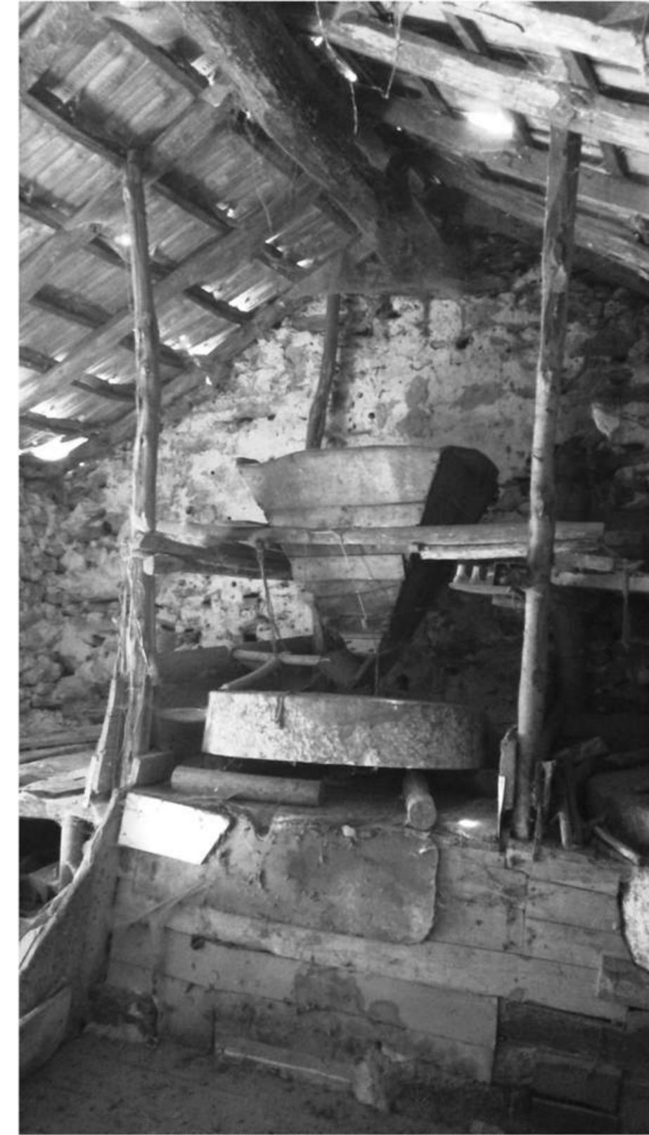
Fig. 83 - Carril (estrutura de madeira) que suporta a moenga acima da mo ambadora
