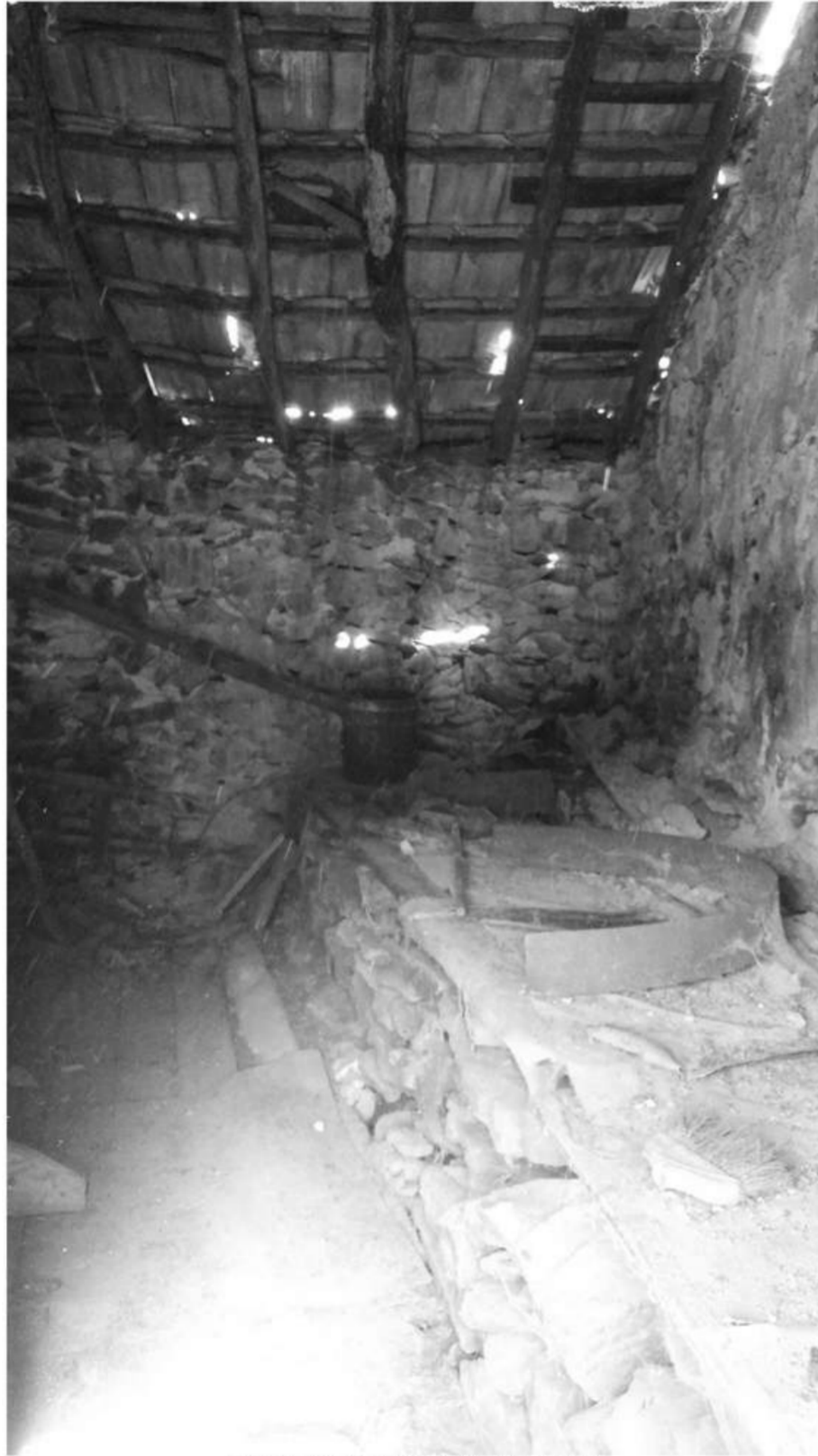
Fig. 82 - Bancada do póvil em visto e pavimento em tábuas de madeira
