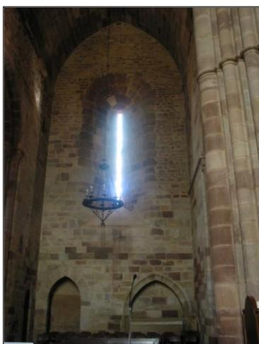
Fig. 77-Fenómenos de alteração diferencial no topo Norte do transepto
