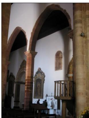
Fig. 71- Esfoliação e lascagem presente nos arcos e pilares da nave central
