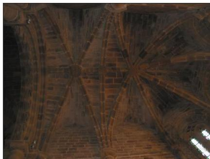
Fig. 81- Abóbada da capela-mor, nervuras preenchidas com argamassas de cimento
