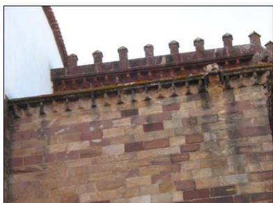
Fig.63- Fachada Sul – Pátina de sujidade e infestação liquénica
