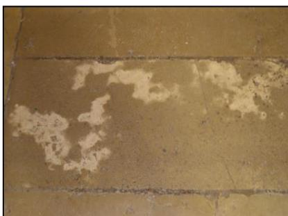
Fig. 89- Presença de eflorescências salinas no pavimento do transepto
