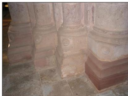
Fig. 88- Desgaste do pavimento na capela-mor devido a eflorescências salinas
