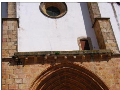
Fig. 60 – Fachada Poente – Pormenor de friso do Portal com incidência de colonização biológica, presença de arbustos e infestação líquénica
