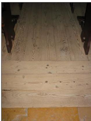
Fig. 74 – Pavimento em madeira deteriorado na nave central
