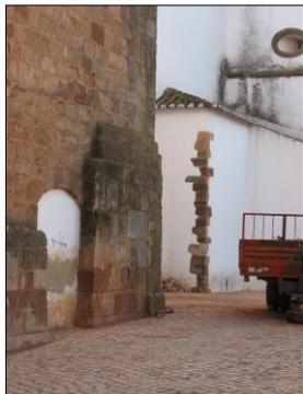
Fig. 58- Fachada Norte – Manifestação de erosão da rocha
