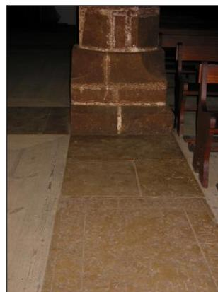
Fig. 70 – Argamassa presente nas juntas das bases das colunas da nave central
