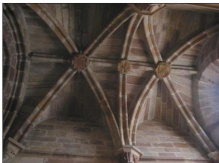
Fig. 80 – Juntas preenchidas por argamassas grosseiras, abóbada da capela-mor
