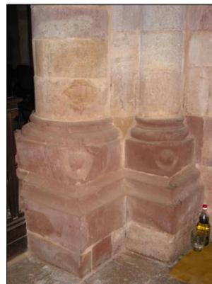
Fig. 84- Grau de arenização nas colunas, absidíolo esquerdo
