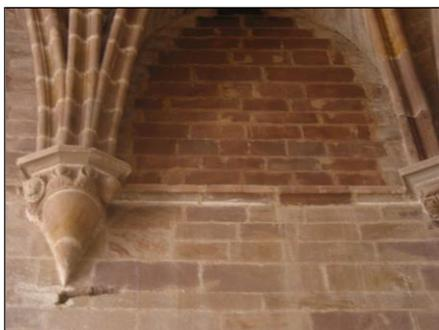
Fig. 75 – Perda de material na parede da capela-mor
