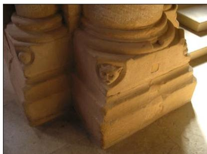
Fig.87- Capela-mor, bases das colunas com lacunas
