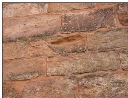
Fig.62- Fachada Sul – Erosão e degradação diferencial
