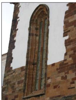
Fig.64 – Fachada Sul – Blocos substituídos devido a intervenção de restauro
