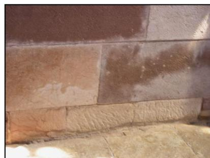
Fig. 90 – Presença de eflorescências salinas na parede da capela-mor
