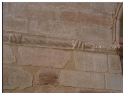
Fig. 76- Esfoliação e erosão regressiva na parede da capela-mor
