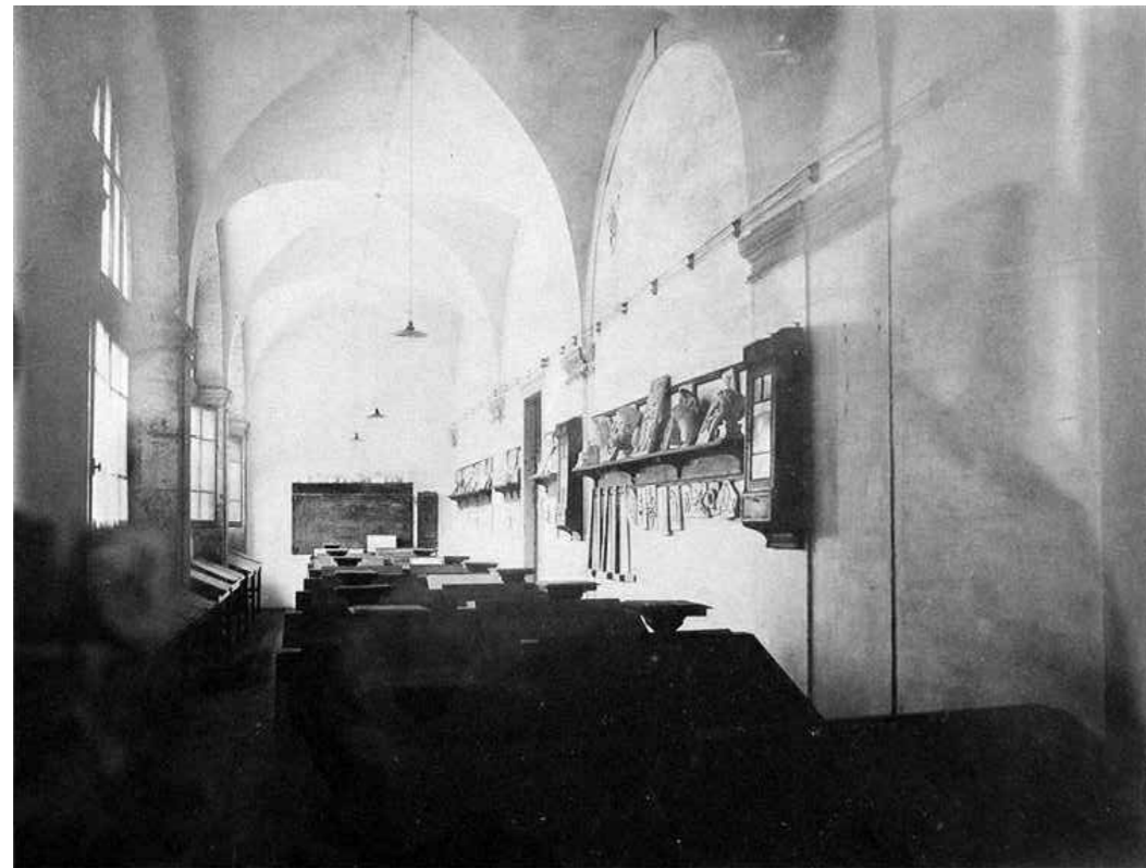
Fig.45 Deambulatório do Claustro maior transformado em salas de aula
