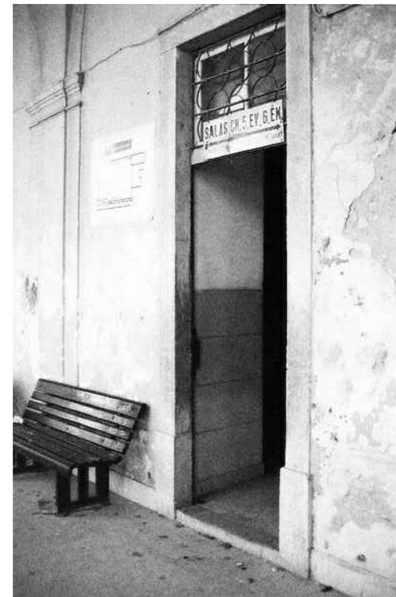
Fig.52 Espaço onde inicialmente se encontravam as Celas convertido em salas de aula
