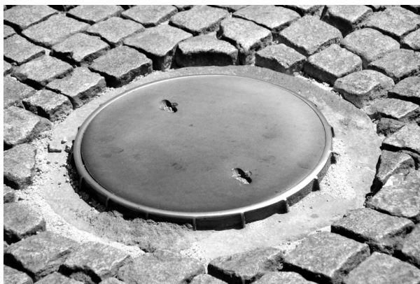
Figura 11 - Desgaste da superfície da tampa T2
