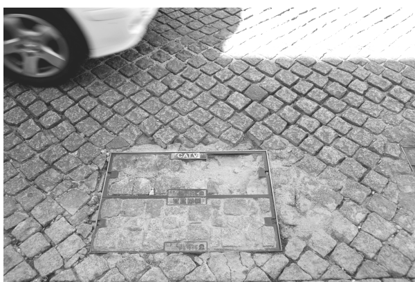
Figura 8 - Exemplo de dispositivo B125 aplicado em zona do Grupo 4 (mínimo classe D400)
