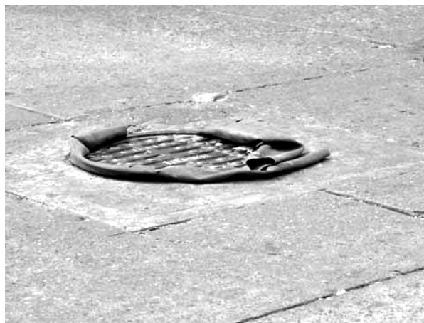
Figura 6 - Insonorização provisória da vibração das tampas com tiras de borracha
