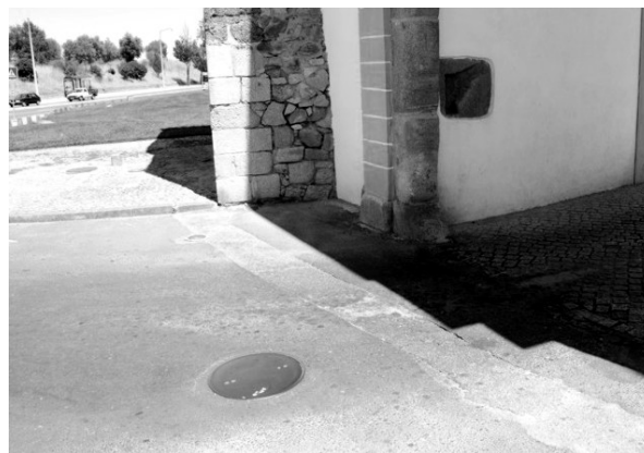
Figura 16 - Desgaste em tampa na Porta de Aviz
