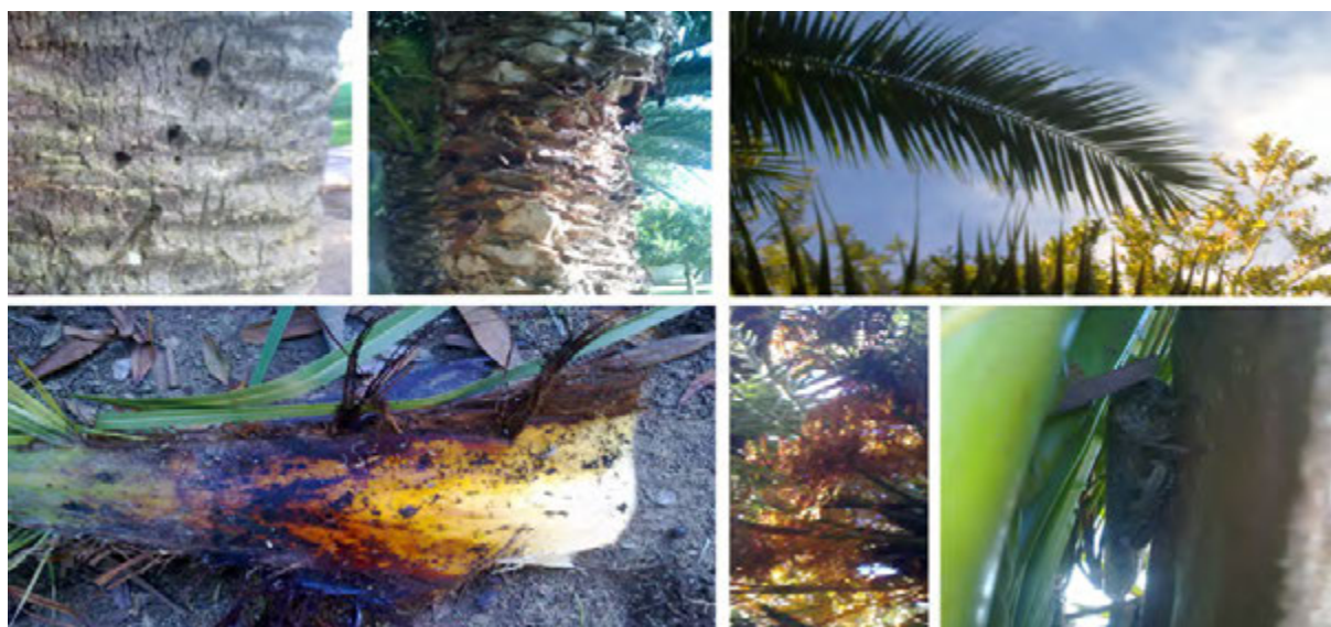
Figura. 30 - Fotografias tiradas durante a inspeção. Fonte Autor
