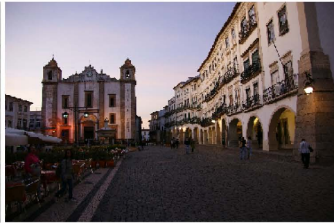
materialidade: alvenaria de pedra e reboco arcadas da praça do giraldo
