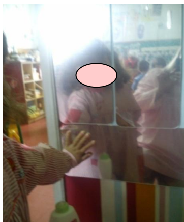
Imagem 1 - Sof. afixa o espelho na parede onde vai ser a área do cabeleireiro
