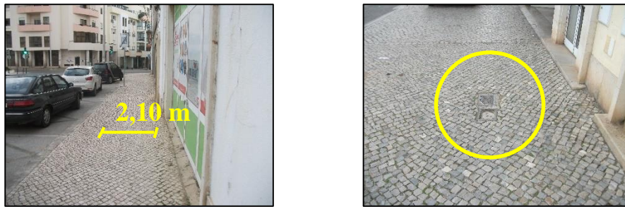
Imagem 6.14 - Subtroço n.º7 Fonte: (Autor)
