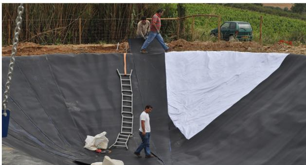
Figura 31. Fotografia da impermeabilização da charca. Fonte: Machado, 2015
