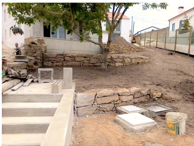
Figura 59. Construção de muros de contenção.
