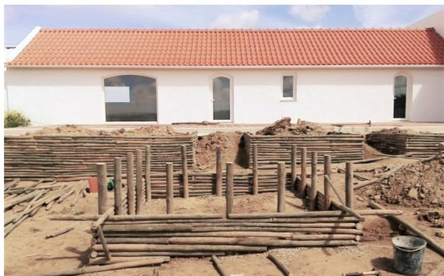
Figura 29. Fotografia da construção dos canteiros em toros de madeira. Fonte: Machado, 2015
