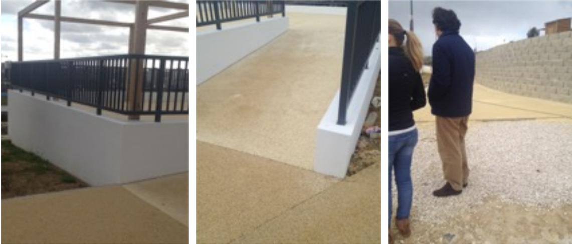
Imagem 81, 82 e 83: respetivamente: área sobrelevada de miradouro; rampa de acesso e pavimento em betão colorido; área semi-permeável em betão colorido. Fonte: Autor
