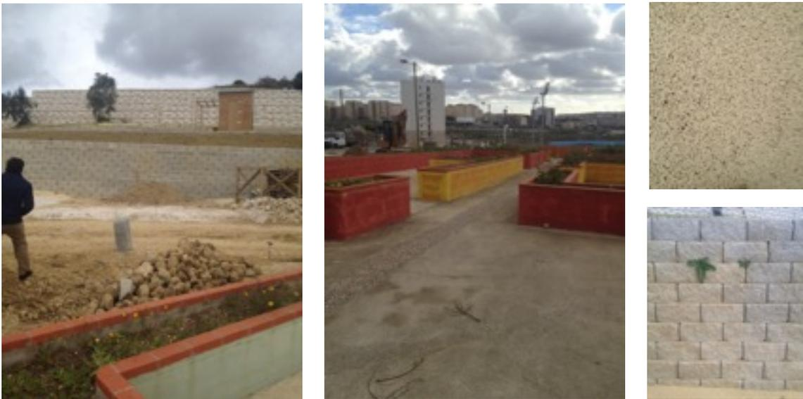
Imagem 84, 85, 86 e 87: respetivamente: área pavimentada em construção; módulos hortícolas acessíveis; betão colorido; muro em betão bajulado a pico médio. Fonte: Autor
