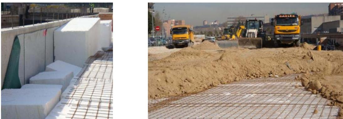
Fig. 16 – Imagens da obra na zona onde foi usado o Poliestireno Expandido.
