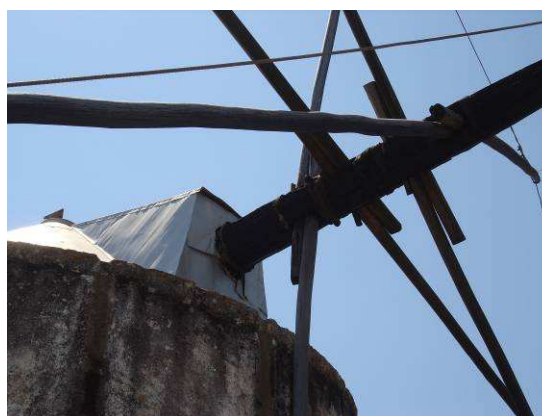
Ilustração 33 - Exemplo da parte exterior do mastro - moinho MV027.
