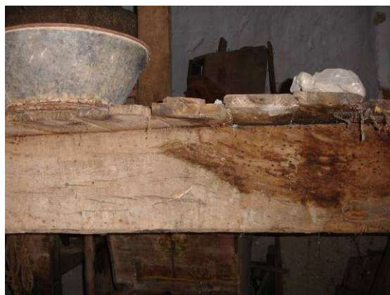
Ilustração 31 - Exemplo de viga mestra e tabuado em madeira - moinho MV035.
