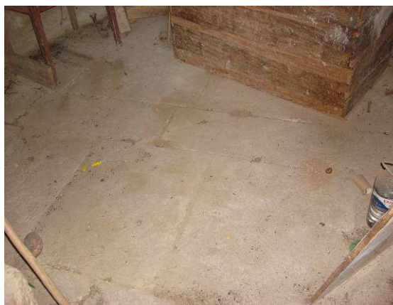
Ilustração 30 - Exemplo de pavimento térreo em lajes de pedra - moinho MV028.
