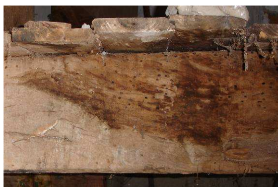
Ilustração 43 – Exemplo de degradação pela acção do caruncho - moinho MV035.
