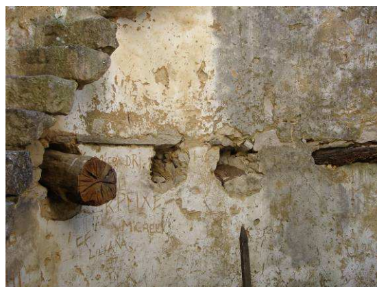
Ilustração 26 - Exemplo de reboco interior em parede - moinho MV032.
