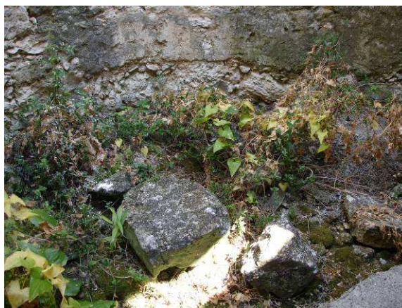
Ilustração 20 - Pormenor da fundação no interior - moinho MV033.
