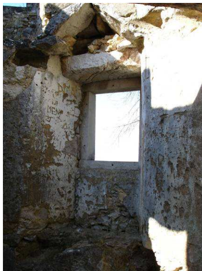
Ilustração 29 - Exemplo de verga de muralha - moinho MV032.
