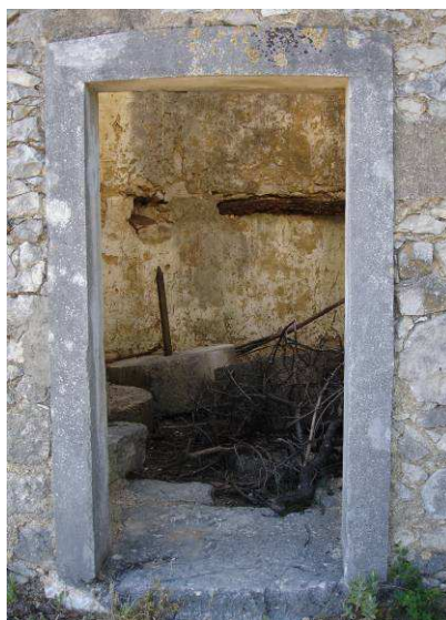
Ilustração 28 - Exemplo de moldura de porta em cantaria aparelhada - moinho MV032.
