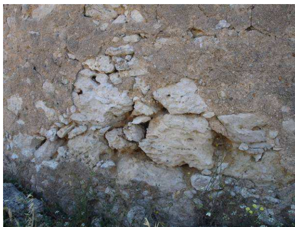
Ilustração 25 - Exemplo de reboco exterior em parede - moinho MV037.
