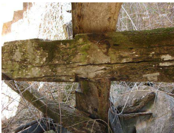
Ilustração 42 – Exemplo de degradação pela acção de fungos e luz solar - moinho MV037.
