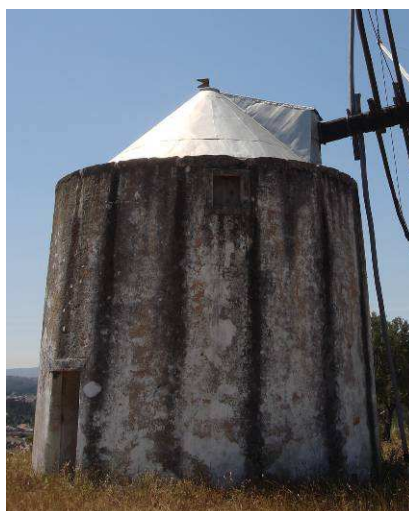
Ilustração 34 - Exemplo do capelo em chapa de zinco - moinho MV027.
