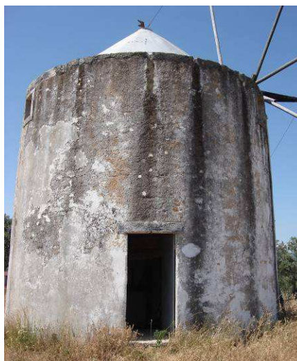
Ilustração 27 - Exemplo de pintura à base cal - moinho MV027.
