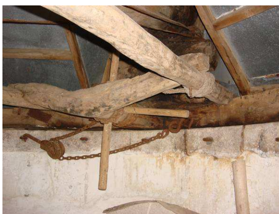
Ilustração 35 - Exemplo de frontal e sarilho - moinho MV027.
