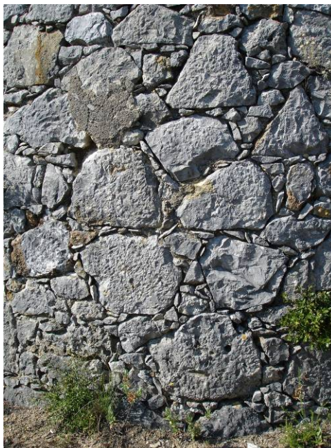
Ilustração 21 - Exemplo de disposição da alvenaria das paredes - moinho MV032.
