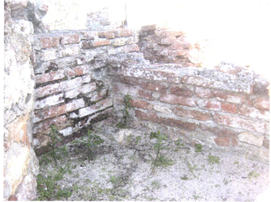
Fig. 40 – Murete em opus testaceum totalmente reconstruído na década de 50-70 (século XX).
