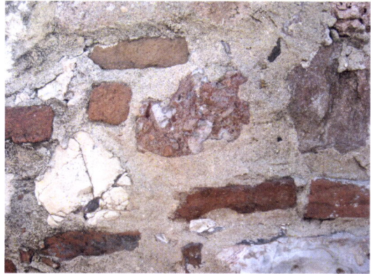
Fig. 41 e 42 – Duas vistas da reconstrução parcial do pano exterior da abside do caldarium
