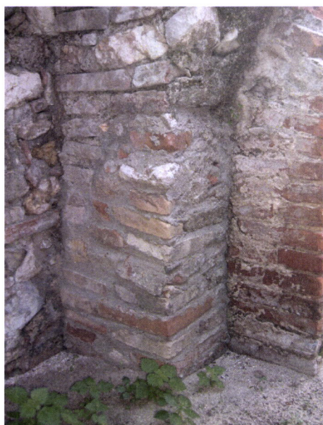
Fig. 37 - Reconstrução total de um pilar ( caldarium )
