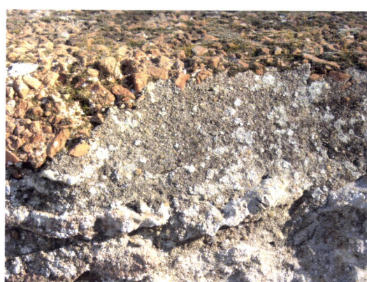
Fig.8 – Pormenor da consolidação e remate de um revestimento (cisterna)
