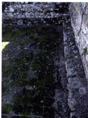
Fig. 13 – Sala dos Três Pilares
