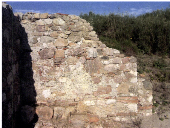
Fig.3 – Pormenor de uma parede construída em opus mixtum
