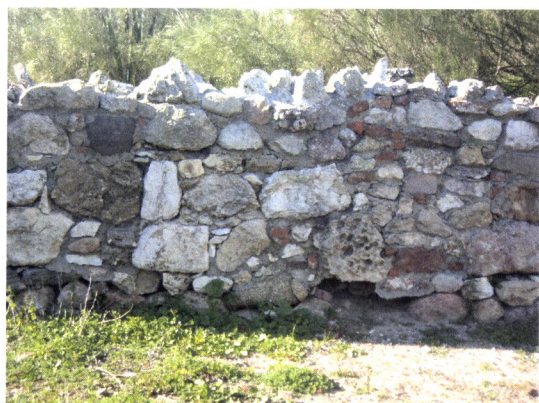
Fig. 7 – Exemplo de uma intervenção para protecção duma parede através da reconstrução de duas fiadas de pedra
