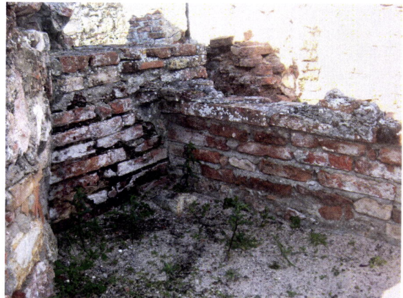
Fig. 28 – Exemplo de reconstrução utilizando os materiais construtivos originais ( anastylosis ) assentes com uma argamassa cinzenta (século XX)
