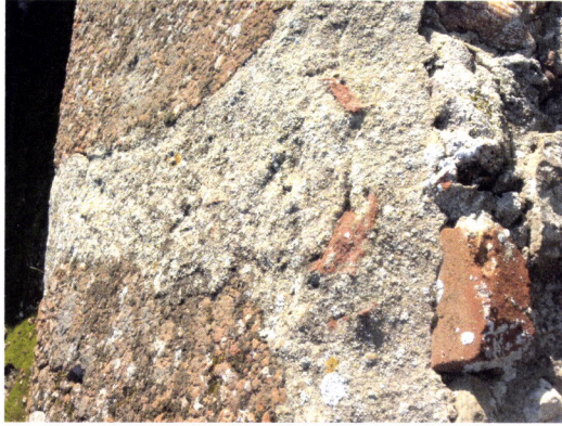
Fig.39– Detalhe da aplicação de uma argamassa de cimento para preenchimento de lacunas e remte de revestimento da cisterna
