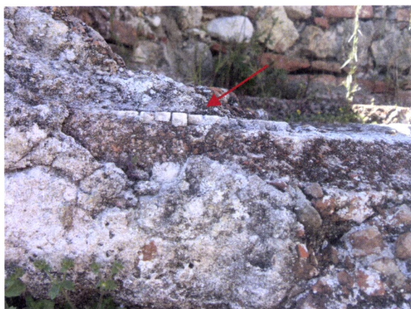
Fig. 25 – Pormenor da reparação do pavimento em mosaico da piscina do caldarium com uma argamassa hidráulica.
