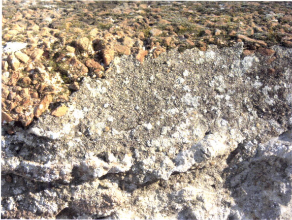
Fig. 27 – Revestimento da cisterna consolidada com uma argamassa cinzenta (século XX)
