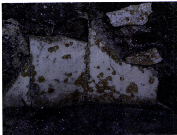
Fig. 16 – Pormenor do revestimento em mármore da piscina ( frigidarium )
