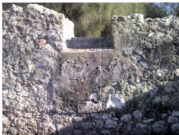
Fig. 38 - Consolidação e reconstrução de um dos lucernários da Sala dos 3 Pilares
