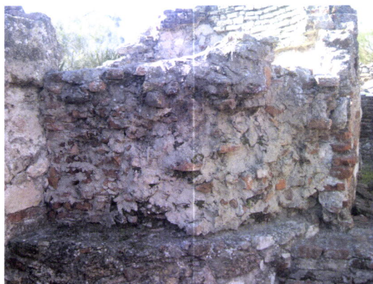
Fig.36 - Solução adoptada para consolidar a abside do praefurnium , utilizando argamassa de coloração cinzenta aplicada grosseiramente.
