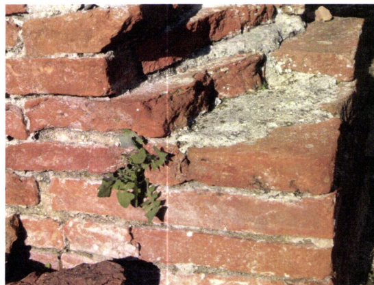
Fig.4 - Pormenor de uma parede construída em opus testaceum
