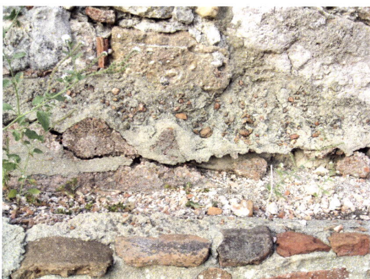
Fig.43 e 44 – Um dos exemplos de incompatibilidade: revestimento do apoditherium consolidado com argamassa cimentícia; observam-se destacamentos.
