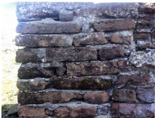
Fig.5 – Exemplo de um refechamento de junta (parede do caldarium )
