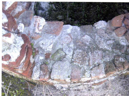
Fig.6 – Exemplo de uma reconstrução parcial (parede do caldarium )
