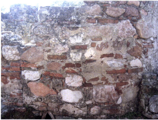
Fig. 41 e 42 – Duas vistas da reconstrução parcial do pano exterior da abside do caldarium
