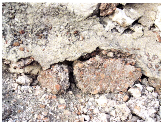
Fig.43 e 44 – Um dos exemplos de incompatibilidade: revestimento do apoditherium consolidado com argamassa cimentícia; observam-se destacamentos.
