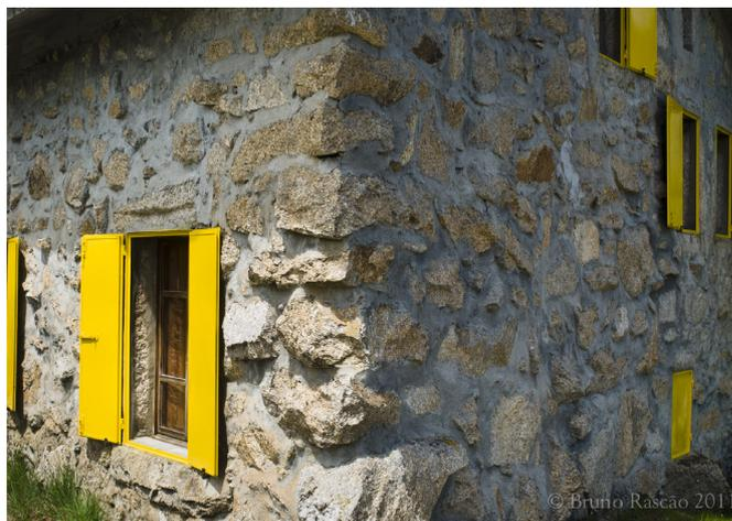
figura 194 - pormenor da parede. a distribuição das janelas surge da organização interior da casa, construída de dentro para fora . fonte: BR
