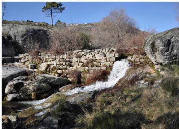
figura 152 - descarregador de superfície da represa de baixo. fonte: NR
