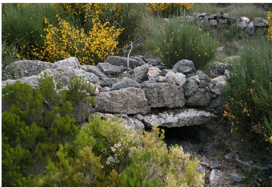
figura 179 - passagem de água sob a levada antiga poente. fonte: LAB
