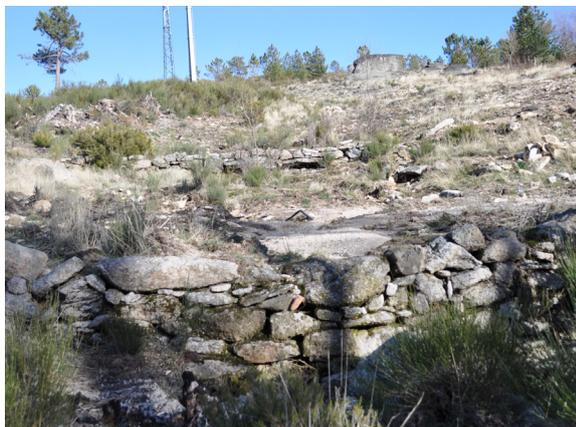
figura 132 - muros que represa a água da linha de drenagem, travando-a e retendo como um filtro a folhada e os sedimentos. fonte: NR
