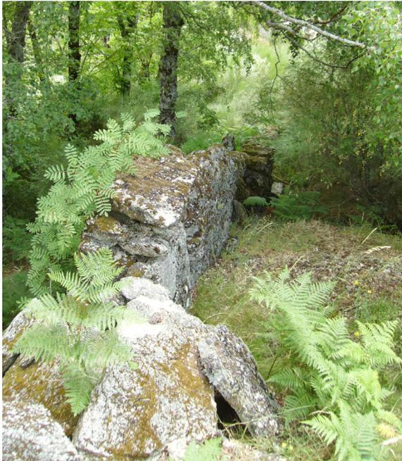
figura 222 - murete construído na encosta poente com pedras da levada de baixo poente. fonte: LAB
