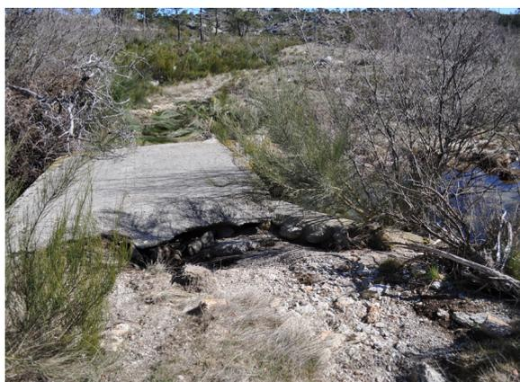
figura 125 - vista de oeste sobre a ponte em betão. é notória a degradação do arranque do caminho junto à ponte. fonte: NR
