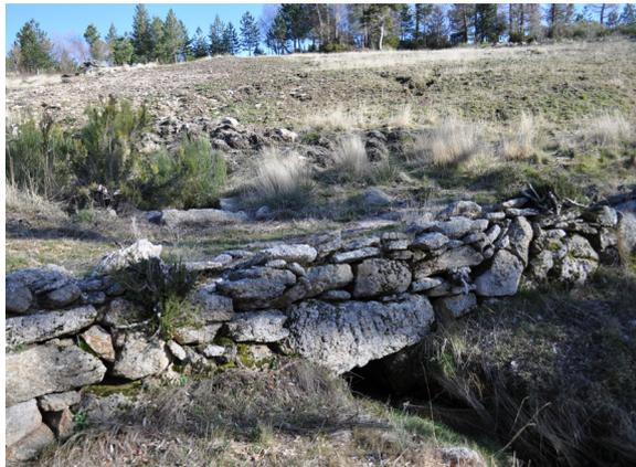
figura 131 - a água da linha de drenagem, que delimita a norte os solos agrícolas nascente, é conduzida por um canal em pedra sob a levada do meio. fonte: NR
