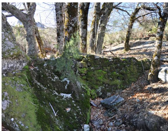
figura 172 - muro represa na linha de drenagem representada no corte E - F. fonte: NR
