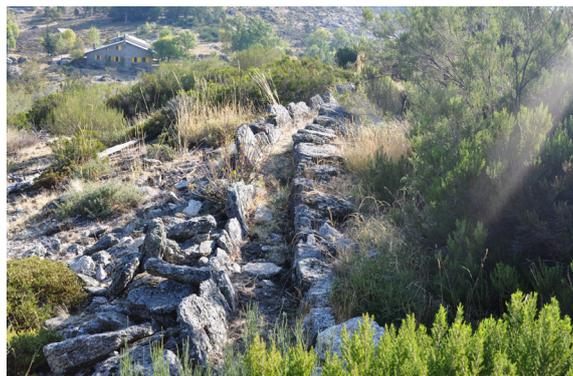
figura 175 - levada antiga poente com canal com lajes a cutelo. fonte: LAB
