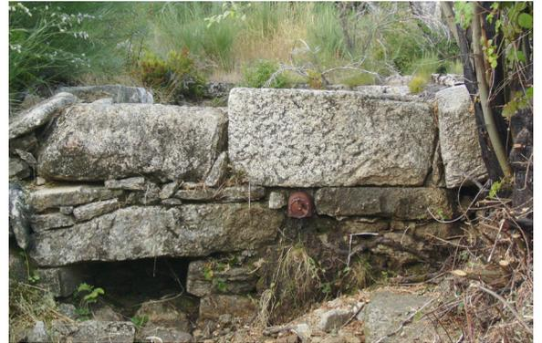
figura 145 - cabeceira da levada / descarregador de fundo do tanque de armazenamento. fonte: LAB
