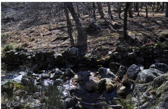
figura 219 - troços destruídos do muro de contenção da ribeira da Água Fria. fonte: NR
