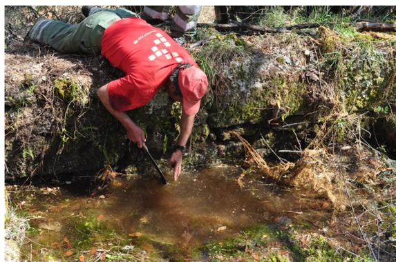
figura 234 - desobstrução do descarregador de fundo do tanque poente. fonte: LAB
