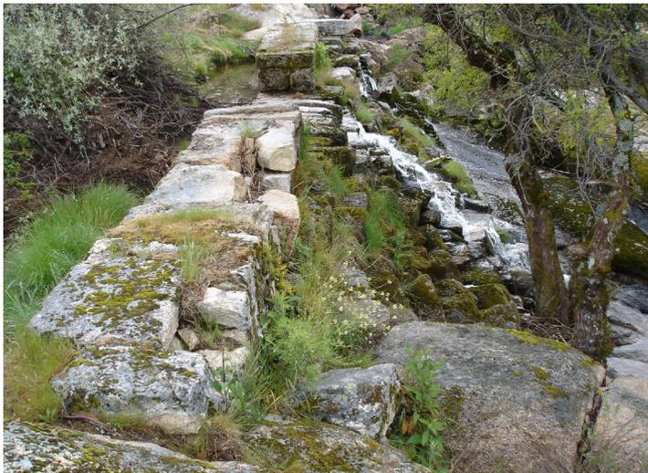
figura 120 - vista lateral da represa evidenciando o perfil escadado. fonte: NR
