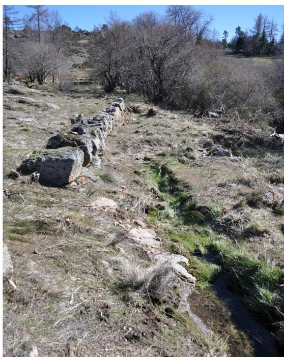
figura 238 - levada de adução do tanque do meio assoreada. fonte: NR
