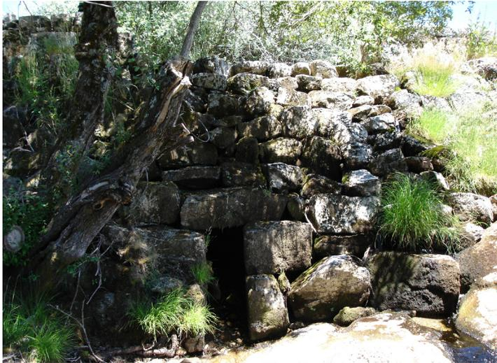
figura 119 - descarregador de fundo. fonte: LAB
