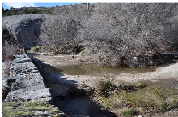
figura 232 - assoreamento na represa de baixo. fonte: NR
