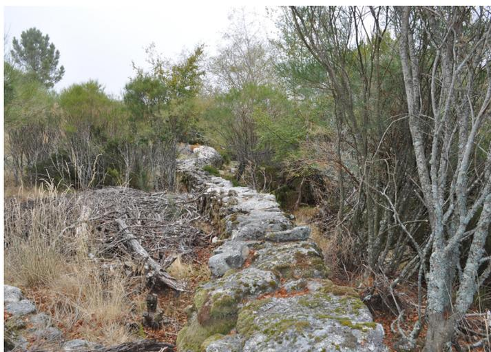
figura 111 - muros de contenção no troço norte da ribeira do Covão do Teixo. fonte: LAB
