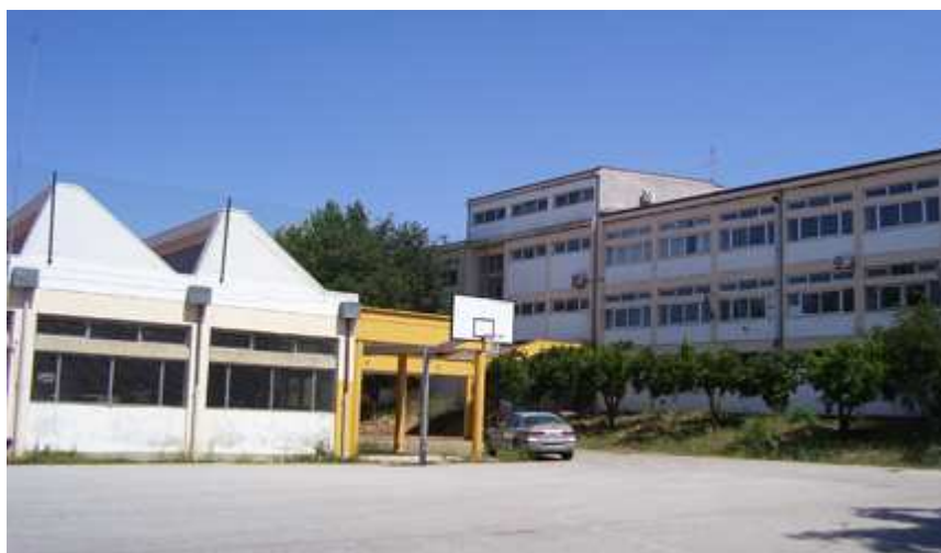
Imagem 21 - Escola Secundária Rainha Santa Isabel antes da intervenção pela empresa Parque Escolar
