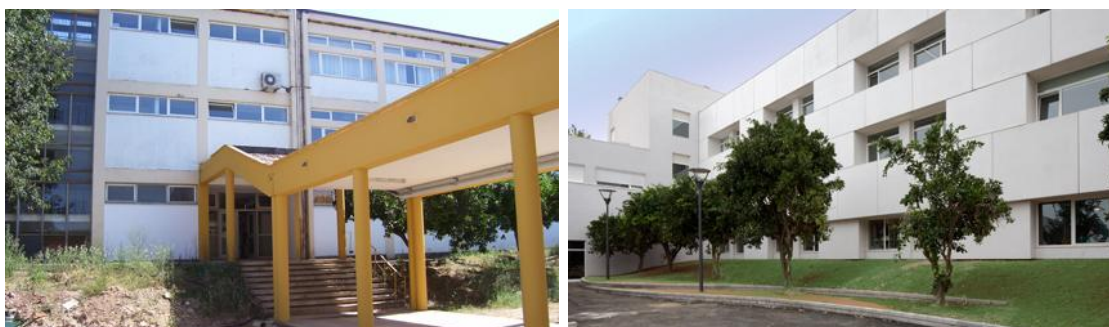
Figura 8 – A Escola antes e depois da intervenção da Parque Escolar E.P.E.
