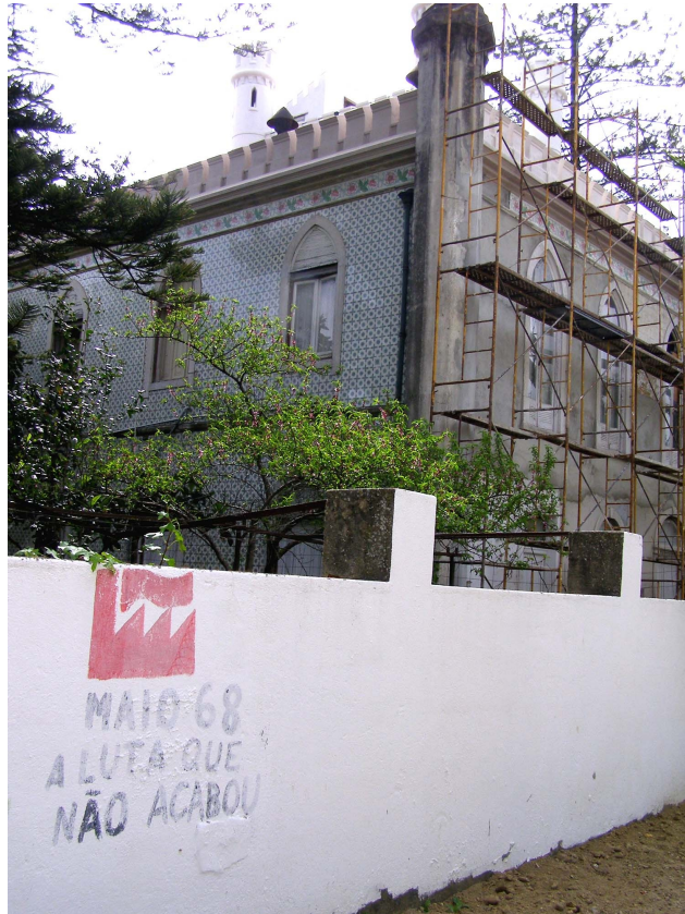
Maió 68 A luta que não acabou, Faculdade de Farmácia da UL, 2009.
