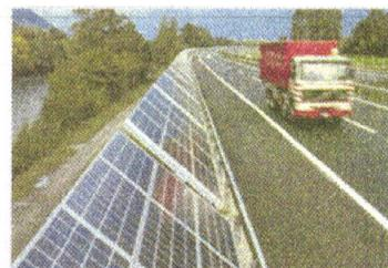
**Figura 2.72 - Barreira de som com painéis fotovoltaicos, extraído de [19]**
