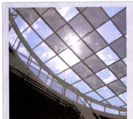
**Figura 2.73 - Integração de painéis fotovoltaicos numa cobertura, extraída de [4]**
