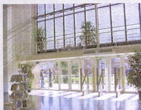
**Figura 2.74 - Integração de 300m<sup>2</sup> de painéis fotovoltaicos na fachada da Biblioteca Pompeu Fabra de Mataró, Catalunha, extraída de Oliveira (2000)**
