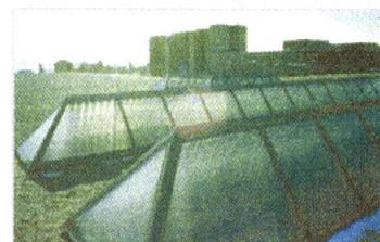
**Figura 2.70 - Cobertura utilizando células semitransparentes, extraída de [19]**
