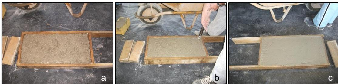
**Figura 24 - Colocação (a), vibração (b) e regularização (c) da superfície do betão**
