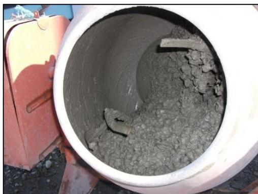
**Figura 14 - Mistura dos materiais para o fabrico do betão**
