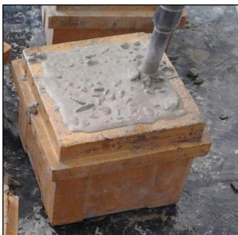
Figura 25 -Vibração do betão com auxílio de agulha vibratória
