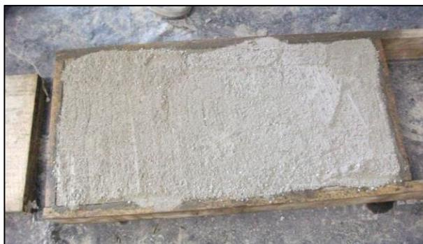
**Figura 36 - Endurecedor espalhado sobre a superfície do betão**
