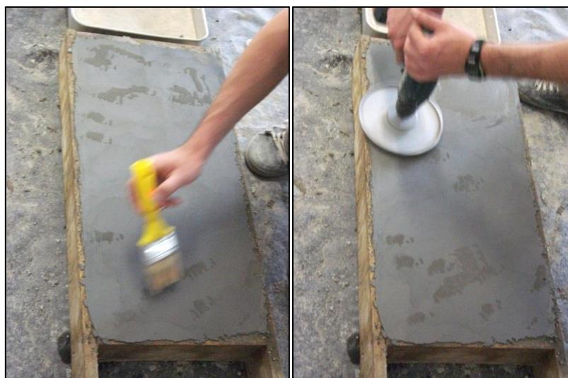
**Figura 42 - Salpico de água para correcção de imperfeições e eliminação de rugosidades**
