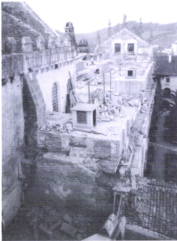
107. Dormitório: demolição do piso superior (Noviciado). (Arquivo da DGEMN)
