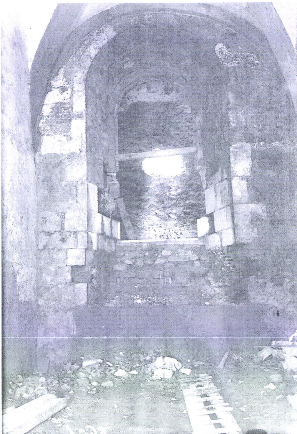
134. Sala dos Monges: desobstrução da janela da Cozinha (Arquivo da DGEMN)
