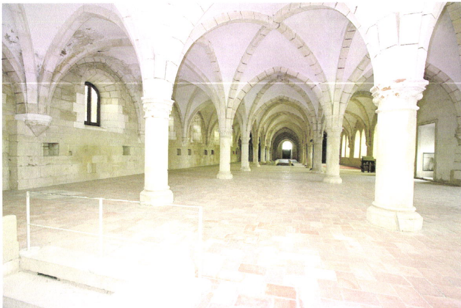
51. Dormitório (estado actual)
