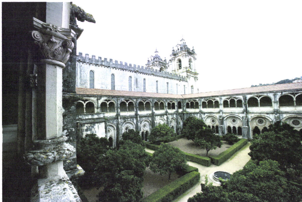
33. Claustro de D. Dinis: vista do segundo piso (estado actual)
