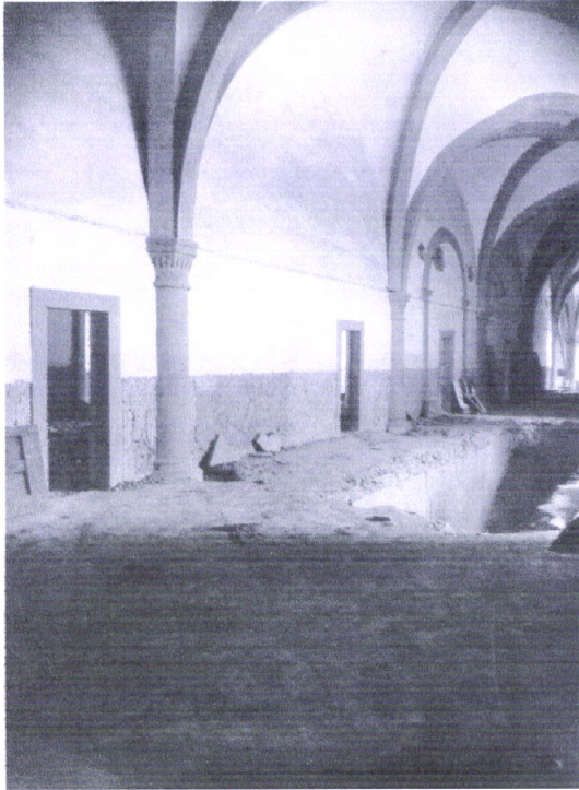
128. Obras no Dormitório: corredor central e fosso da escada (Arquivo da DGEMN)
