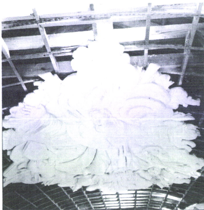
104. Sacristia: colocação do painel central (S. Bernardo) do tecto (Arquivo da DGEMN)
