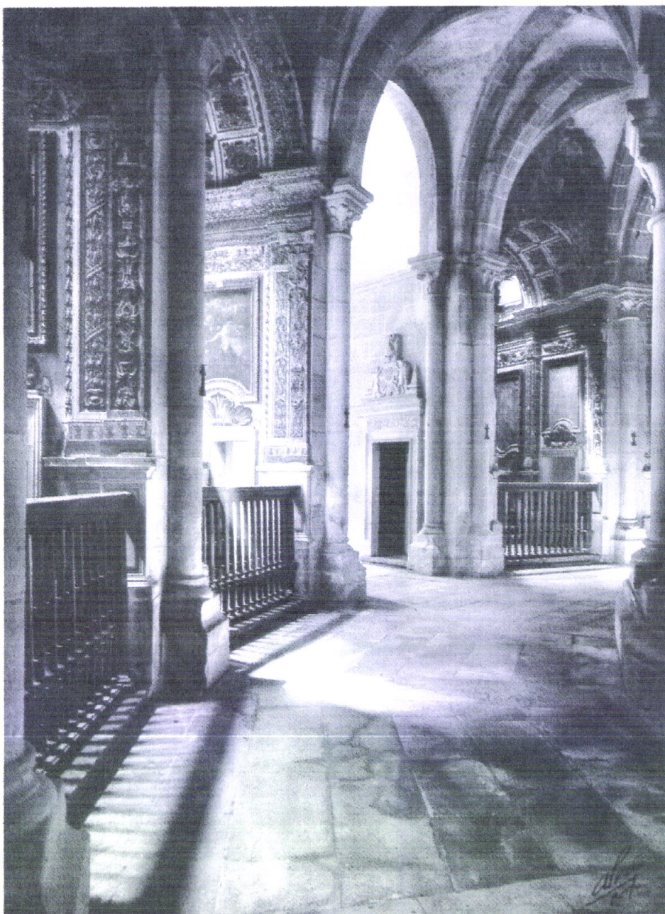
94. Interior da Igreja: capelas do Deambulatório antes do restauro (Arquivo da DGEMN)
