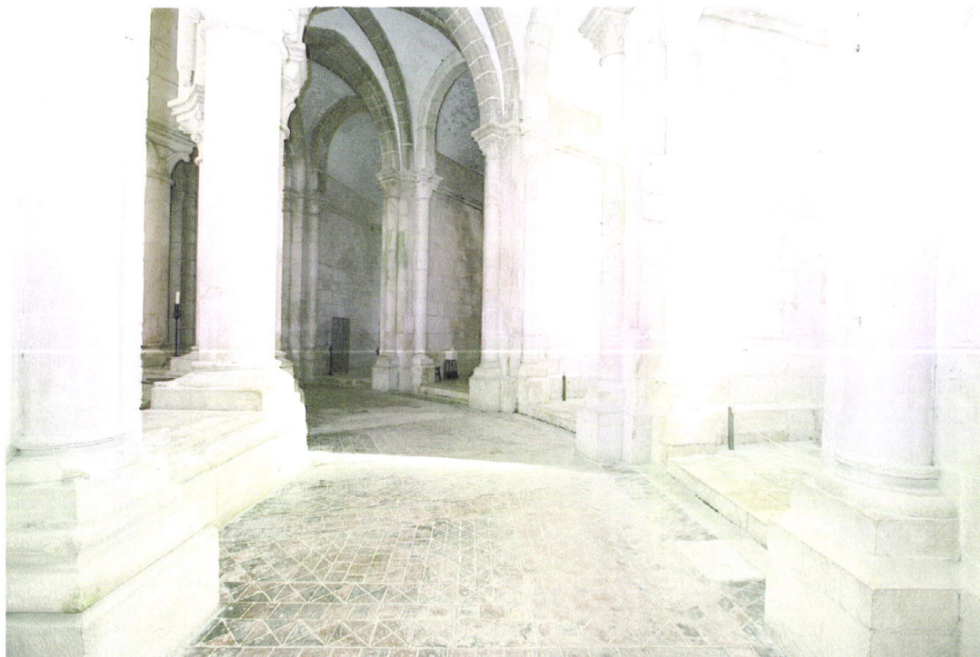
9. Deambulatório e capelas (estado actual)
