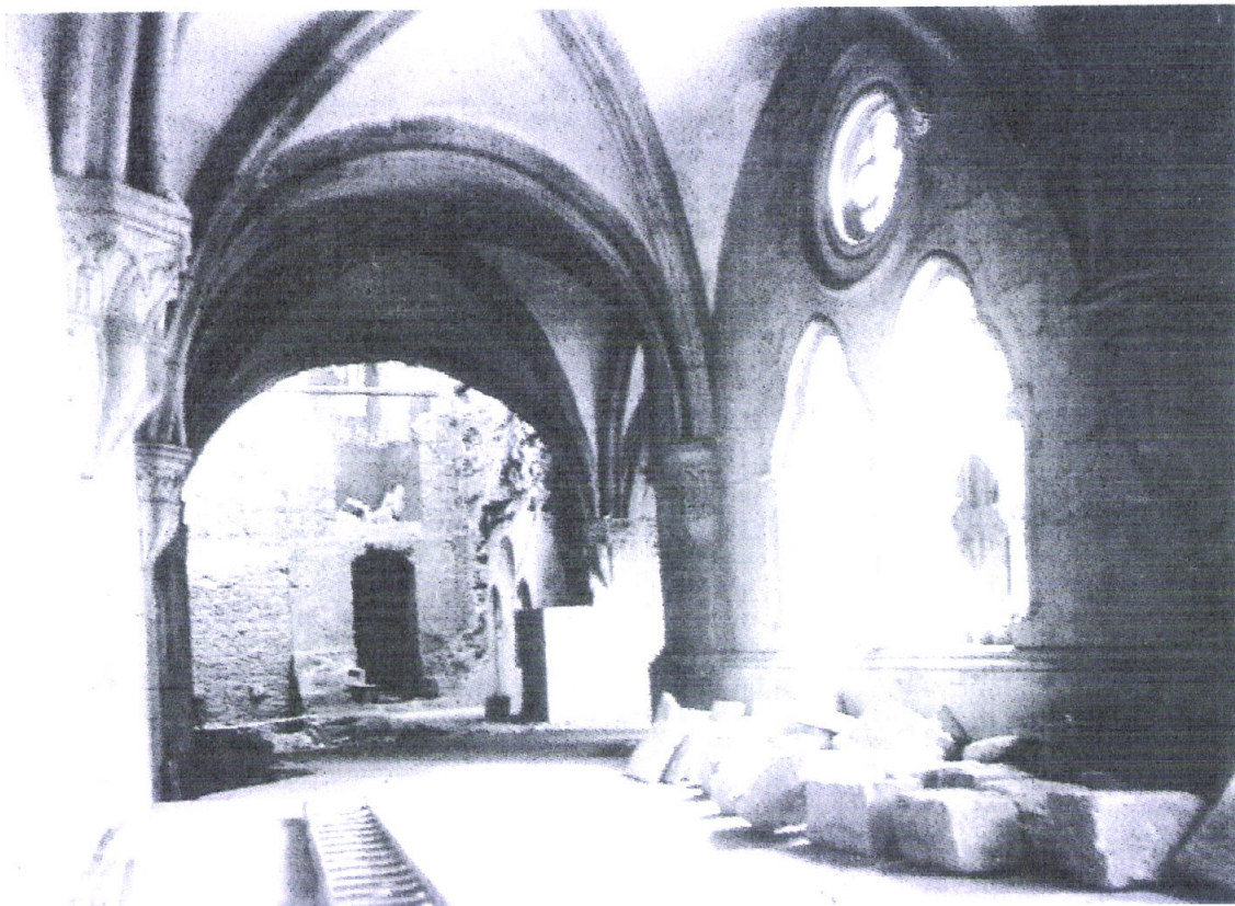
131. Claustro de D. Dinis: galeria junto ao Parlatório (Arquivo da DGEMN)
