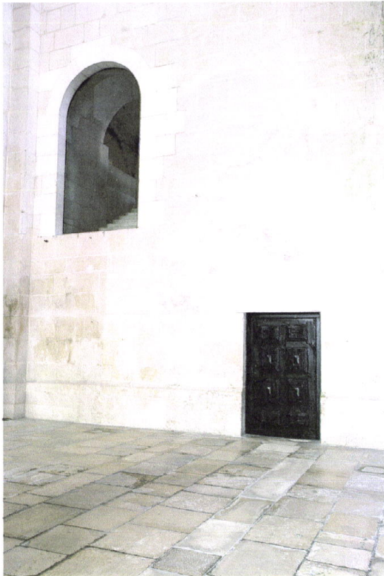
24. Braço norte do transepto: vão do Dormitório e porta da Sacristia Primitiva escondida pelo Altar do Arcanjo S. Miguel antes das obras da DGEMN (estado actual)
