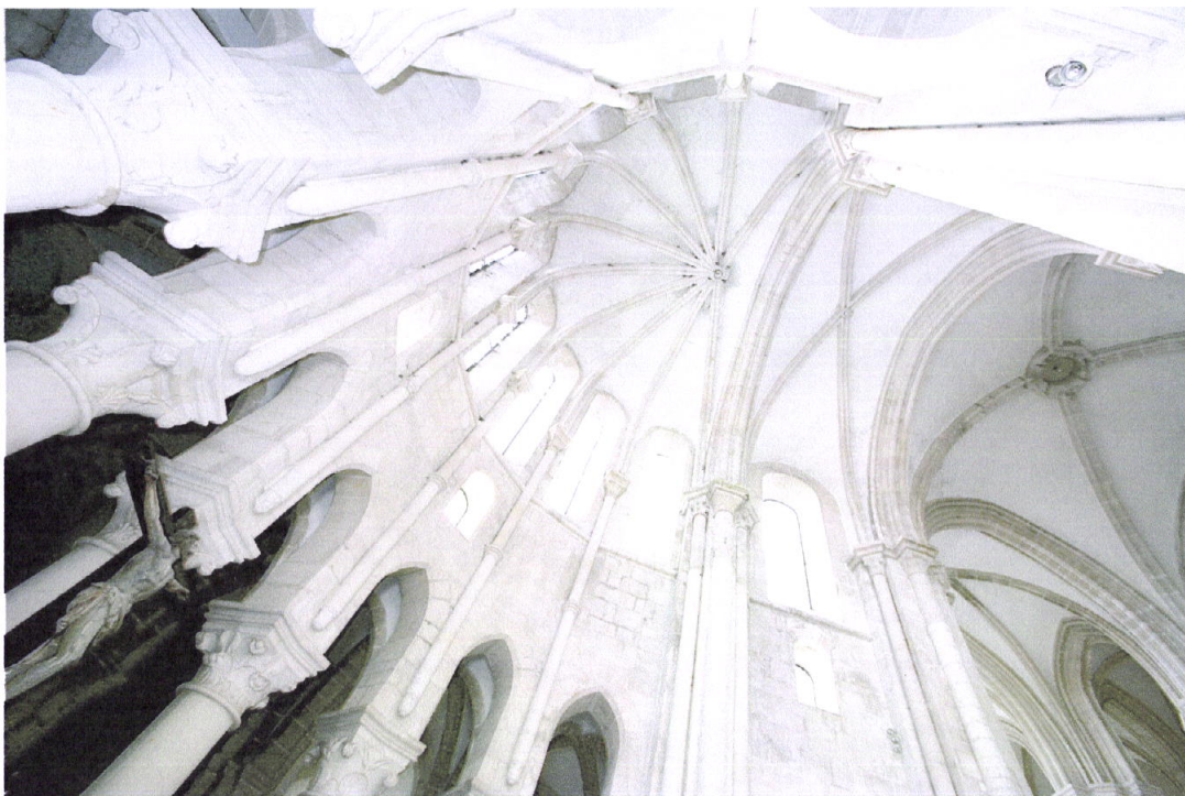
6. Capela-mor: abóbada (estado actual)
