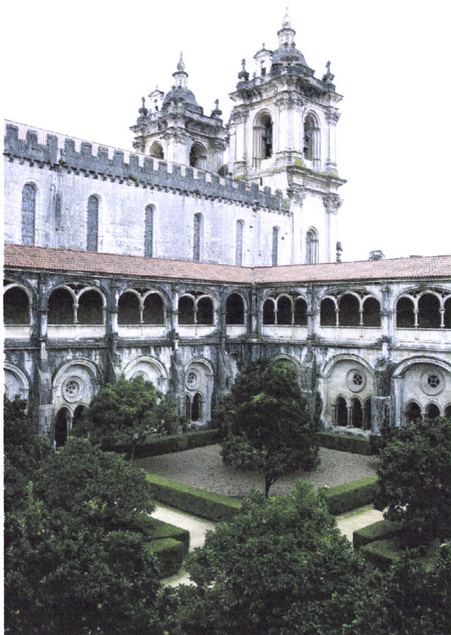
segundo piso (estado actual)
