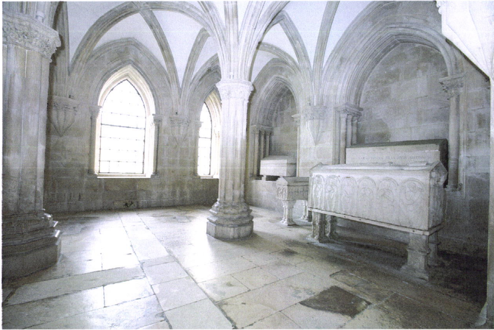
72. Sala dos Túmulos (estado actual)
