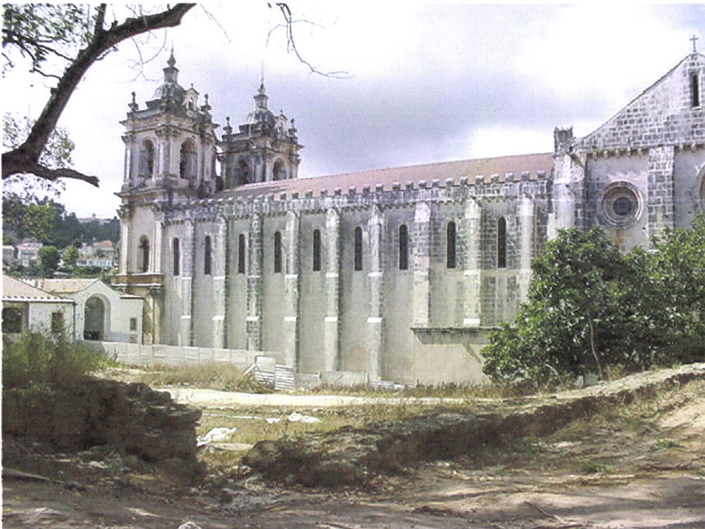
87. Corpo da Igreja – fachada sul
