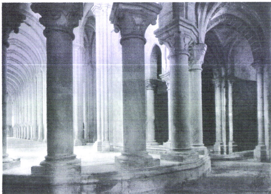
96. Interior da Igreja: nave central vista do Deambulatório (Arquivo da DGEMN)
