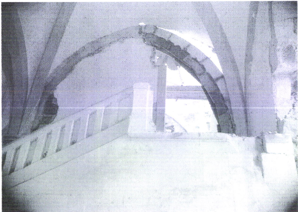
127. Dormitório: reconstrução do arco ogival junto da parede do transepto. (Arquivo da DGEMN)
