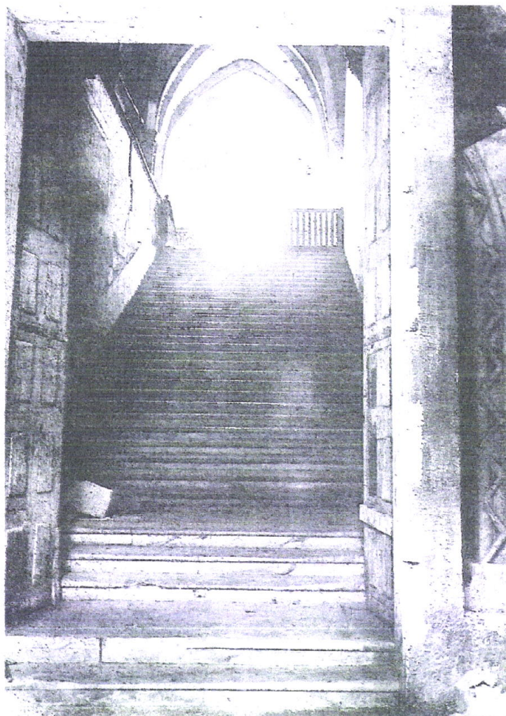
112. Escada de acesso do Claustro D. Dinis ao Dormitório antes das obras de demolição da DGEMN. (Frei Manoel dos Santos, 1710)
