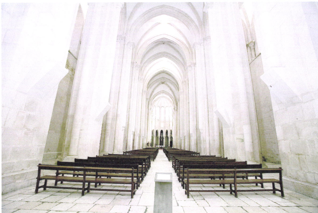
26. Interior da Igreja: nave central (estado actual)
