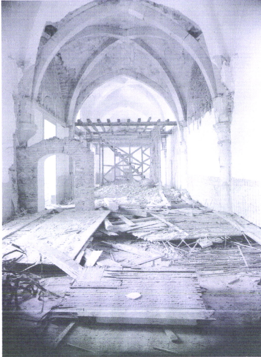
122. Obras no Dormitório: remoção das divisórias. (Arquivo da DGEMN)
