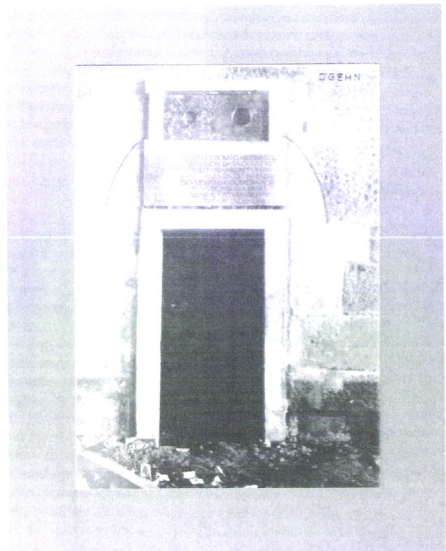
140. Refeitório: vão alterado pela DGEMN (Arquivo da DGEMN)
