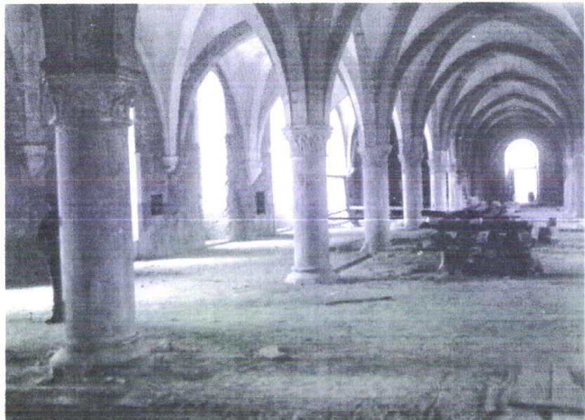
129. Dormitório: interior após as obras (Arquivo da DGEMN)
