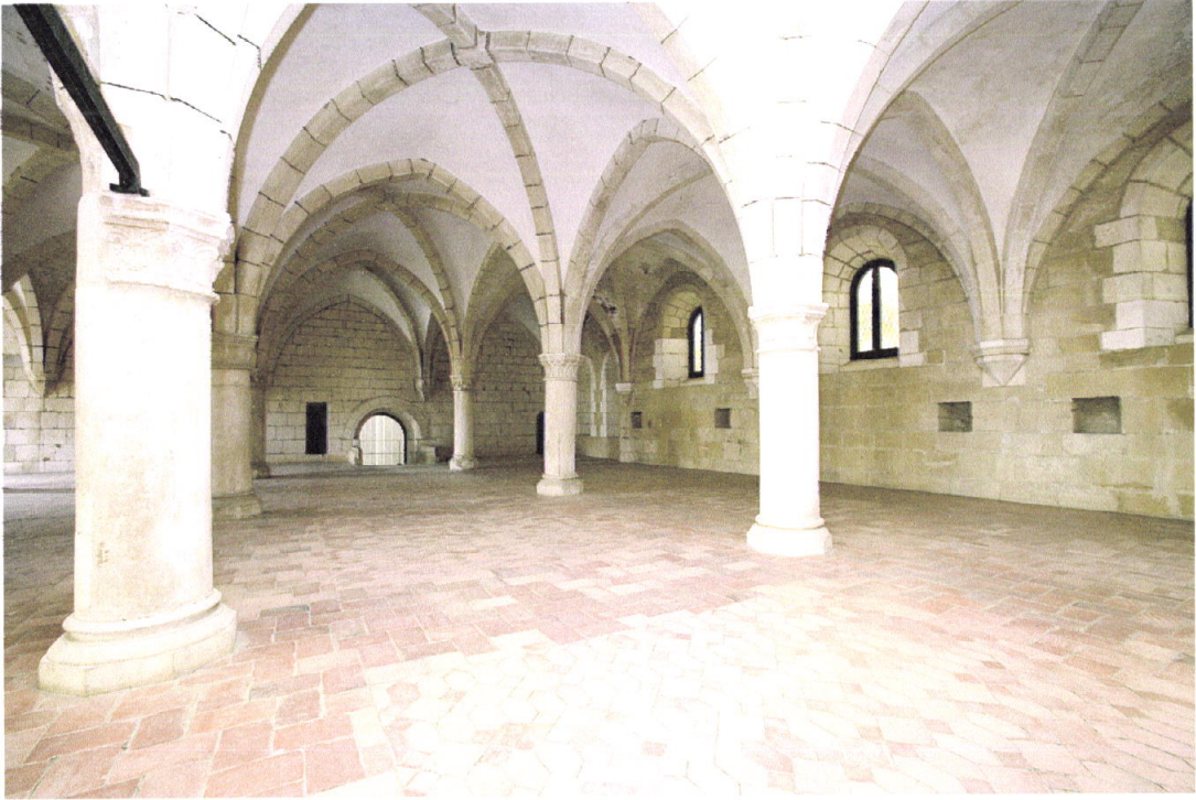
48. Dormitório (estado actual)
