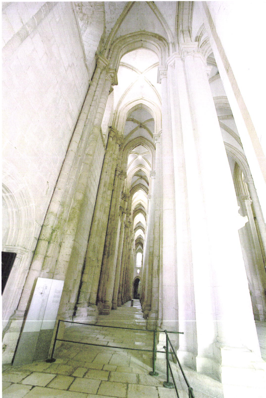
30. Interior da Igreja: nave lateral norte (estado actual)
