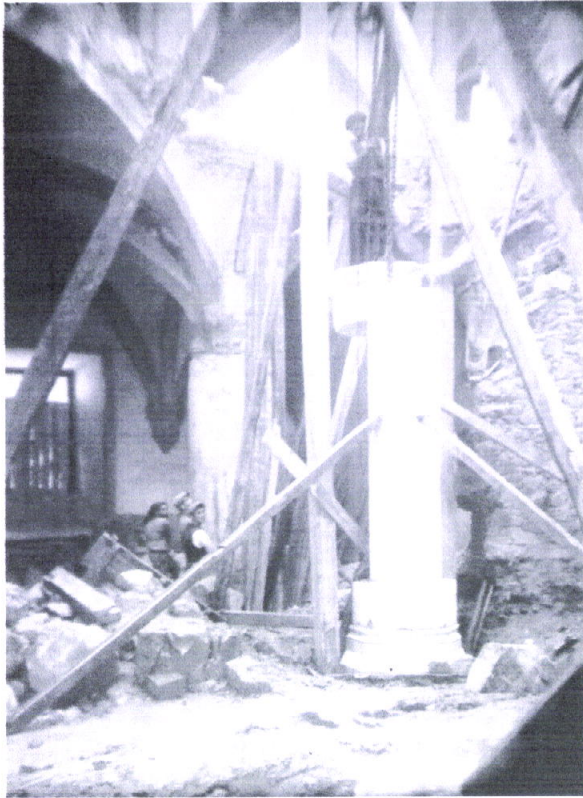
110. Sala do Capítulo: montagem de coluna e elevação do capitel (Arquivo da DGEMN)
