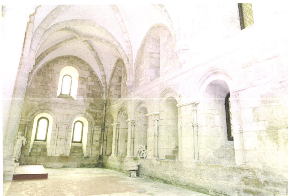
57. Refeitório: parede contígua à Cozinha (estado actual)
