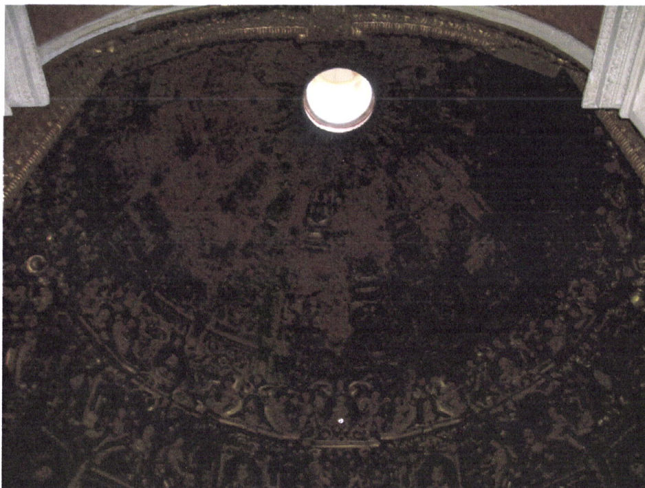
68. Capela dos Relicários: cobertura abobadada. (estado actual)
