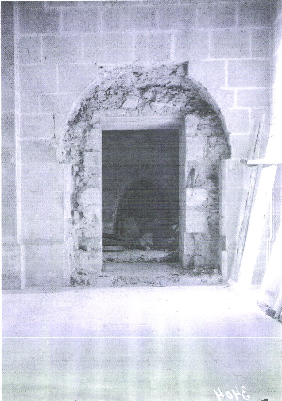
125. Interior: vão de porta sem cantarias (Arquivo da DGEMN)
