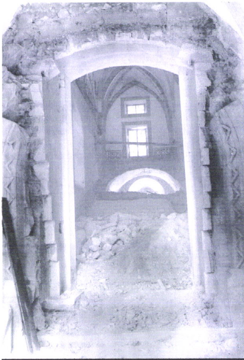
113. Dormitório: remoção da escadaria de pedra de acesso ao claustro (Arquivo da DGEMN)
