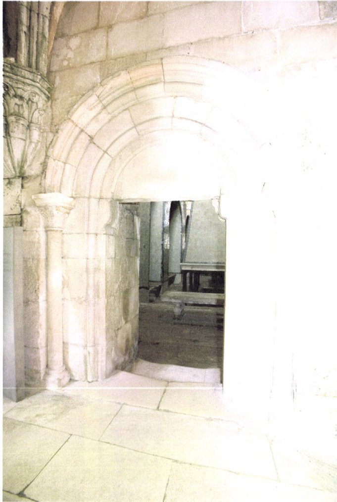
78. Pórtico da Cozinha
