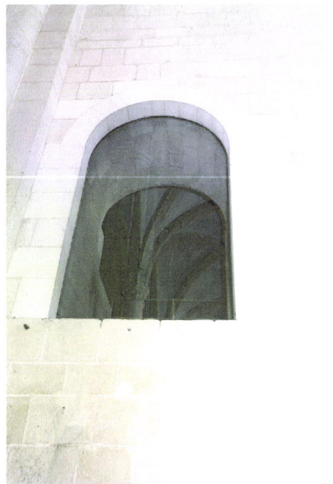
25. Vão do Dormitório de onde partia a Escada das Matinas (estado actual)
