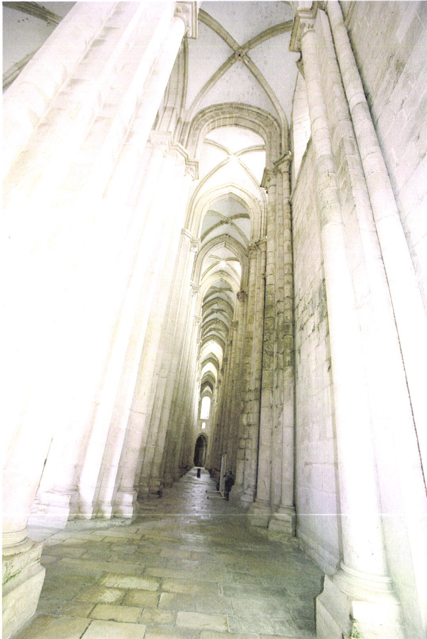
29. Interior da Igreja: nave lateral sul (estado actual)
