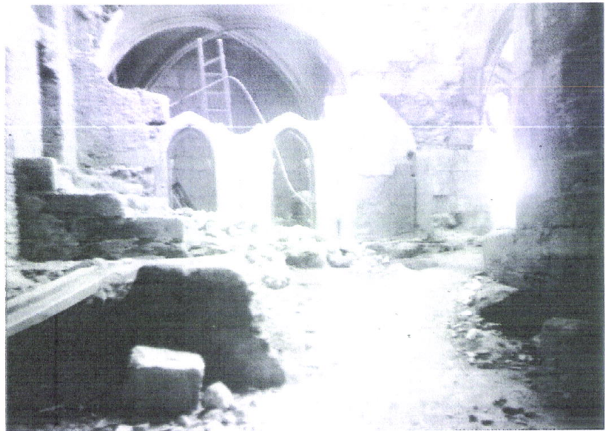
133. Parlatório: demolição das estruturas (Arquivo da DGEMN)
