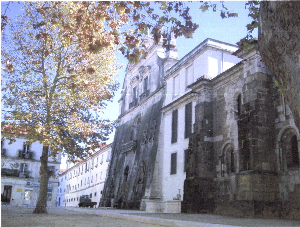
86. Fachada lateral norte do Claustro de D. Dinis
