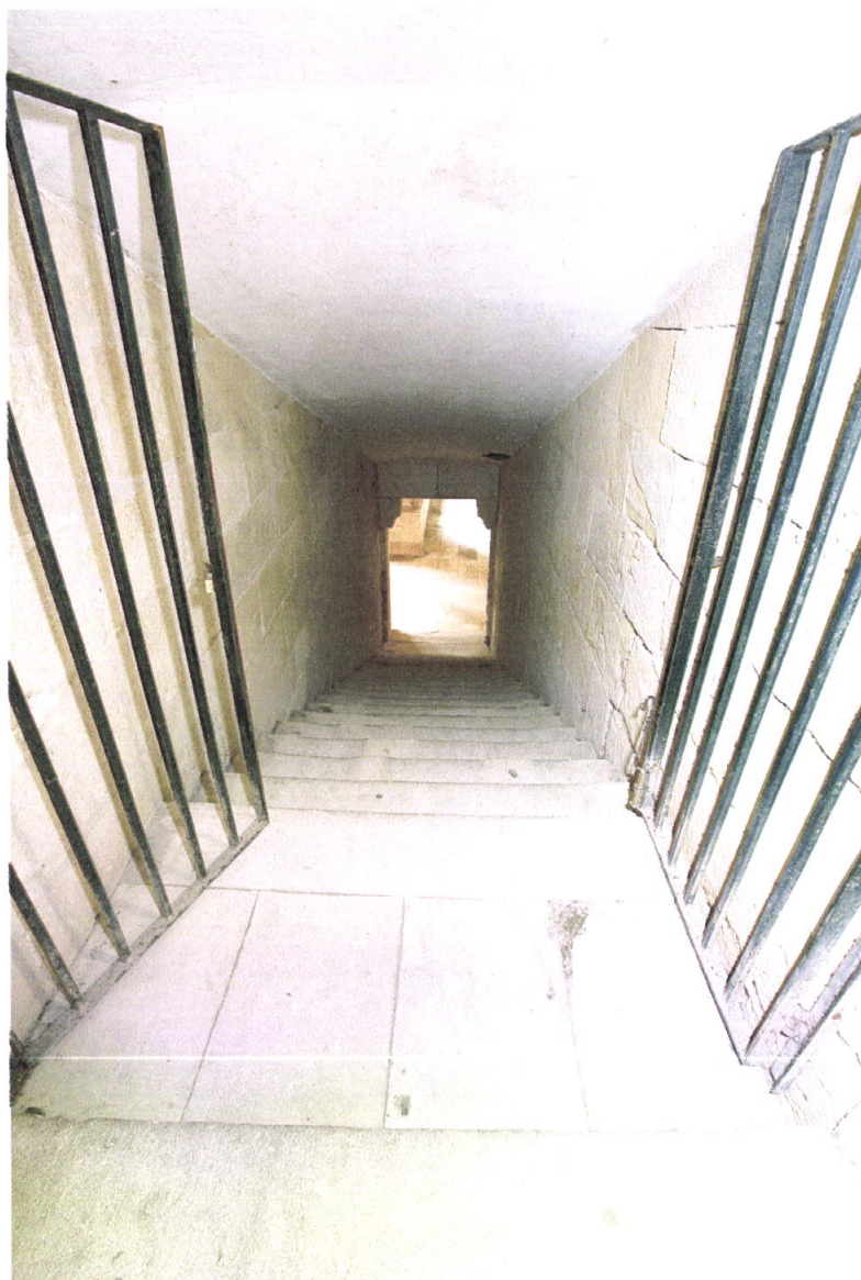
47. Escada de ligação entre o Dormitório e o Claustro de D. Dinis (estado actual)
