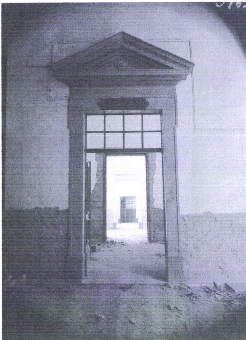
121. Obras no Dormitório: portas em cantaria das divisórias. (Arquivo da DGEMN)
