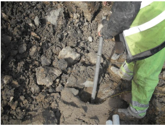
Verificação do comprimento do carregamento com uma vara
