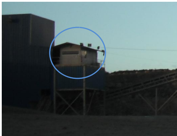
Figura 5.13 – Cabine de controlo ou posto de comando.
