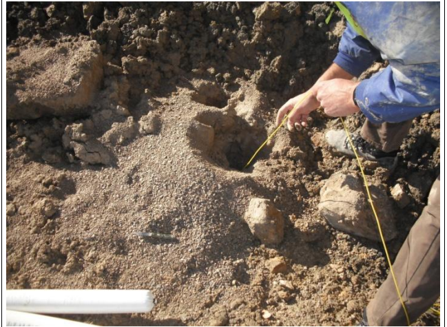
Colocação dos cartuchos nos furos
