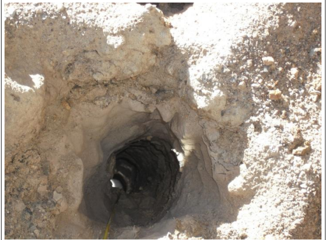
Concluído o carregamento até cerca de 1,5m da superfície
