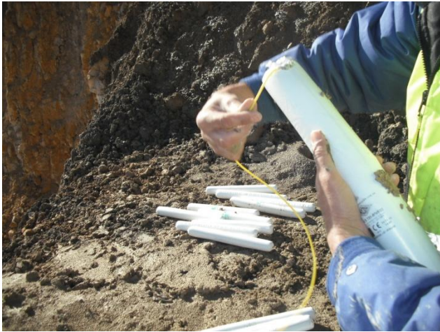
Escorvamento de um cartucho (Introdução do detonador no primeiro cartucho de emulsão da carga de fundo
