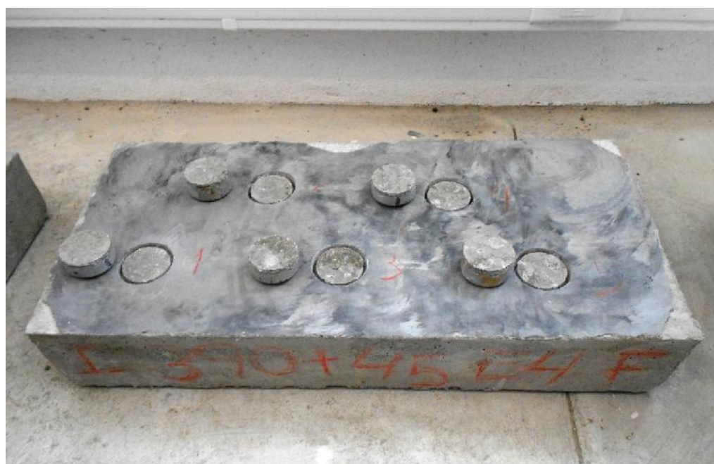
Figura 4.8 – Ruturas apresentadas pela lajeta C1E4 aos 8,5 MPa+45 min de resistência à penetração
