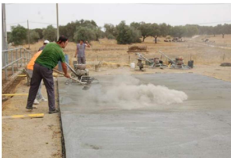
Figura 2.6 – Aplicação do endurecedor de superfície
