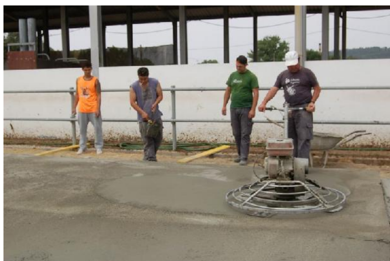
Figura 2.7 – Adição de água durante o processo de afagamento
