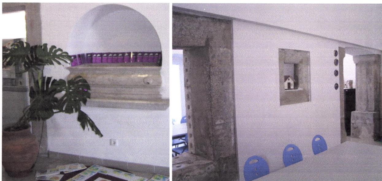
Figs. 3.84 e 3.85 – Portalegre: Mosteiro de Santa Clara. Lavatório de parede no acesso ao coro baixo e parede divisória na portaria, com vestígios de encaixe de grade.
