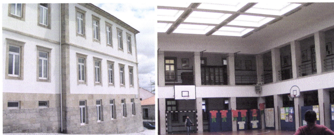
Figs. 4.23 e 4.24 – Guarda. Alçado sul e pátio do edifício actual (antiga localização do Mosteiro).
