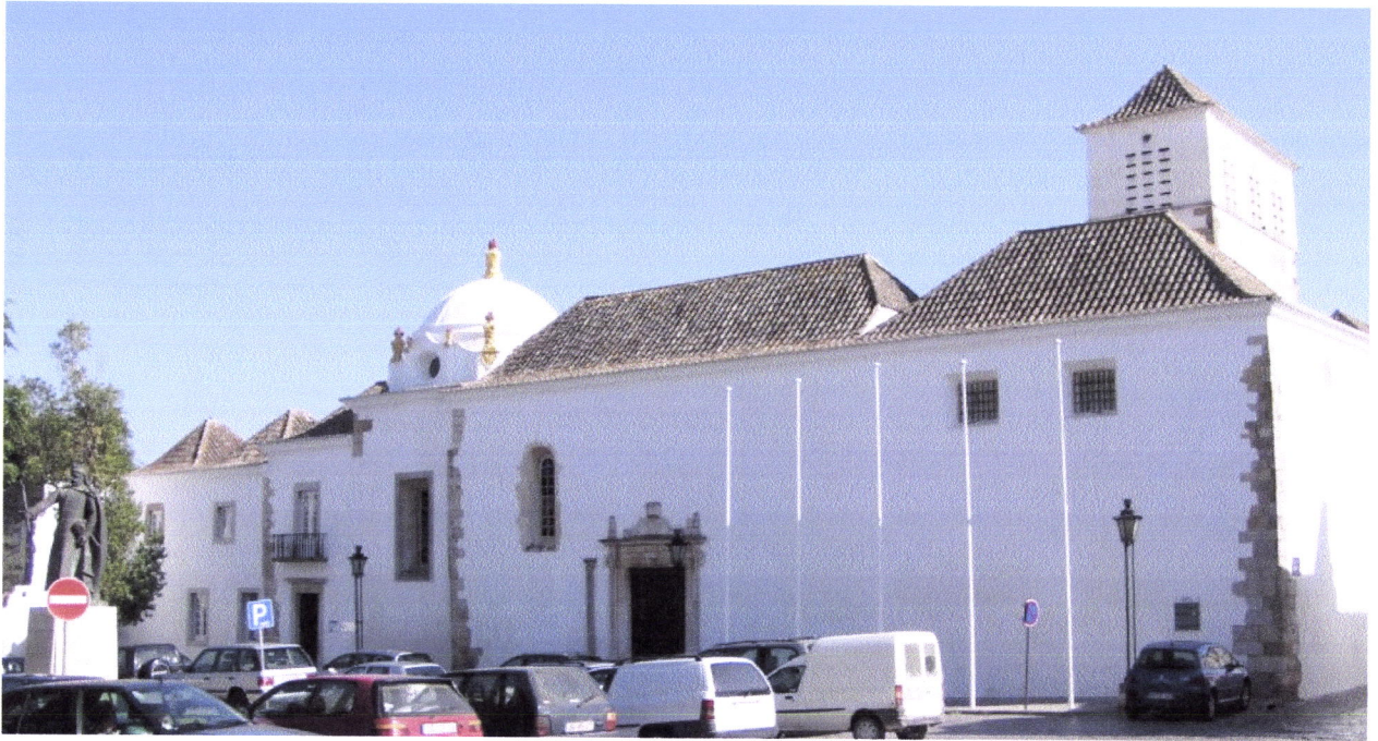
Fig. 3.255 – Faro: Mosteiro de Nossa Senhora da Assunção. Alçado norte com acesso à “igreja pública”, sendo visíveis os “telhados de tesouro”.
