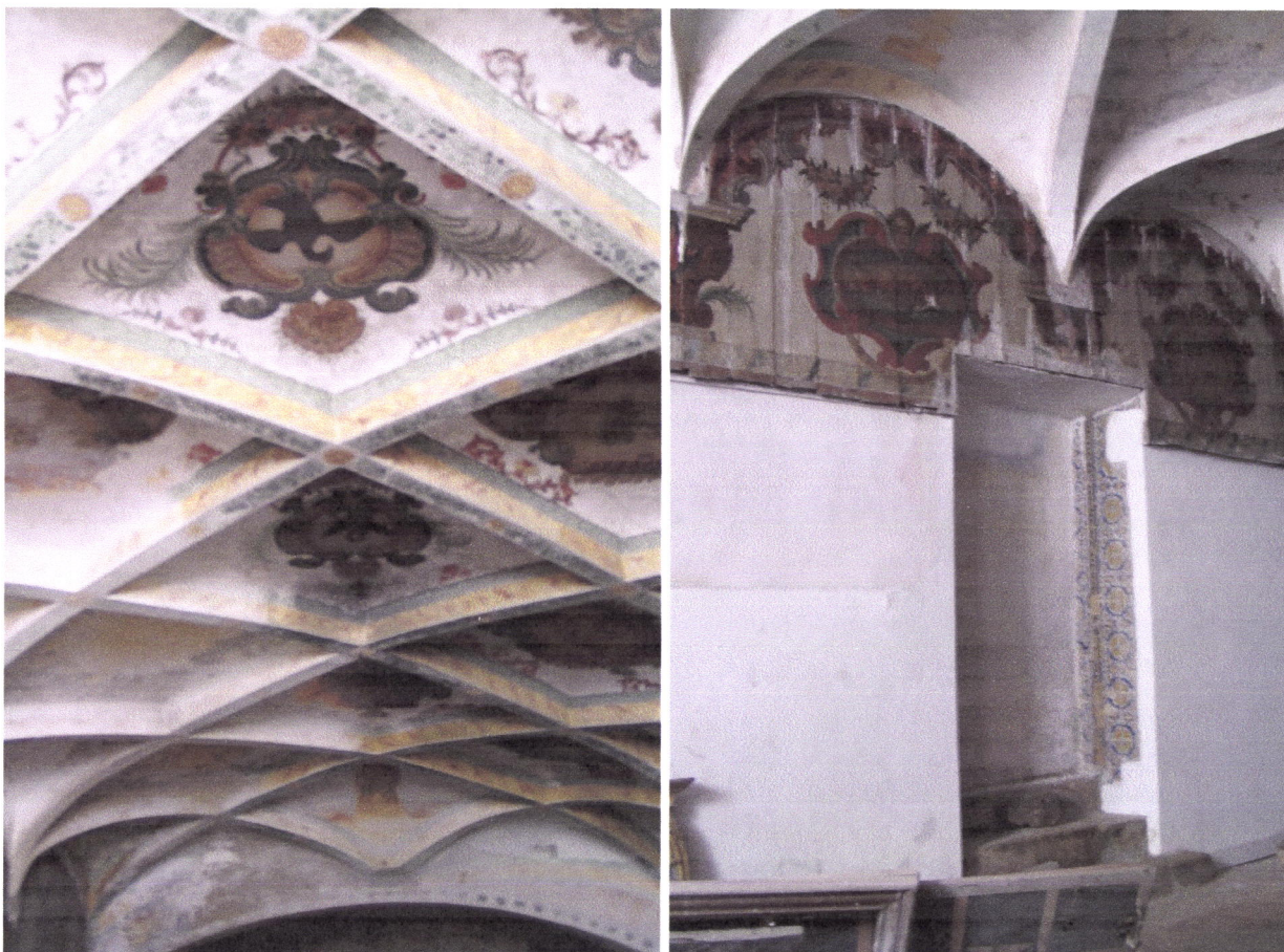
Figs. 3.125 e 3.126 – Évora: Mosteiro de Santa Clara. Cobertura abobadada do coro baixo e antiga passagem deste para as dependências regulares.
