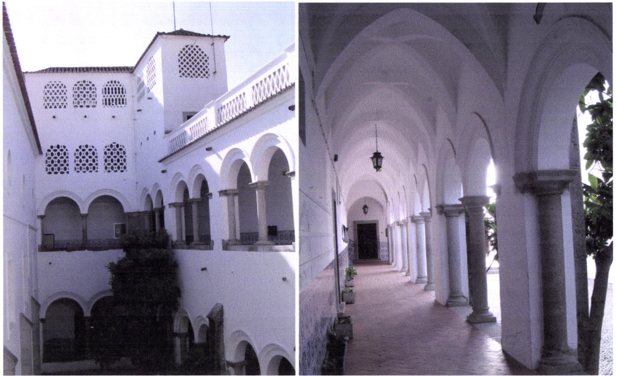
Figs. 3.122 e 3.123 – Évora: Mosteiro de Santa Clara. Corpos poente e norte e galeria norte do piso térreo do claustro pequeno.
