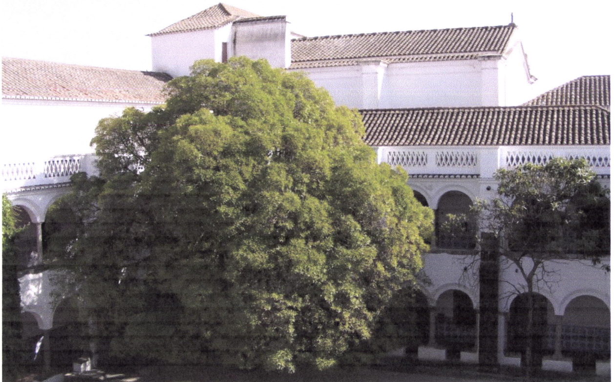
Fig. 3.117 – Évora: Mosteiro de Santa Clara. Corpo sul do claustro principal, sendo visível o corpo da igreja.
