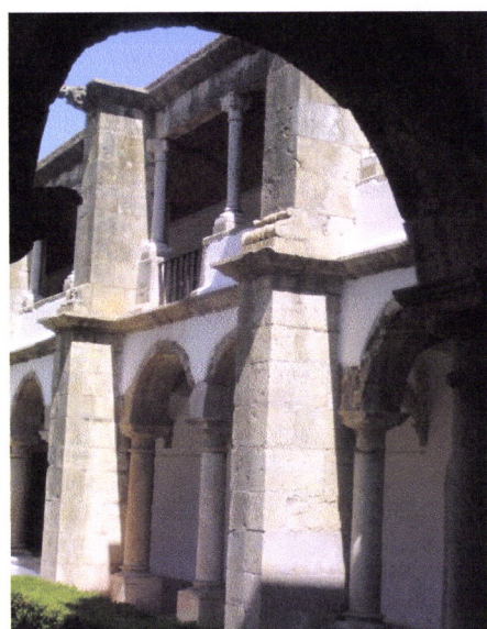
Figs. 3.262 a 3.264 – Faro: Mosteiro de Nossa Senhora da Assunção. Contrafortes e ângulos chanfrados.
