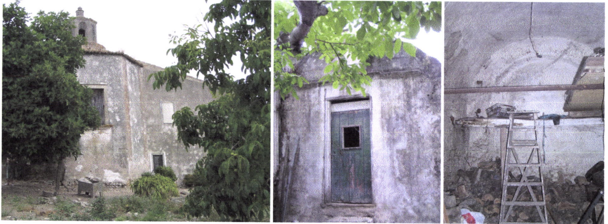
Figs. 4.72 a 4.74 – Alenquer. Antiga localização do Mosteiro. Aspectos da capela de planta octogonal, vista para norte, e da segunda capela, vista pelo exterior e pelo interior.
