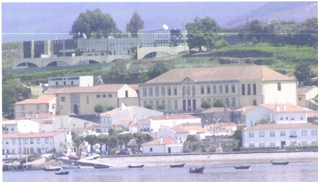
Fig. 4.80 – Caminha: Mosteiro de Nossa Senhora da Misericórdia. Vista geral, sendo visíveis os corpos da igreja e da sacristia, à esquerda, e o edifício construído no séc. XIX, à direita.
