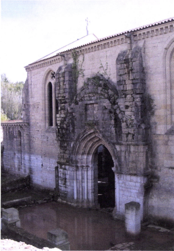
Figs. 3.30 e 3.31 – Coimbra: Mosteiro de Santa Clara. Aspecto do alçado norte, sendo visíveis o portal de entrada da “igreja pública” e os contrafortes no mesmo alçado.
