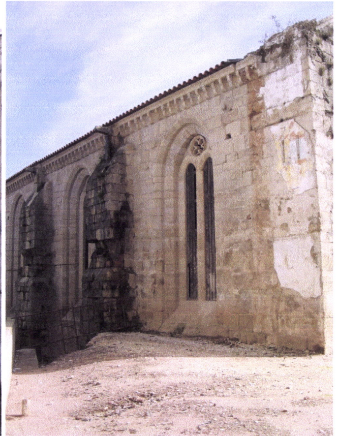
Figs. 3.30 e 3.31 – Coimbra: Mosteiro de Santa Clara. Aspecto do alçado norte, sendo visíveis o portal de entrada da “igreja pública” e os contrafortes no mesmo alçado.
