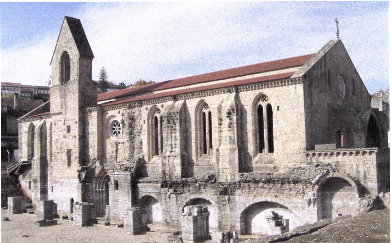
Fig. 3.29 – Coimbra: Mosteiro de Santa Clara. Vista do alçado sul da igreja, sendo identificável, pela diferença de coloração dos materiais, o nível de assoreamento.
