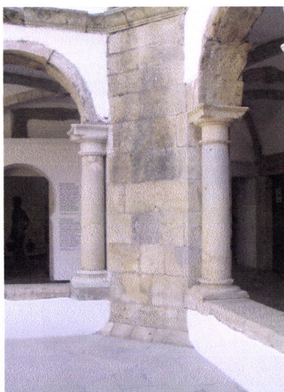
Figs. 3.262 a 3.264 – Faro: Mosteiro de Nossa Senhora da Assunção. Contrafortes e ângulos chanfrados.
