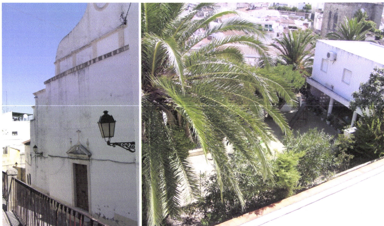
Figs. 4.51 e 4.52 – Elvas: Mosteiro de Santa Clara. Alçado poente da igreja, com entrada para a “igreja pública”, e local do antigo claustro.
