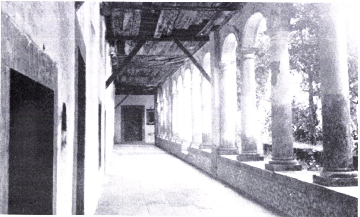
Fig. 3.2 – Santarém: Mosteiro de Santa Clara. Claustro demolido anos antes da intervenção da DGEMN, na década de 1940 (Foto: DGEMN).
