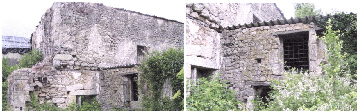
Figs. 4.30 e 4.31 – Sernancelhe: Mosteiro da Ribeira. Aspectos da construção contígua à igreja.
