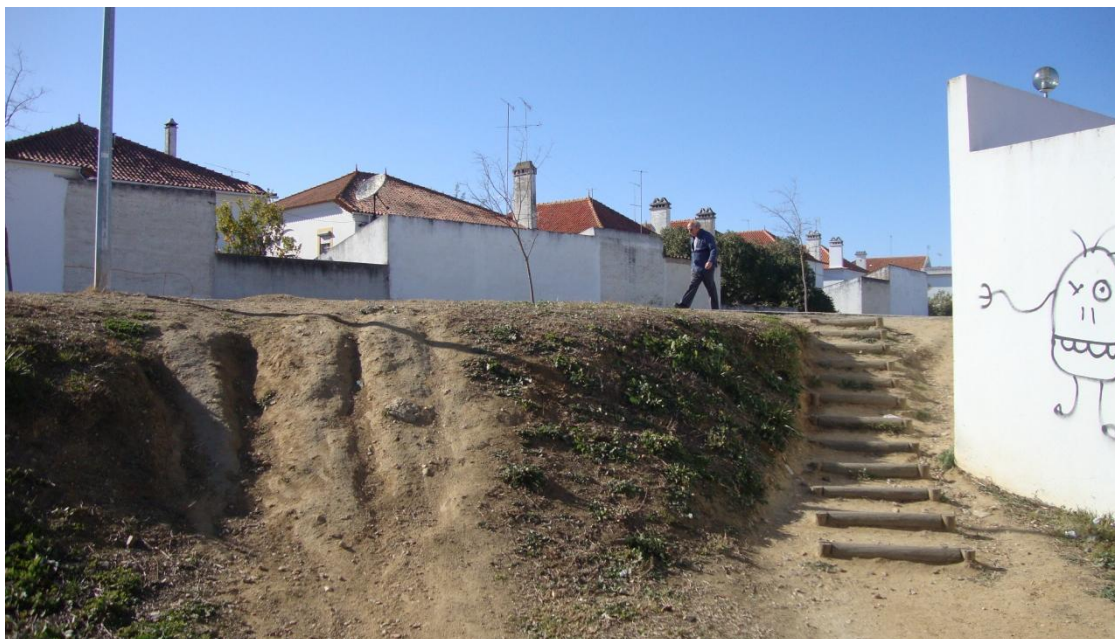
Fig. 90 Acesso existente à ecopista que se encontra mais próximo da escola
