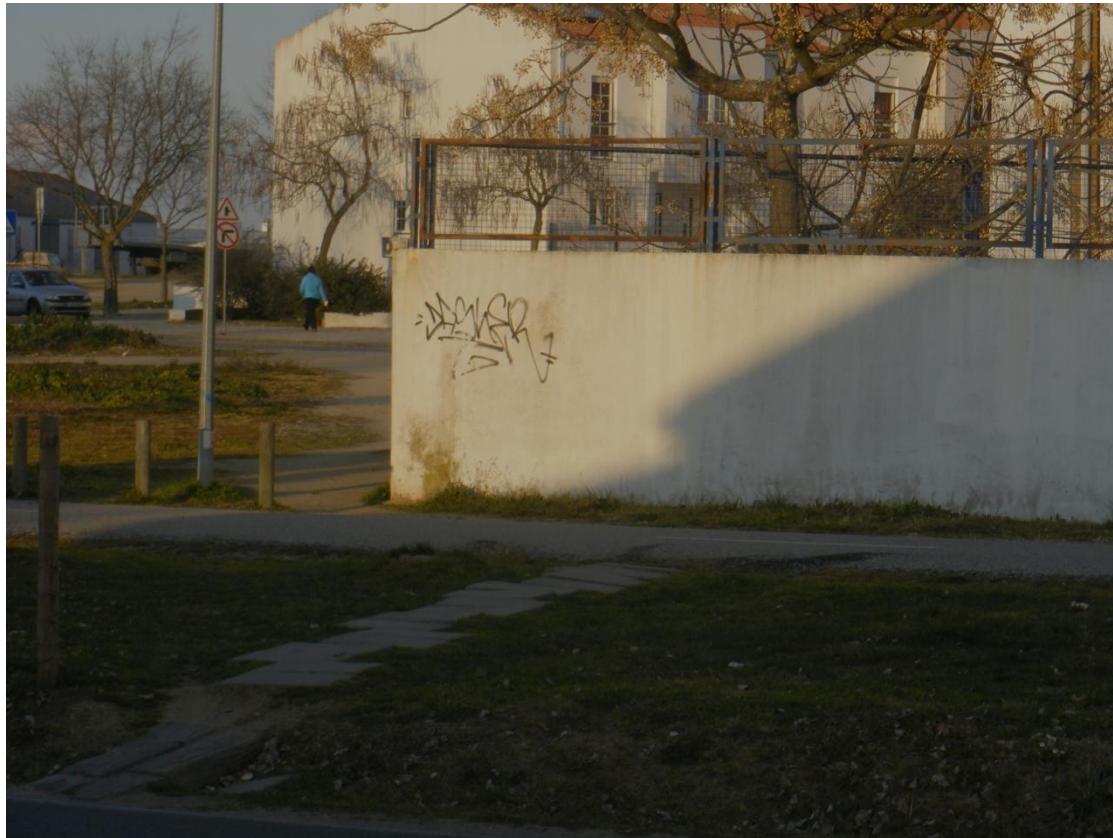
Fig. 72 Único ponto que se encontra minimamente formalizado, contudo, acaba na estrada municipal e não tem uma passadeira que dê continuidade a este acesso
