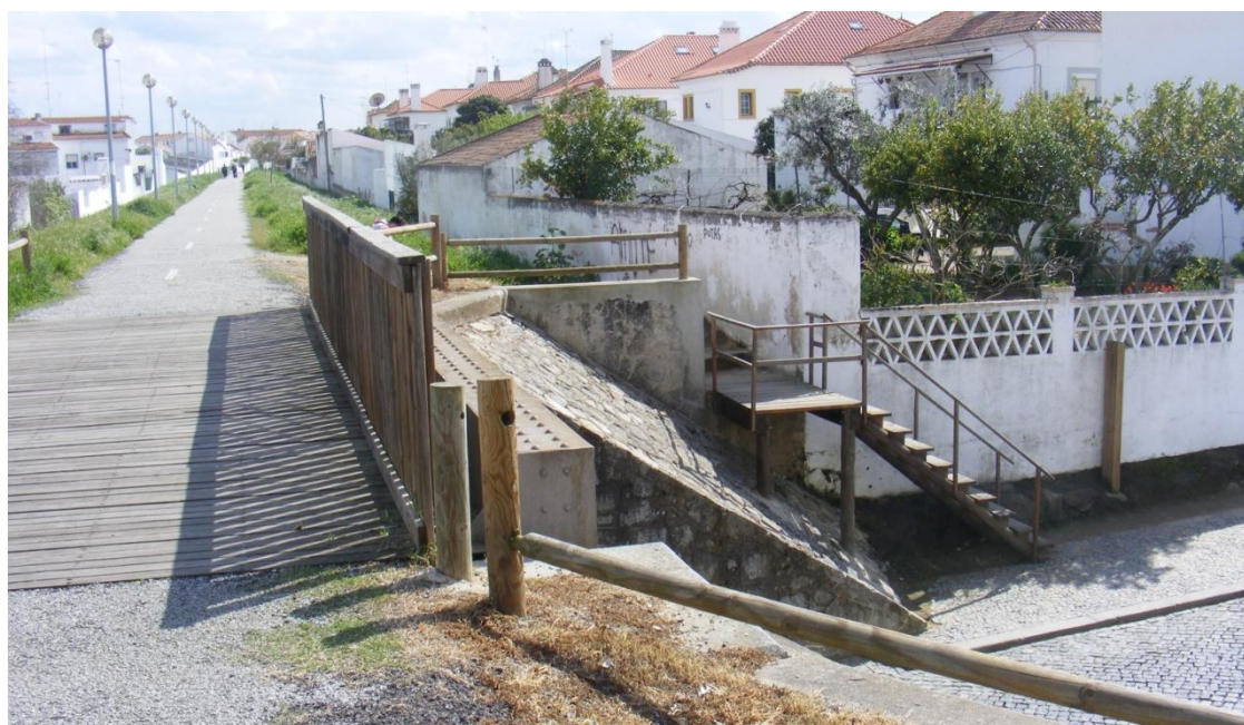
Fig. 40 Ponte de ferro, vista da ecopista para o bairro
