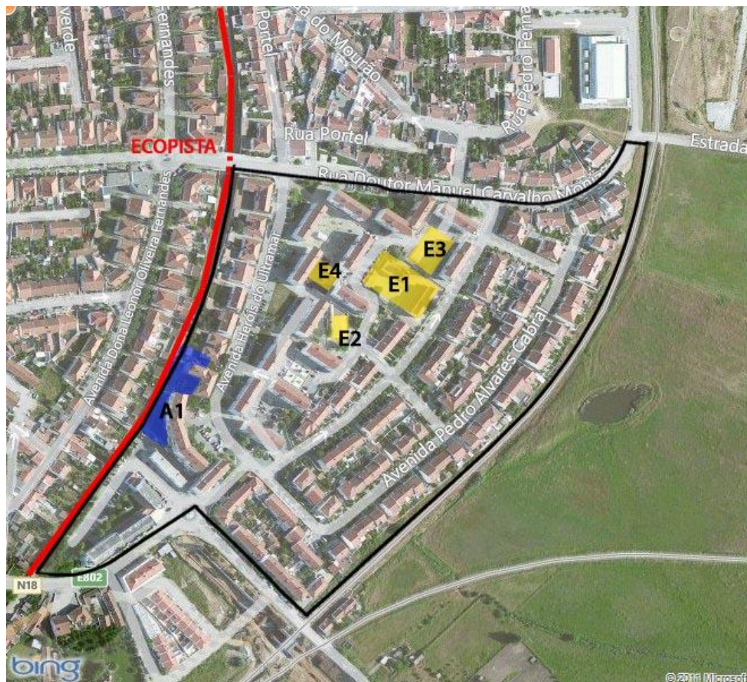
Fig. 55 Fotografia aérea com delimitação do bairro e identificação dos equipamentos (E) e acessos (A) existentes
