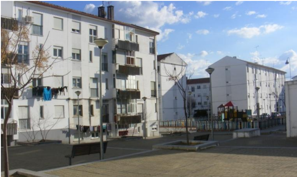
Fig. 56 Vista para o Parque Infantil, destaque ainda para a construção em altura
