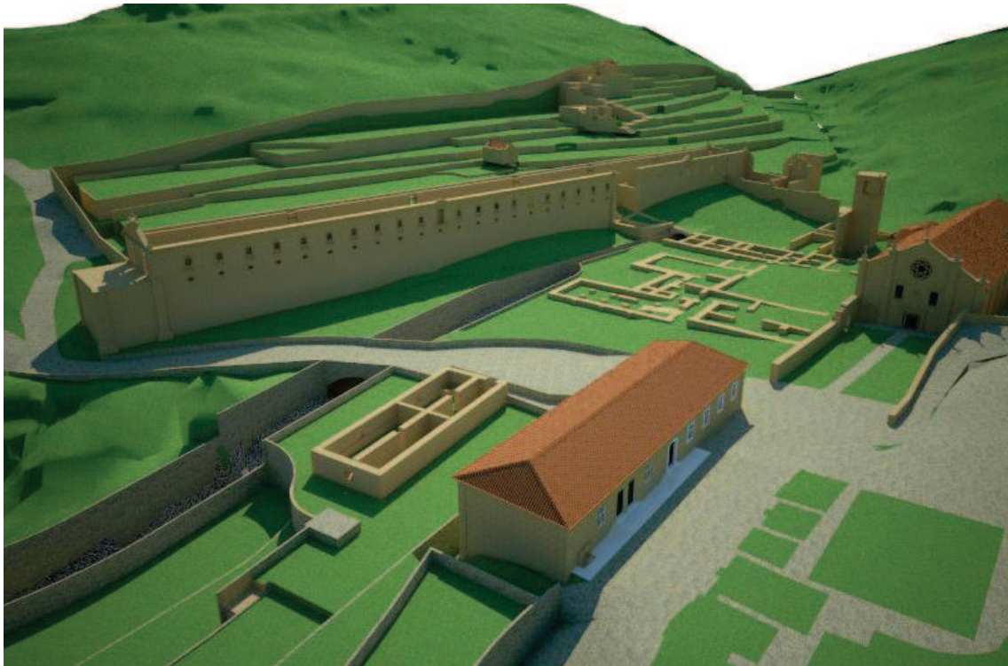
Figuras 7.2 – Vista aérea perspectiva Sudoeste. Como se verifica na figura, à excepção da igreja, o complexo medieval foi praticamente todo desmantelado. Os dormitórios dos séculos XVII e XVIII também sofreram desmantelamento, mas como é visível foi menos acentuado, sendo mesmo que o dormitório do século XVIII se encontra quase intacto no seu exterior. A igreja e respectiva sacristia, as tulhas, as capelas de São António e de Santa Umbelina com as suas escadarias, tanque e fonte; a torre sineira; e o sistema hidráulico; graças à intervenção arqueológica foram restauradas e/ou reconstruídas.
