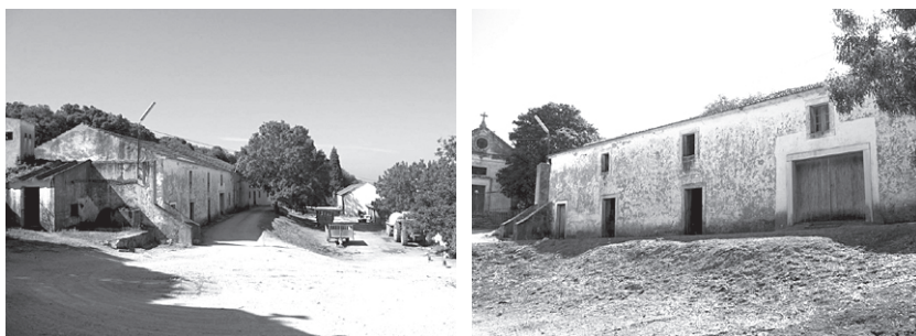
Figs. 25 e 26 – Fotografias do edifício do lagar.
