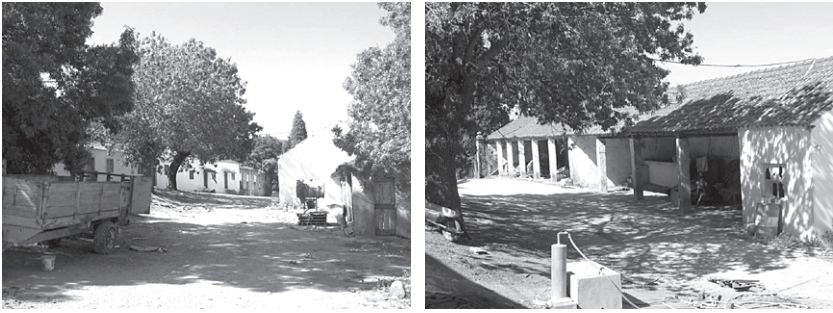
Figs. 27 e 28 – Fotografias dos edifícios destinados a armazéns de várias naturezas.
