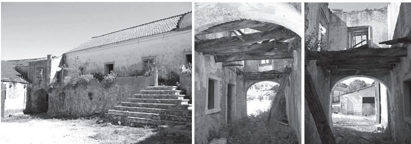
Figs. 11, 12 e 13 – Acesso ao edifício n.º 3 do conjunto da Quinta de Val de Ventos.
