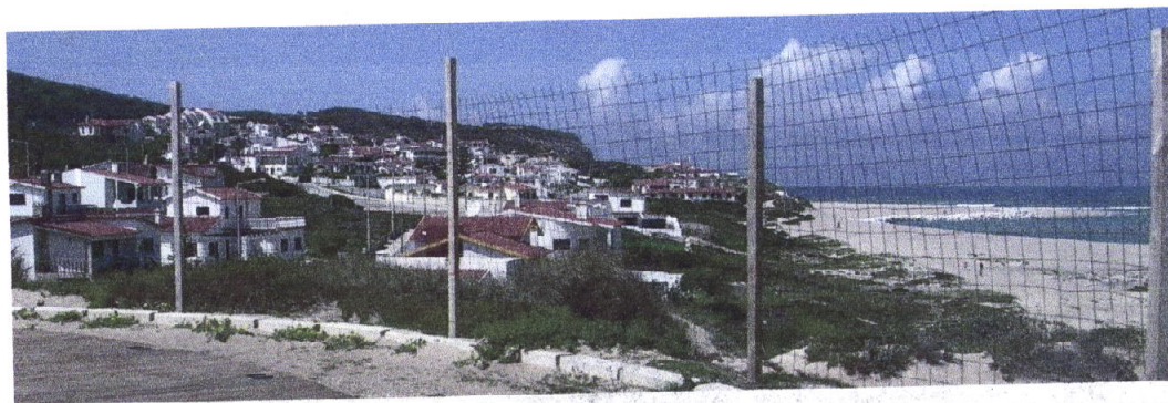
Figura 2.6.4 – Dunas no Bom Sucesso, margem sul da Lagoa de Óbidos, ocupadas por construção. Fotografia tirada a 3-4-2005.
