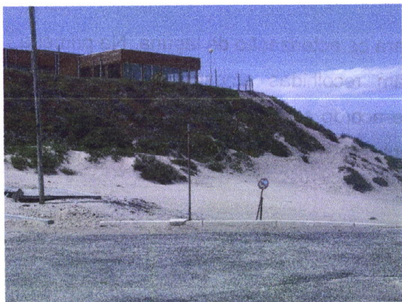
Figura 2.9.1 – Restaurante semi-construído e embargado, sobre a duna na praia do Bom Sucesso na margem Sul da laguna; 3-5-04.
