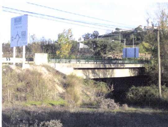
Fig. 24 Ponte vista para montante. (Outubro 2004)
