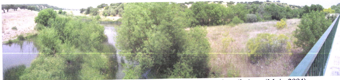
Fig. 24 Alargamento do leito visto da ponte sobre a junção das ribeiras. (Maio 2004)
