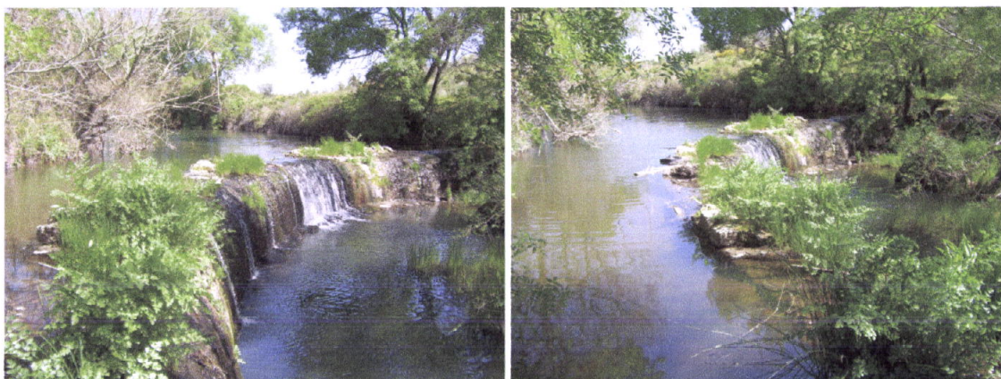
Fig.30-31 Dois olhares sobre o açude na primavera; na segunda imagem nota-se o resto de parede por baixo de muro em arco. (Maio 2004)
