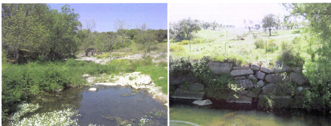
Fig.35-36 Contraste entre a forma de leito natural e com a ‘reparação’ após a passagem de gasoduto. (Maio 2004)
