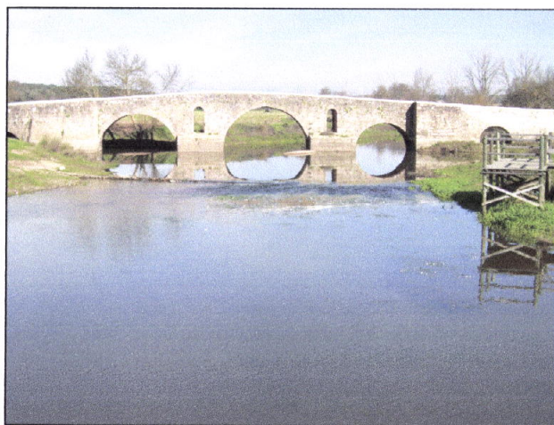
Fig. 3 vista de alçado da ponte a montante. (Junho 2004)
