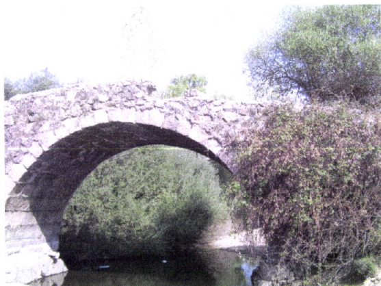
Fig. 10 Cantaria da ponte (Junho 2004);
