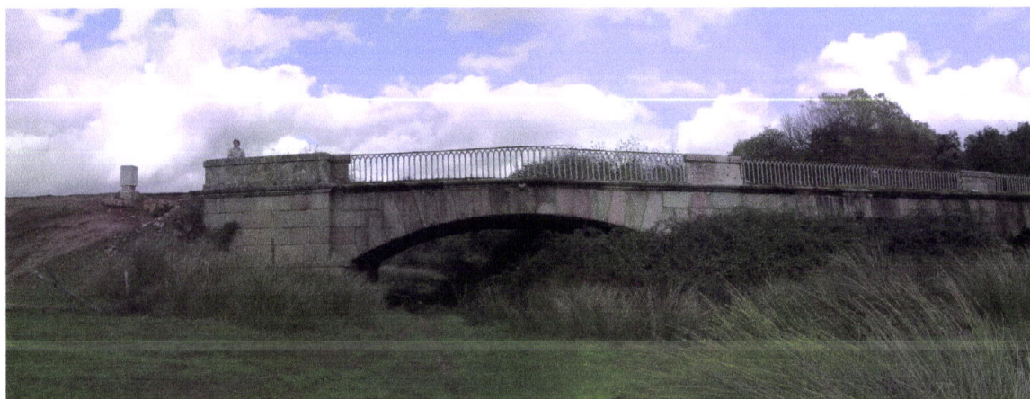
Fig. 27 Vista panorâmica da ponte, face oeste. (Março 2004)
