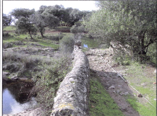
Fig. 13 pormenor da construção da ponte; fotografado levantamento arquitectónico. (Novembro 2003)
