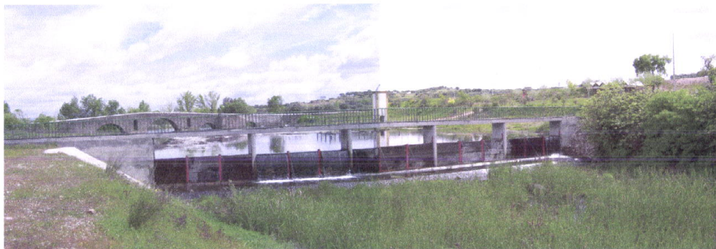
Fig.5 Paredão visto para montante. (Abril 2004)
