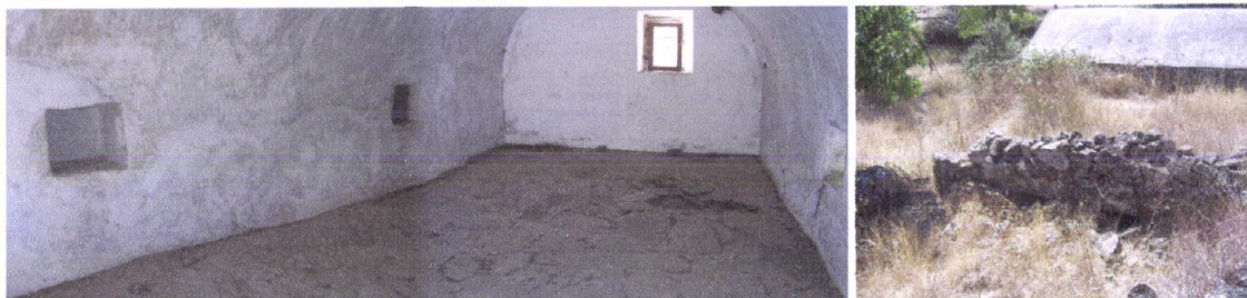
Fig.19-20 Interior da casa, adaptada da construção do moinho; as janelas cegas provavelmente nos sítios de entrada de água para os rodízios, as seteiras na saída do tanque para o moinho, visíveis na segunda imagem.
