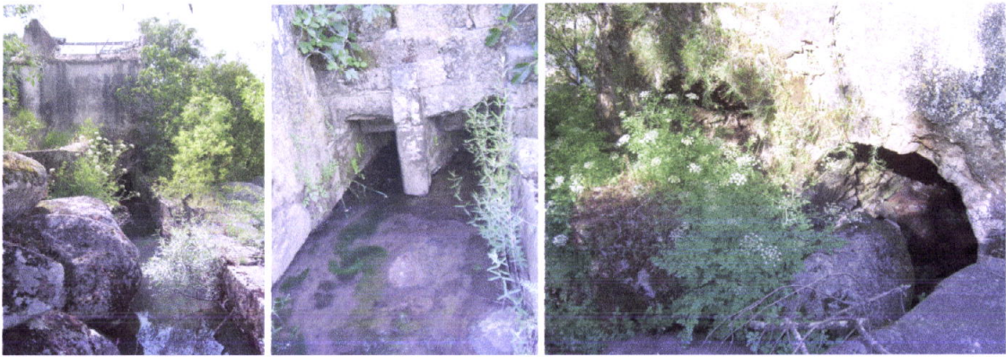
Fig.83-85 Os engenhos do moinho: o canal (levada), a entrada de água para o moinho duas “portas” (seteiras) e saída pelos dois arcos (enxogadouro) hoje sombreado pelos freixos e coberto por vegetação vivaz. (Junho 2004)
