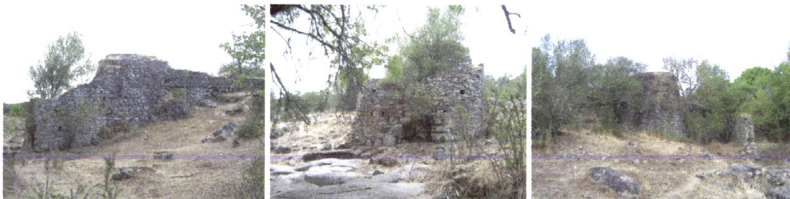
Fig.105-107 vista de norte; vista de nascente; vista de sul. (Agosto 2004)
