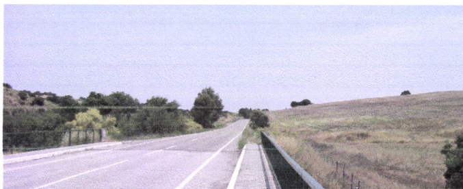
Fig. 17 Fim da área de estudo, vista a montante da ponte de Almuro; vale aberto e com pouca vegetação do lado sul. (Junho 2004)
