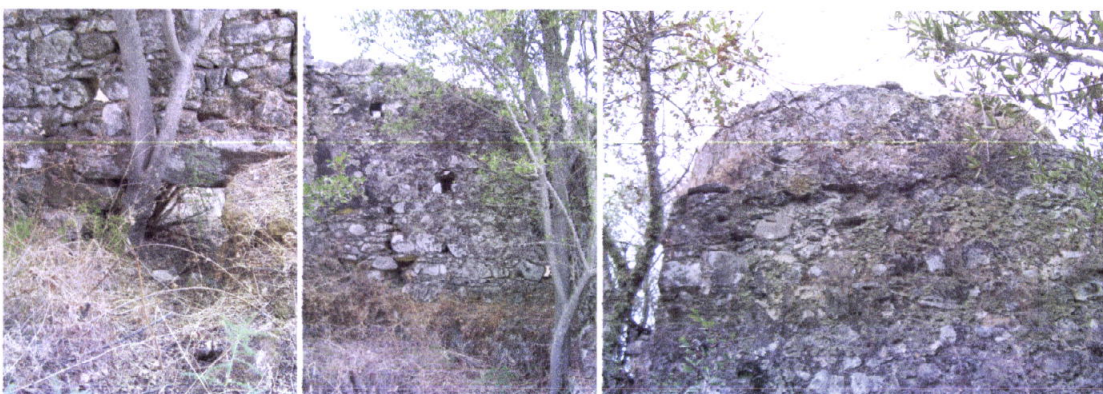
Fig.96 Saída de água do moinho;
