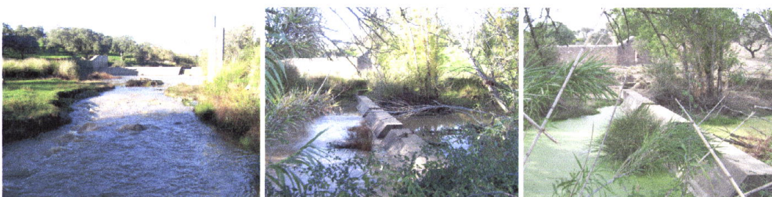
Fig.11 Vista de represa a montante com torre de medição. (Janeiro 2004)
