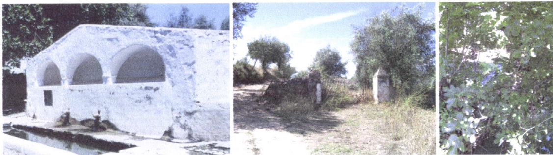
Fig.21 A fonte em pleno sol de verão com forte caiação. (foto GTL Monforte 2001)
