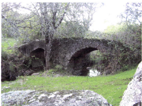
Fig.18 Vista para montante. (Dezembro 2003)
