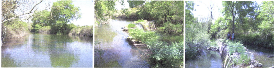
Fig.1 Quantidade de água retida pelo açude na primavera; Fig.2 Arco do açude coberto de vegetação; Fig.3 Vista para a parte donde saia o canal para o moinho de Monte dos Moinhos.
