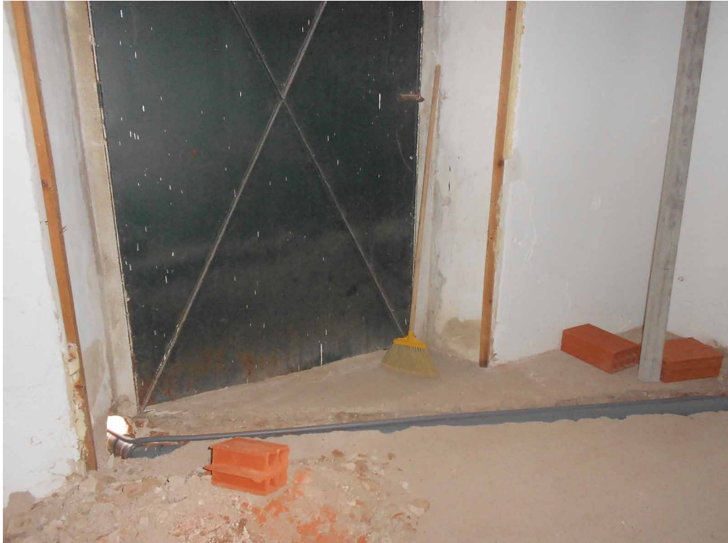
Fotos nº 6 e 7 – Obras a decorrer nas instalações.
