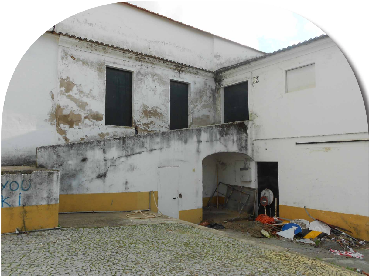
Foto nº 9 - Aspeto da fachada exterior do edifício antes das obras de melhoramento
