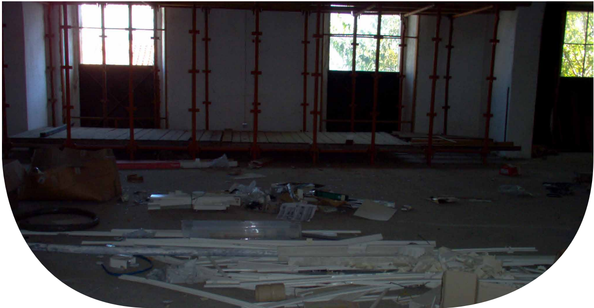
Foto nº 8 - Interior das instalações antes das obras de melhoramento.
