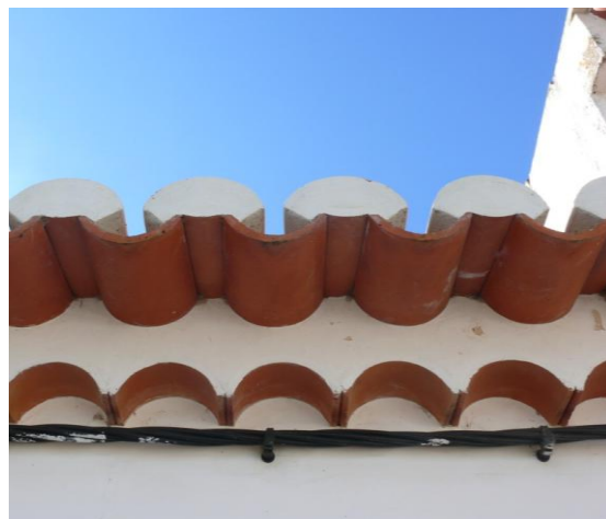
Fotografia 18 – Detalhe das telhas de um edifício na Zona histórica, Vila de Aljezur, 08.10.2012. Autoria: Mónica Viegas
