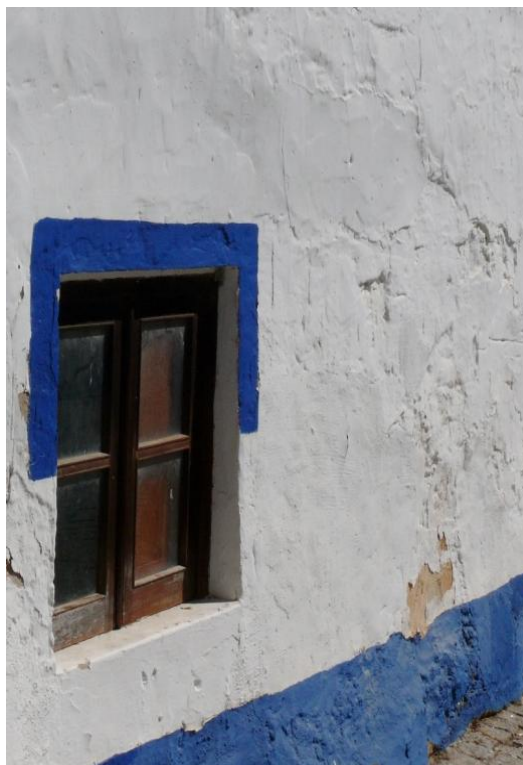
Fotografia 59 – Detalhe paredes caídas de um edifício no centro da vila de Odeceixe, 28.09.2012. Autoria: Mónica Viegas
