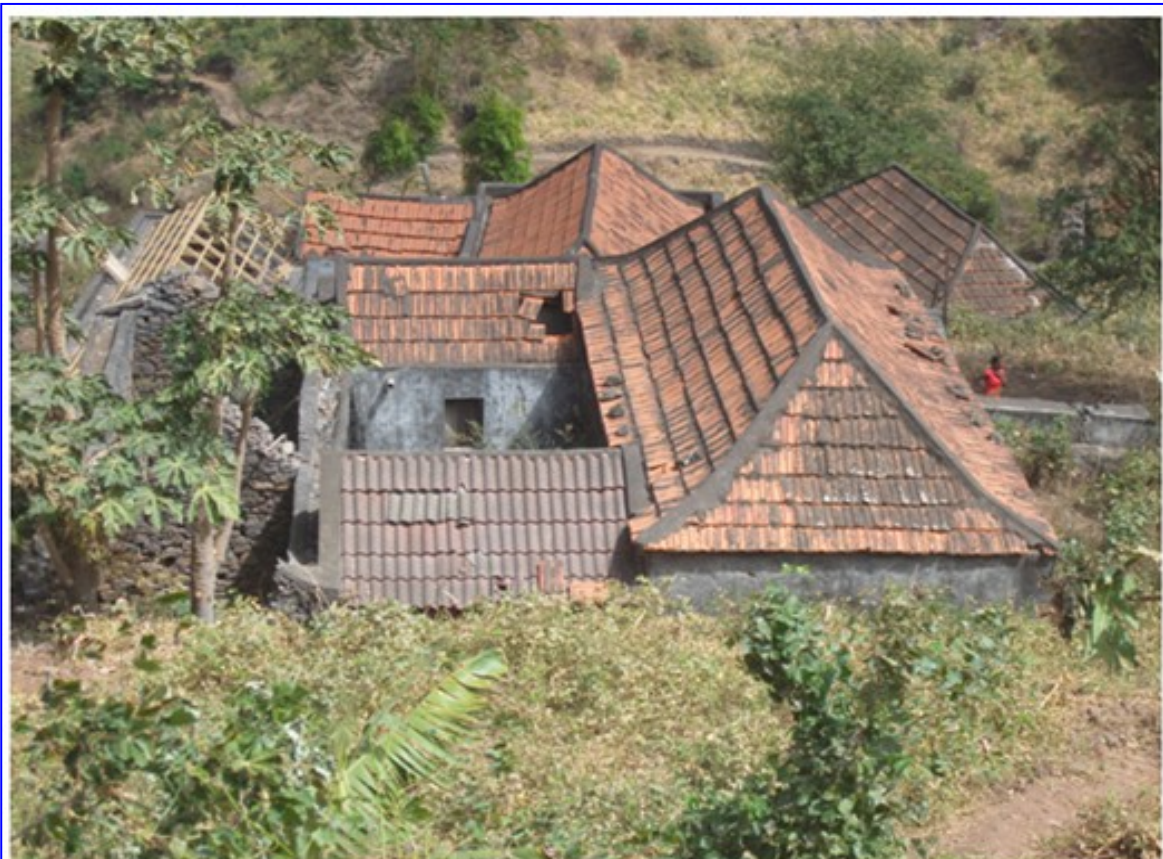
Figura – 003 – Exemplo de uma casa, planta retangular e, cobertura de quatro águas – Lagoa, Concelho de Tarrafal. Fonte: José Landim, Junho 2012.
