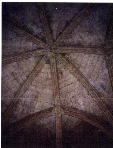
Figura 90 - Interior da sala do 2º piso da Torre de Menagem: abóbada de cruzaria de ogivas
