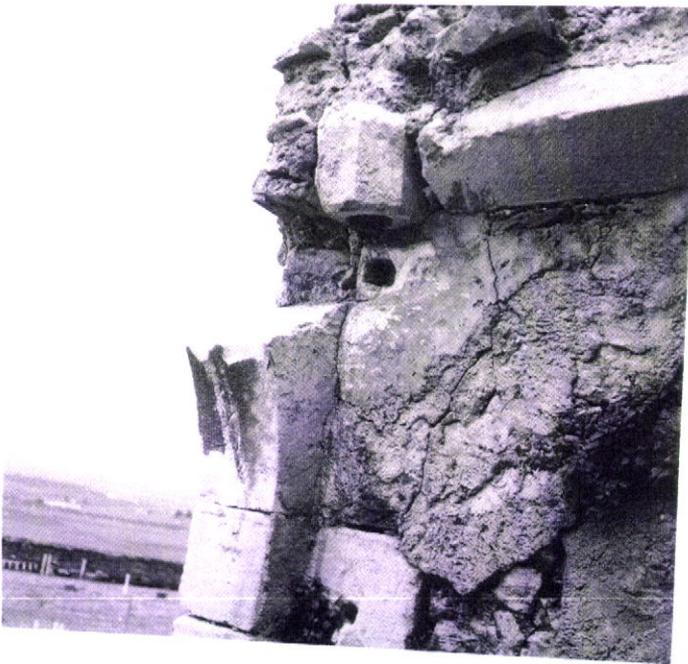
Figura 147 – Fortificações de Estremoz. Cerca urbana medieval. Pormenor do arranque do arco da Porta da Ladeira, depois da derrocada (25/05/1981) (DREMS 19799)
