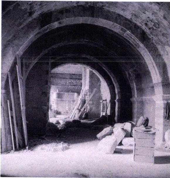
Figura 62 – Adaptação da cisterna a cozinha
