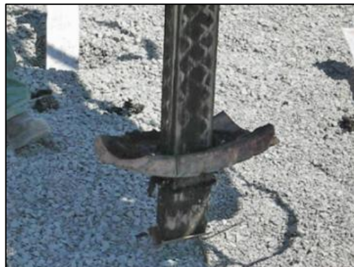
Figura 6 – Cravação dos drenos verticais pré-fabricados no solo com mandril de aço (imagem retirada de http://www.solotrat.com.br )
