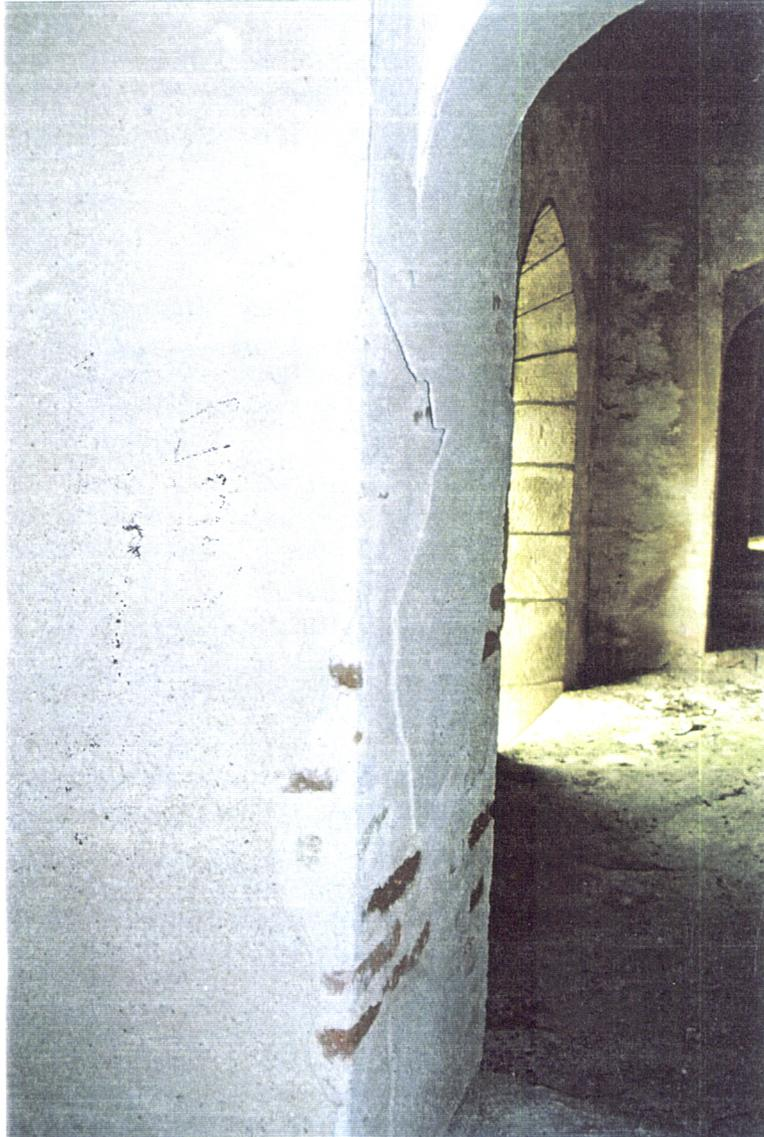
Fig. 9.30 – Igreja de S. Francisco de Évora. 4º tramo da galeria Norte: reboco em fase de destacamento no arco de ligação com o tramo seguinte
