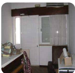
Figura 47 - Aspeto geral da receção antes da intervenção
