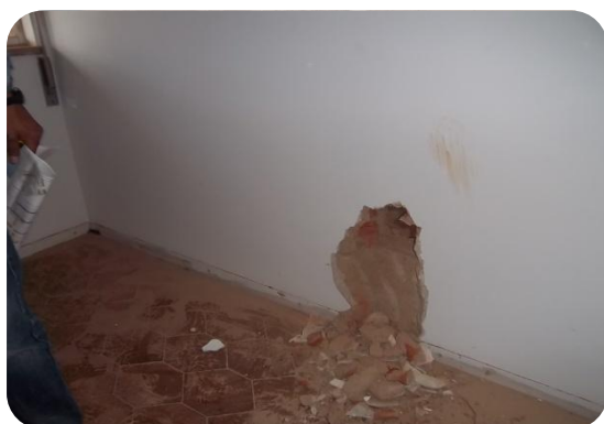
Figura 69 - Trabalhos de demolição da parede
