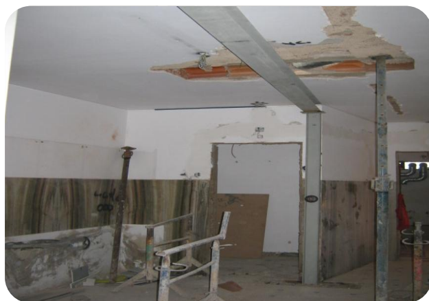
Figura 58 - Estrutura de reforço adotada
