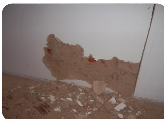
Figura 70 - Trabalhos de demolição da parede
