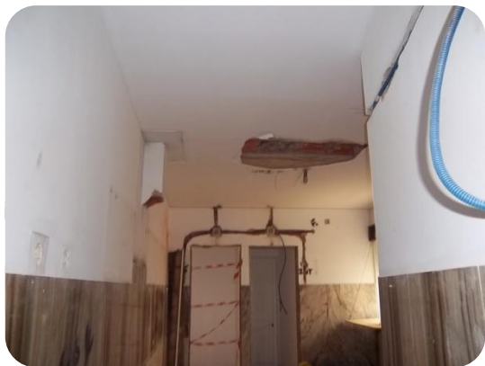
Figura 52 - Laje do teto da cozinha da cave
