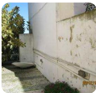
Figura 41 - Aspeto geral do acesso ao pátio ao nível da cave
