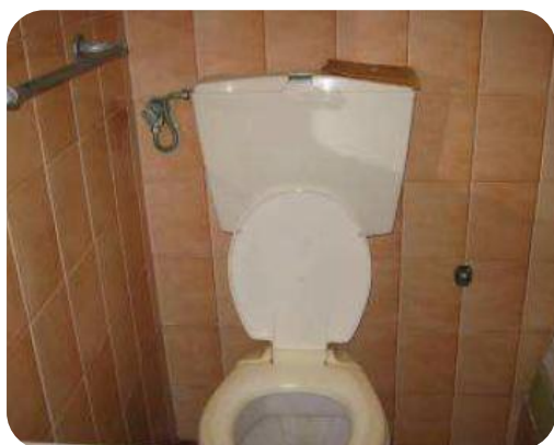
Figura 61 - Sanita da Instalação Sanitária 2 - Cave
