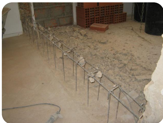
Figura 71 -Viga destruída
