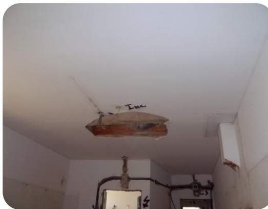
Figura 53 - Laje do teto da cozinha da cave
