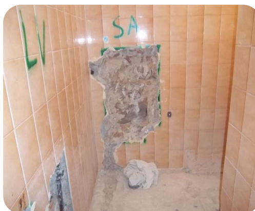
Figura 64 – Parede da Instalação Sanitária 2 - Cave
