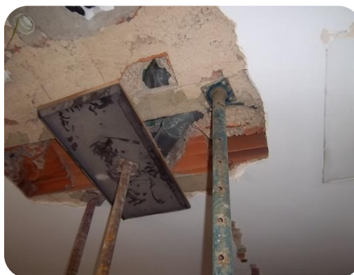
Figura 55 - Reforço provisório adotado
