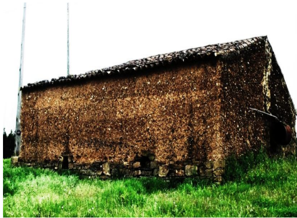
Figura 5.1 - Construção tradicional em taipa sem aplicação de revestimento, Silves
