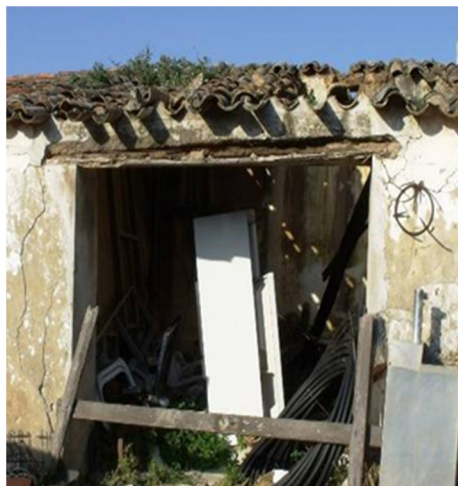
Figura 6.29 - Lintel de reforço em madeira (1).
