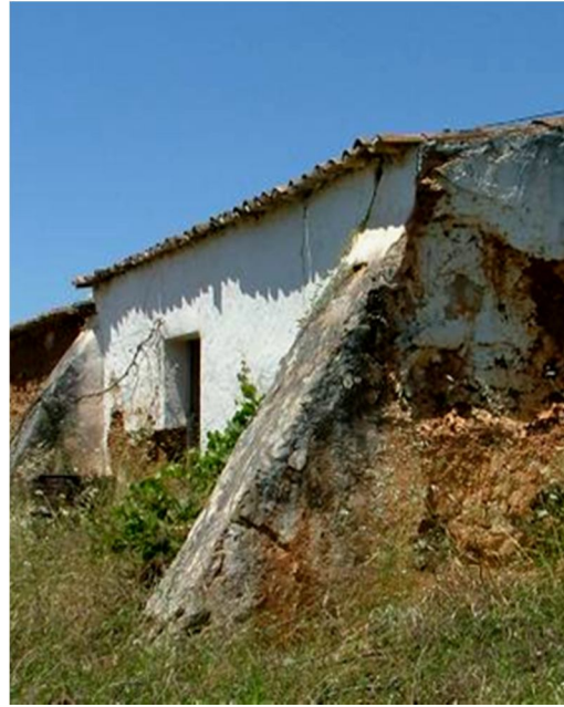
Figura 6.24 - Contrafortes e poiais em paredes de fachada
