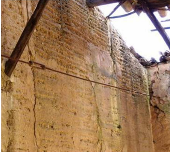
Figura 6.19 – Elementos metálicos - tirantes
