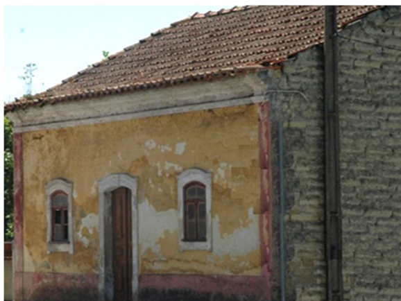
Figura 2.10 – Construção em adobe rebocada na fachada principal
