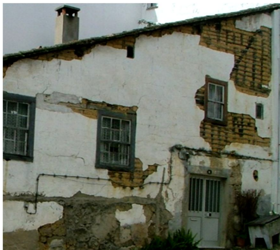
Figura 2.12 - Parede de tabique
