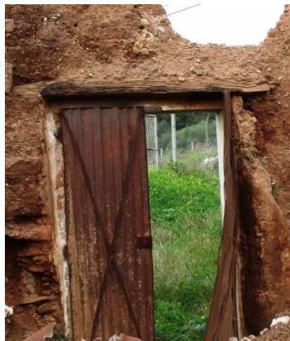
Figura 6.30 - Lintel de reforço em madeira (2).
