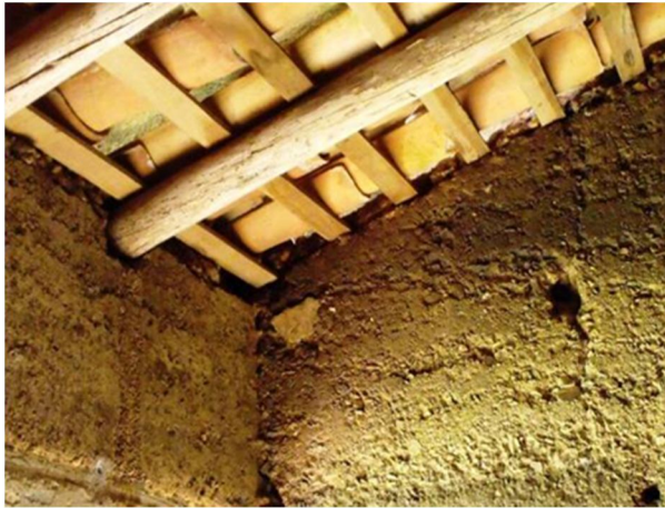
Figura 6.12 - Estrutura da cobertura com ripado de madeira
