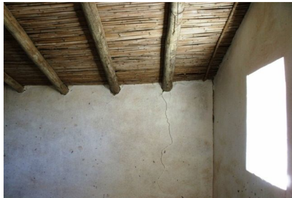
Figura 2.5 - Forro do telhado em esteira de cana
