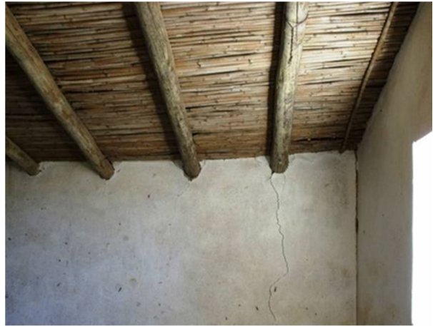
Figura 6.13 - Estrutura da cobertura com esteira de cana
