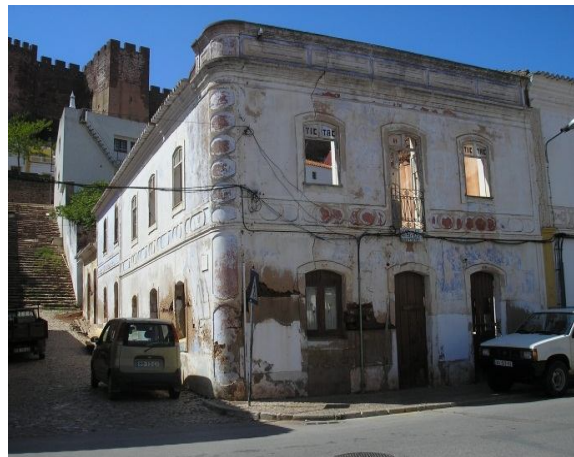
Figura 5.3 - Construção em taipa de dois pisos
