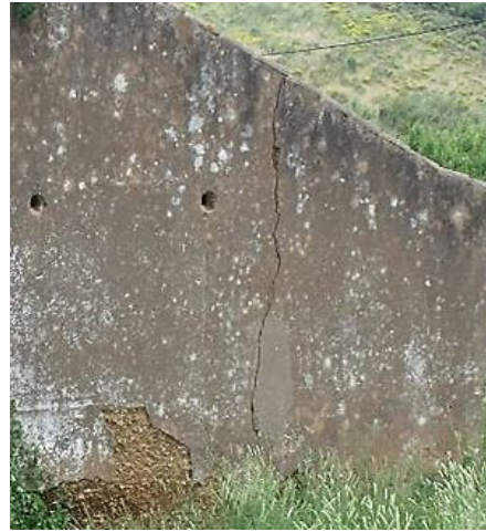
Figura 6.37 - Fissura vertical
