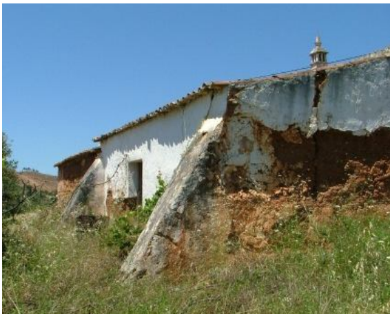
Figura 5.2 - Construção em taipa de um piso
