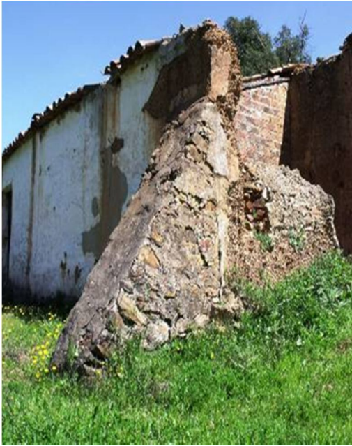
Figura 6.23 - Contraforte em parede de fachada
