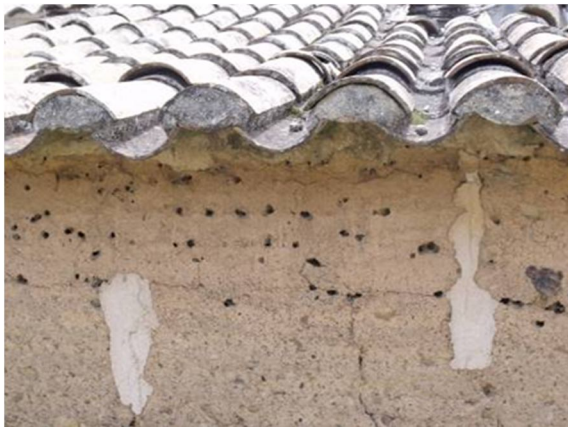
Figura 6.41 - Ataque de insectos na zona sob o beirado
