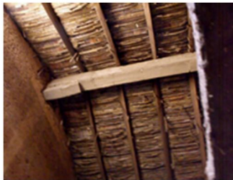
Reforço na cumeeira
