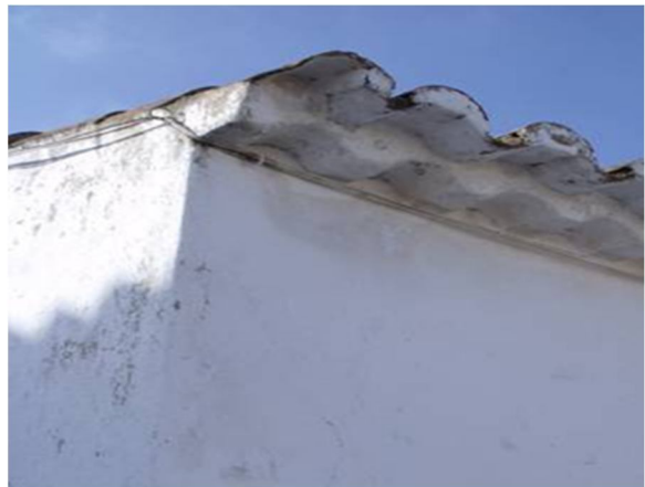
Figura 6.15 - Novo pormenor de beirado
