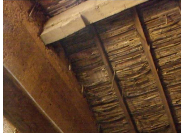
Figura 6.27 – Viga para reforço na zona da cumeeira
