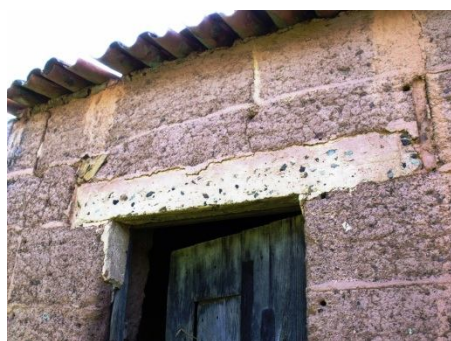
Figura 6.32 - Lintel de reforço em terra, cal e pedras (2).
