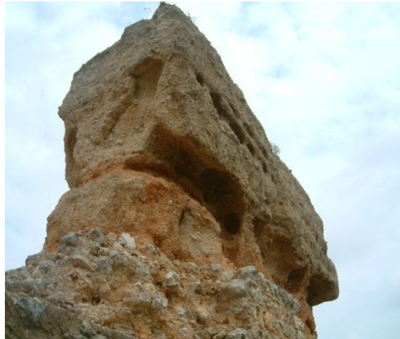
Figura 2.7 - Pormenor da espessura das paredes do Castelo de Paderne
