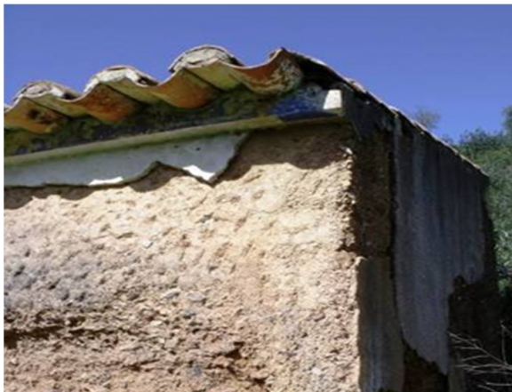
Figura 6.14 - Pormenor de beirado saliente na cobertura
