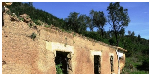
Figura 2.4 - Lintéis de reforço sobre os vãos
