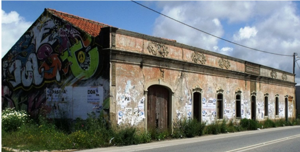
Figura 5.6 - Construção em taipa rebocada, com caiação a cor e elementos decorativos na fachada
