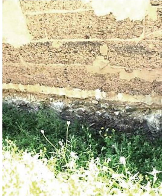
Figura 6.7 - Pormenor do embasamento
