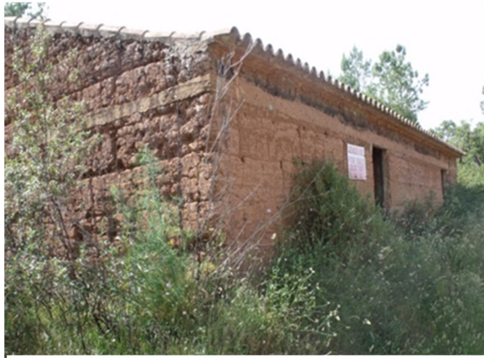
Figura 5.4 - Construção em taipa com um piso, sem qualquer tipo de revestimento
