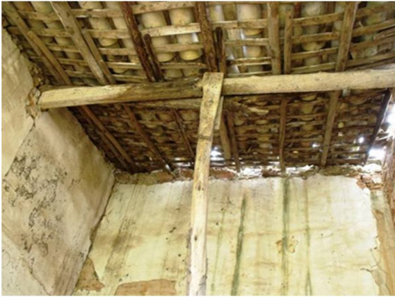
Figura 6.26 – Parede mestra na zona central do telhado
