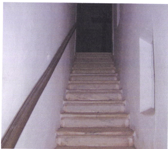
Figura 10 – Escada de acesso ao coro alto
