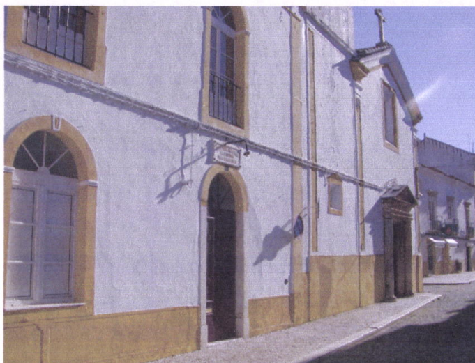
Figura 40 – Fachada do antigo espaço conventual e da Igreja de Santa Cruz
