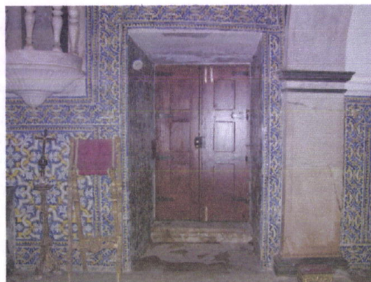
Figura 21 - Porta lateral de acesso à nave central
