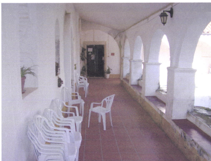
Figura 7 – Aspecto geral do Corredor Claustal superior (instalações da Sociedade Artística Calipolense)
