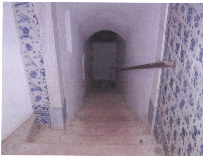
Figura 41 – Escadaria de acesso ao coro alto
