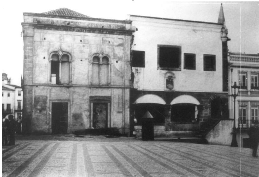
Figura 1 - Fotografia da Cadeia Civil de Évora, identificável pelo brasão do pelicano de D. João II, à direita da Cadeia estava o edifício dos Paços do Concelho 99
